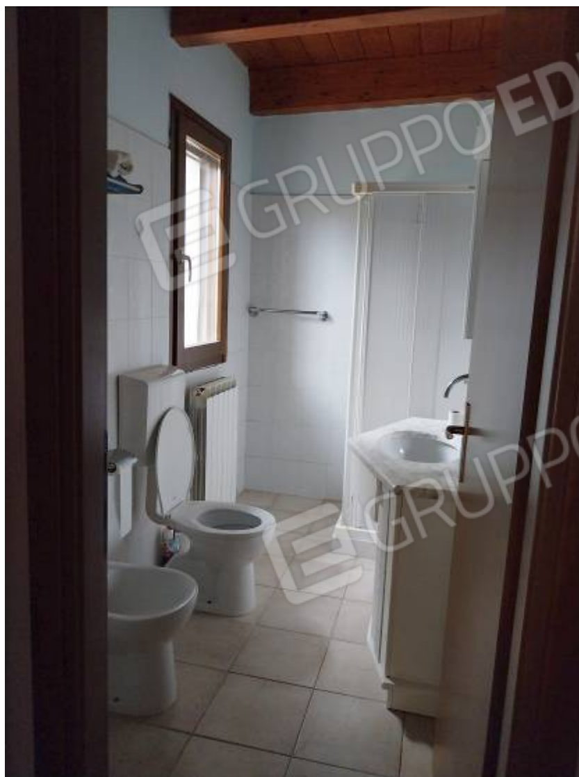
Foto 38 - Vista interna dell'edificio "F" (Fg. 90 map. 157 sub. 5), bagno
