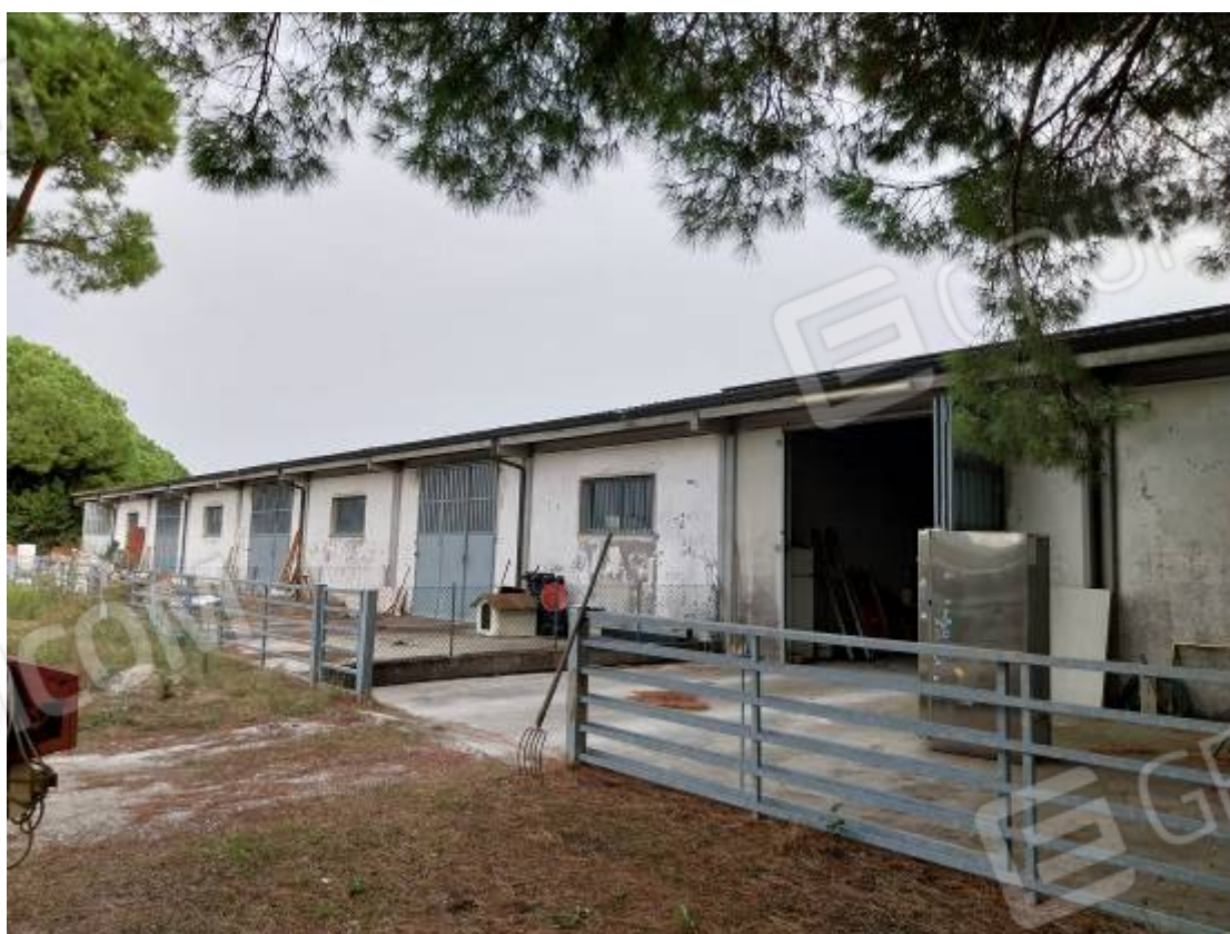
Foto 15 - Vista prospetto nord ovest del capannone (edificio A) (Fg 90 map 157 sub 5)
