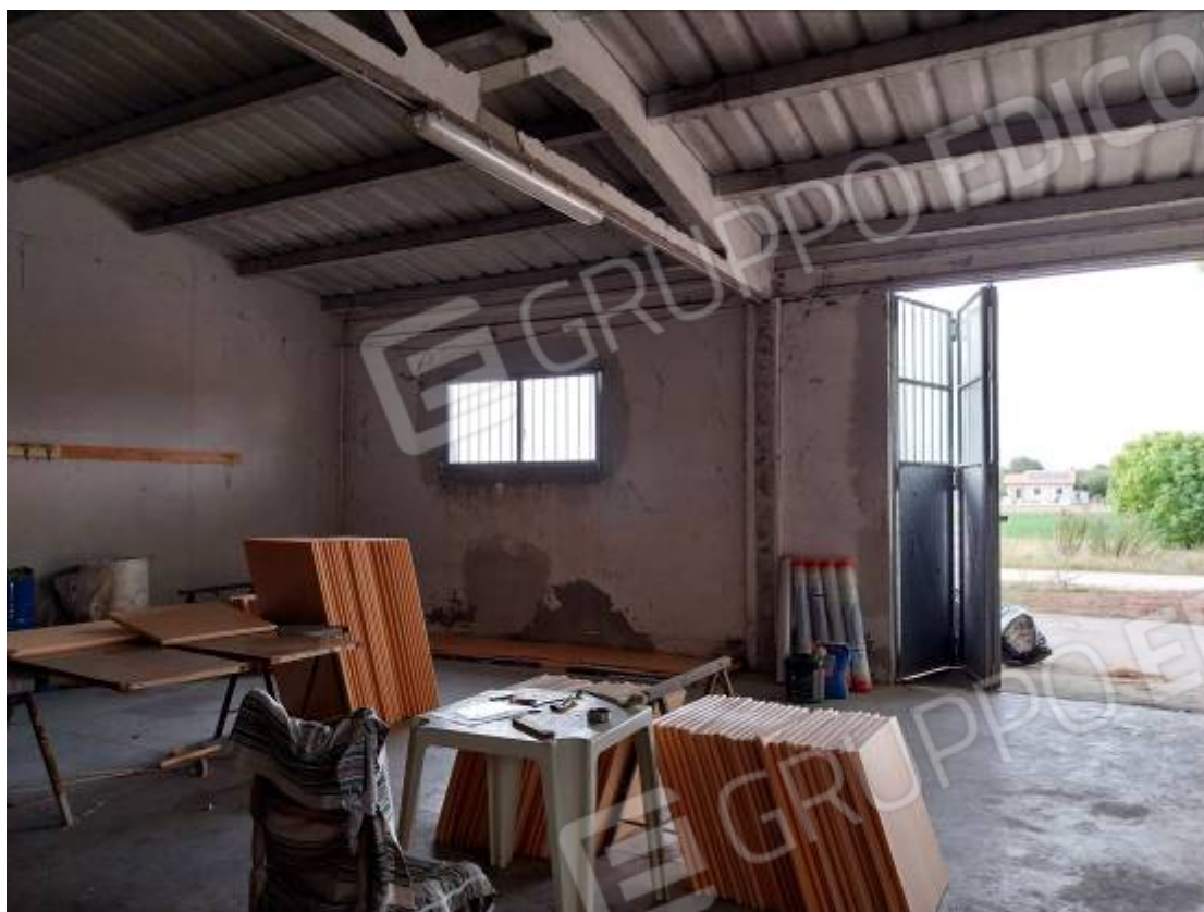
Foto 22 - particolare della vista interna del locale lato nord-est del capannone (edificio A) (Fg 90 map 157 sub 5)
