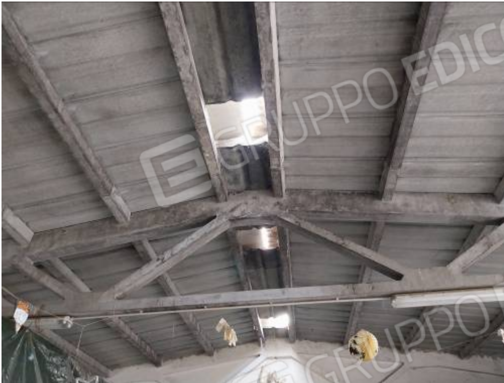
Foto 18 - Particolare della copertura del capannone (edificio A) (Fg 90 map 157 sub 5)
