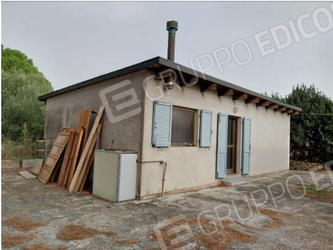
Foto 39 - Edificio "C" – vista esterna (Fg. 90 map. 157 sub. 3)
