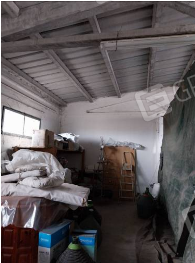
Foto 19 - vista interna del locale lato sud-est del capannone e della porta di accesso all'interrato (Fg 90 map 157 sub 5) (edificio A)
