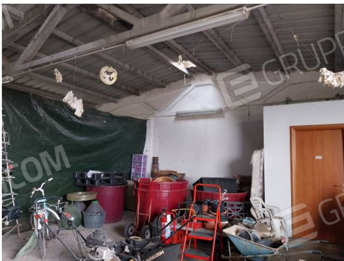
Foto 17 – Particolare interno del capannone (lato sud est) e locale bagno (edificio A) (Fig 90 map 157 sub 5)
