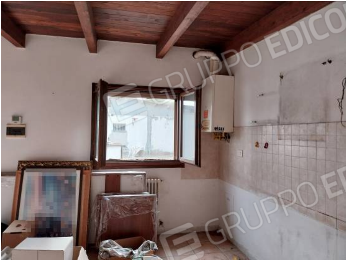
Foto 41- Edificio "C", vista interna zona giorno (Fg. 90 map. 157 sub. 3)
