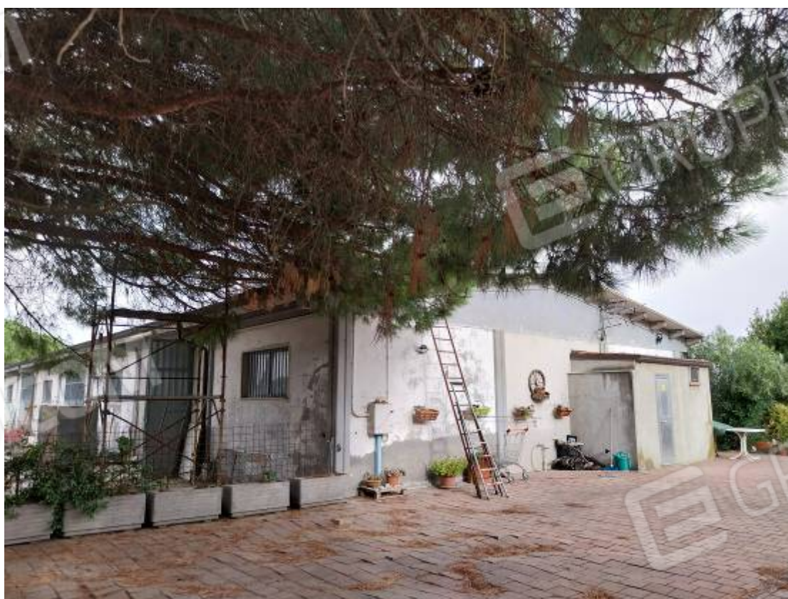
Foto 23 - Vista laterale sud-est del capannone (edificio A) e del locale esterno montacarichi (non regolare)
