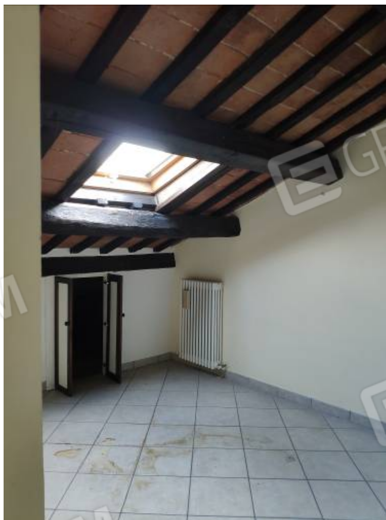
Vista dell'ambiente 2 del sottotetto non abitabile
