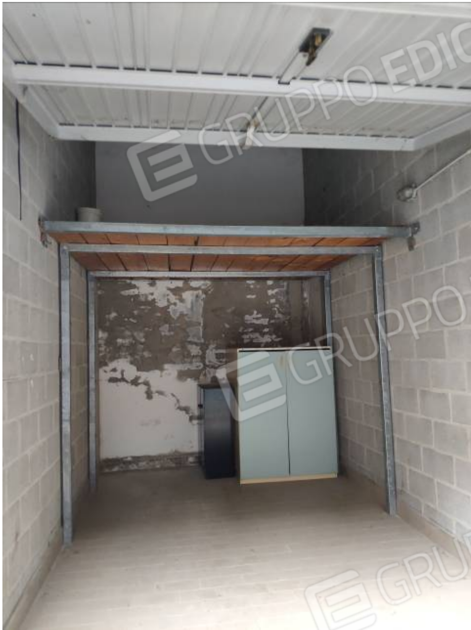
Vista interna dell'autorimessa e della struttura in metallo e legno non regolare
