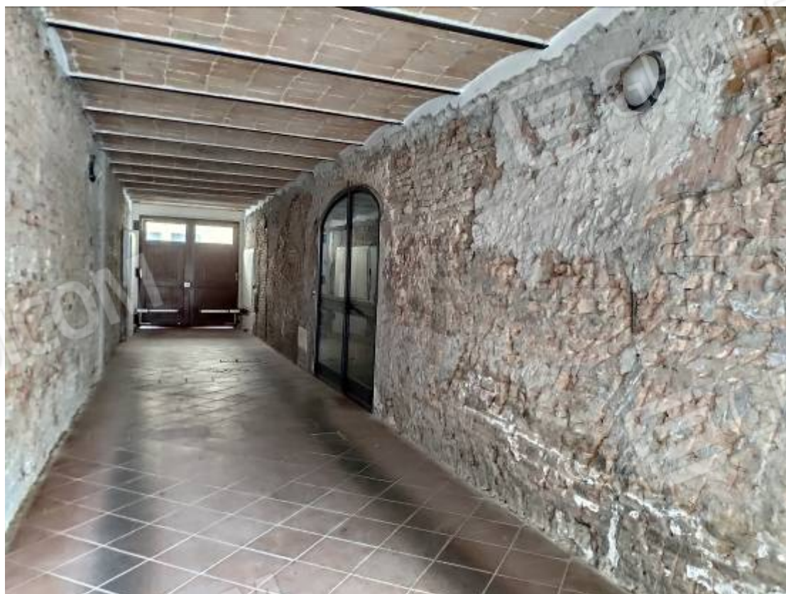
Vista dell'androne comune e dell'accesso carrabile e pedonale da corso Garibaldi
