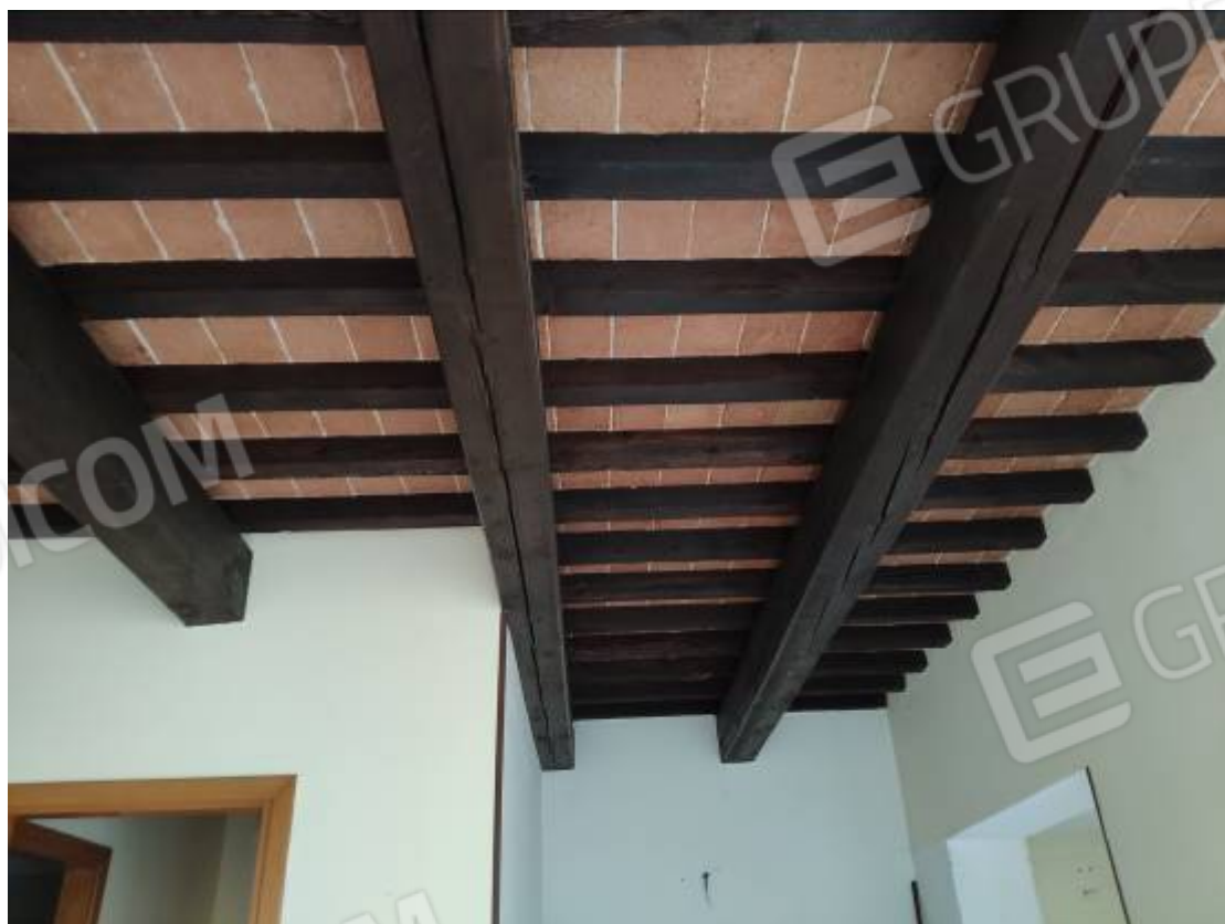
Vista di porzione del soggiorno
