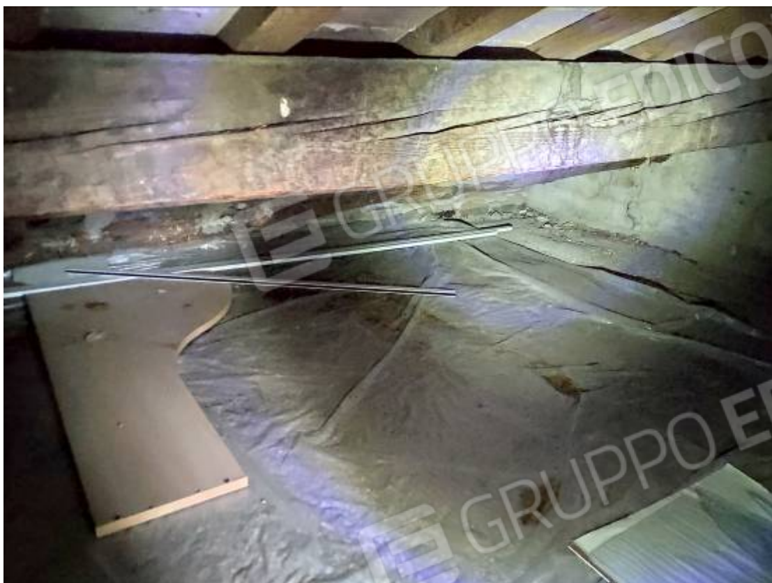
Vista della porzione più bassa del sottotetto allo stato grezzo
