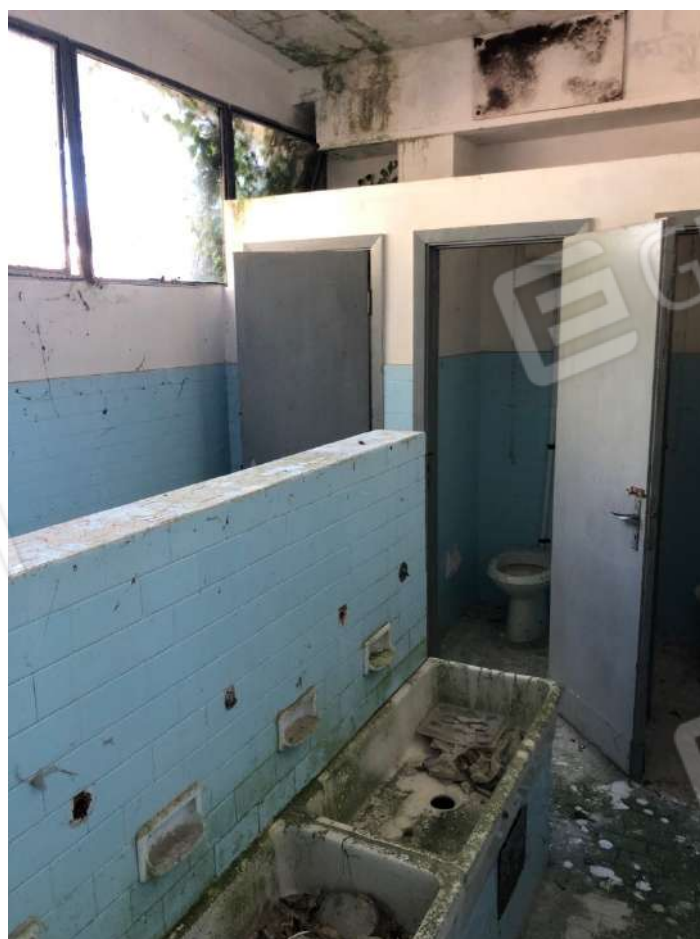
Vista servizi igienici nord-ovest al piano primo.
