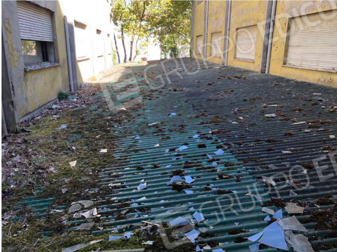
Vista tettoia da rimuovere dal piano primo.
