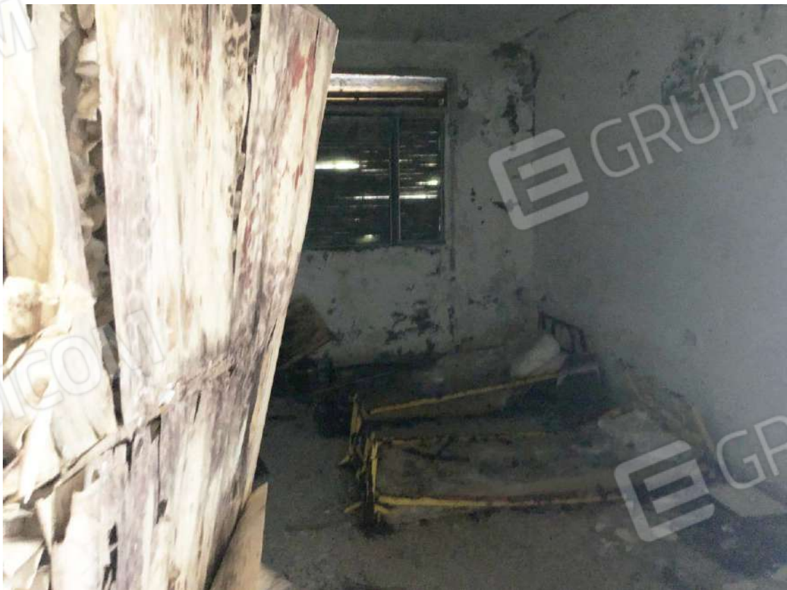
Vista camera nord-ovest al piano terzo.
