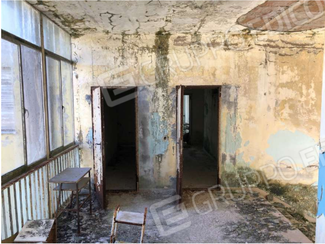
Vista disimpegni da vano scala al piano terzo.
