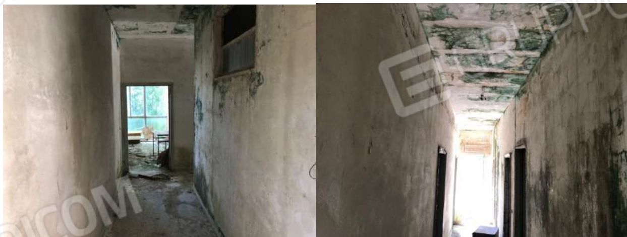
Vista disimpegni sud-est al piano terzo.
