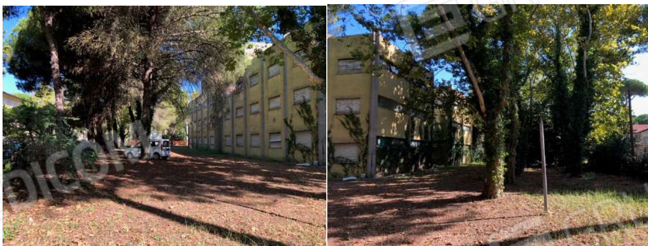
Vista aerea cortiliva pertinenziale su Via Abruzzi e vista prospetto sud.
