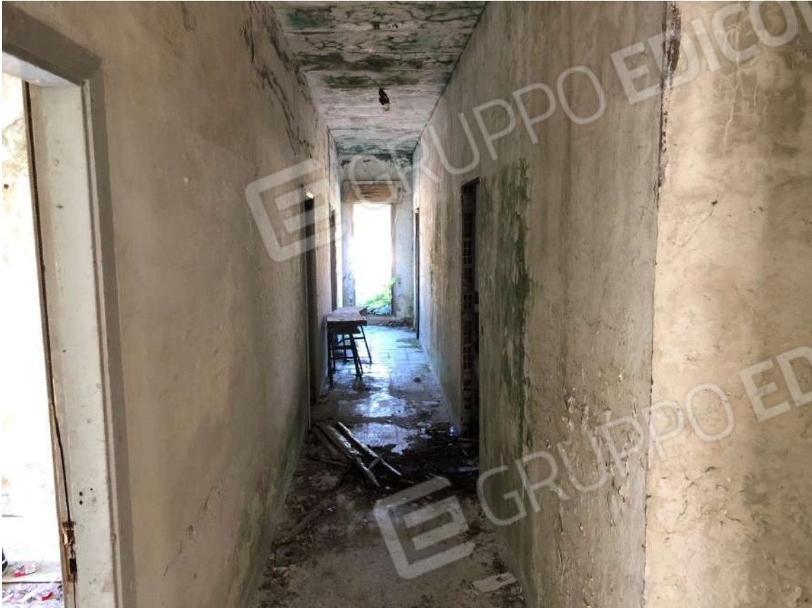
Vista disimpegno nord-ovest al terzo piano.
