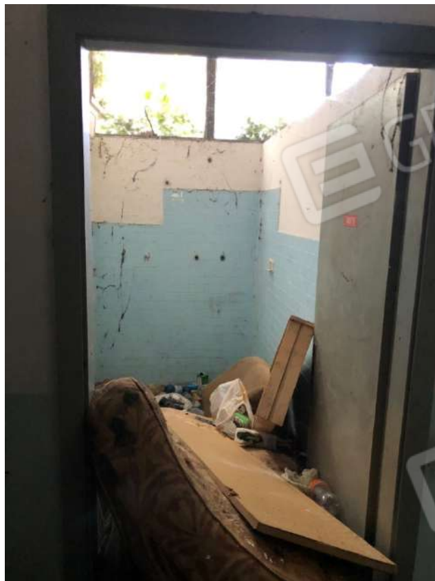
Vista servizio igienico al piano terra.
