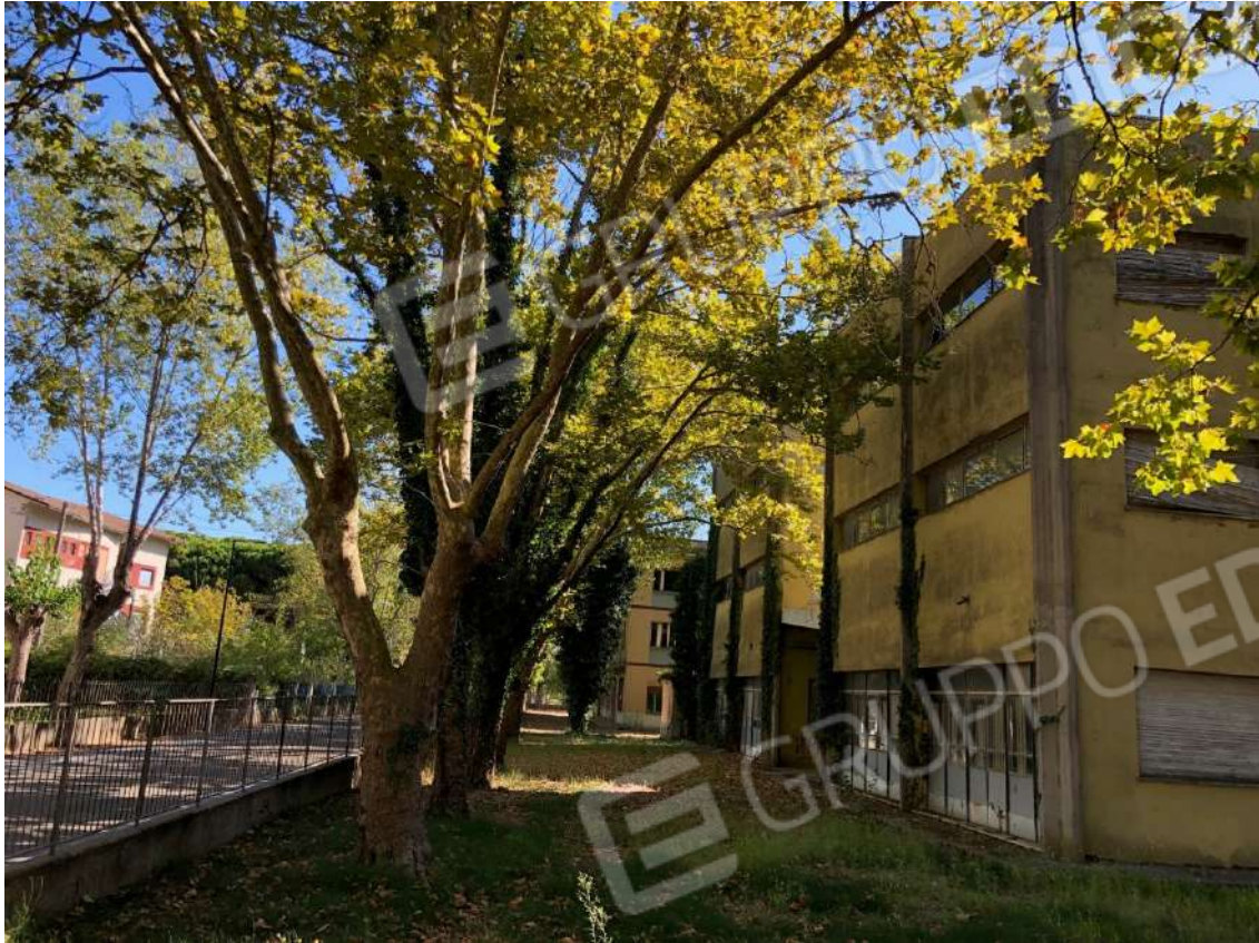
Vista area cortiliva pertinenziale su Via Salentino e vista prospetto nord.
