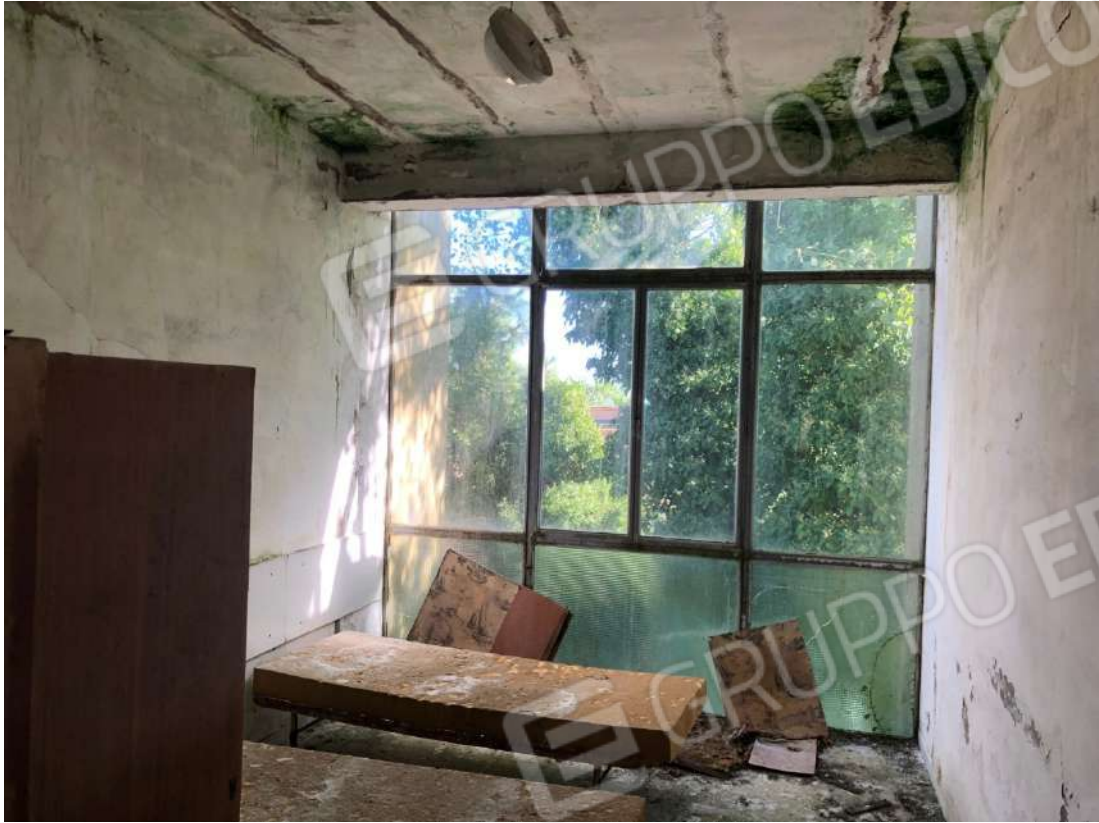
Vista cucina sud-est al piano terzo.
