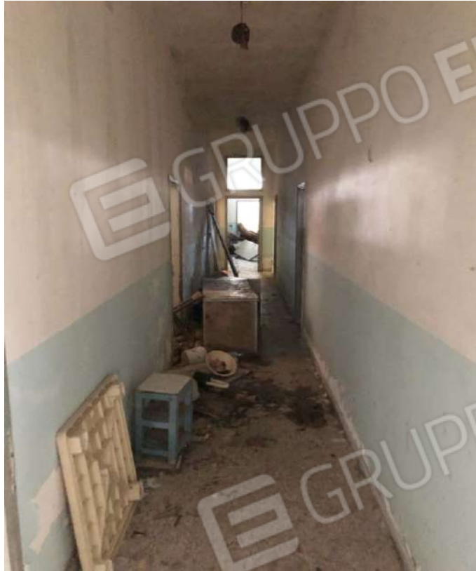
Vista ulteriore disimpegno al piano terra.
