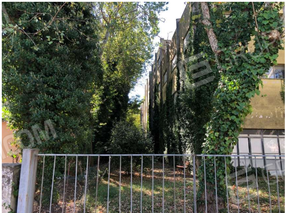
Vista prospetto nord-est sul retro da Via Salentino.
