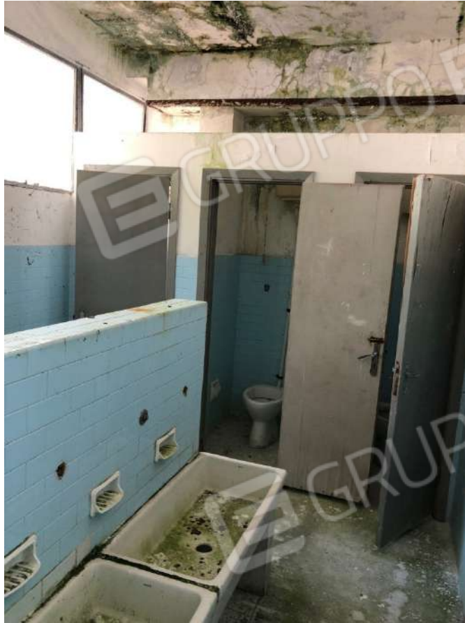
Vista servizi igienici sud-est al piano primo.
