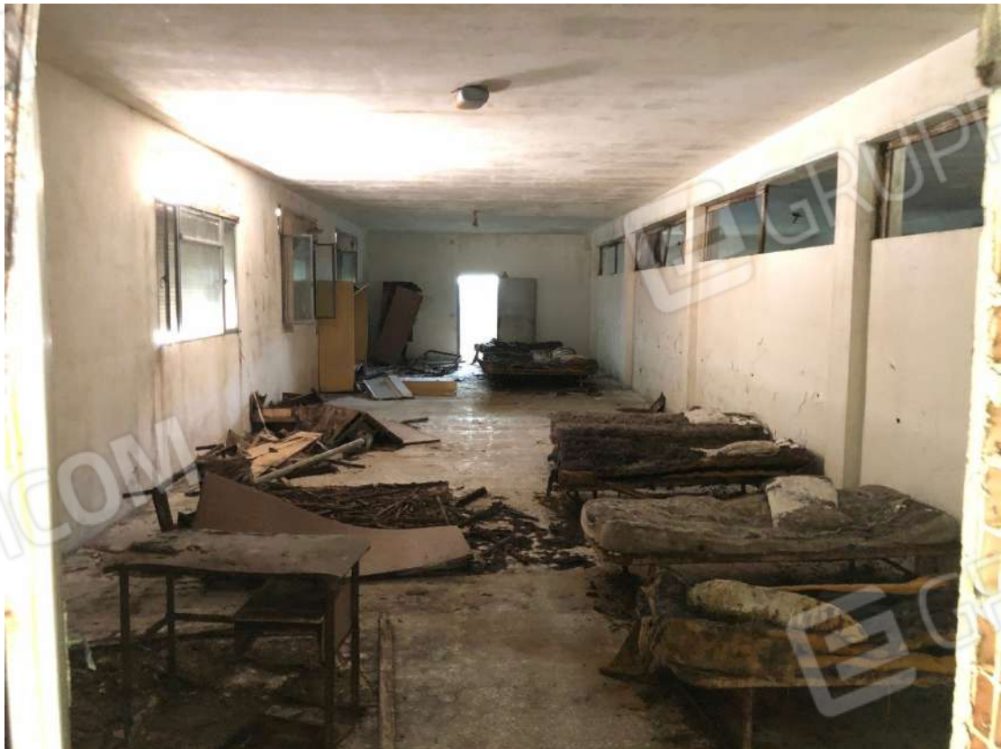
Vista camerata nord-est al piano primo.
