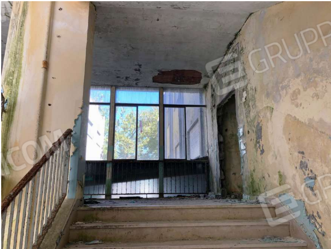
Vista arrivo al vano scala del piano primo.
