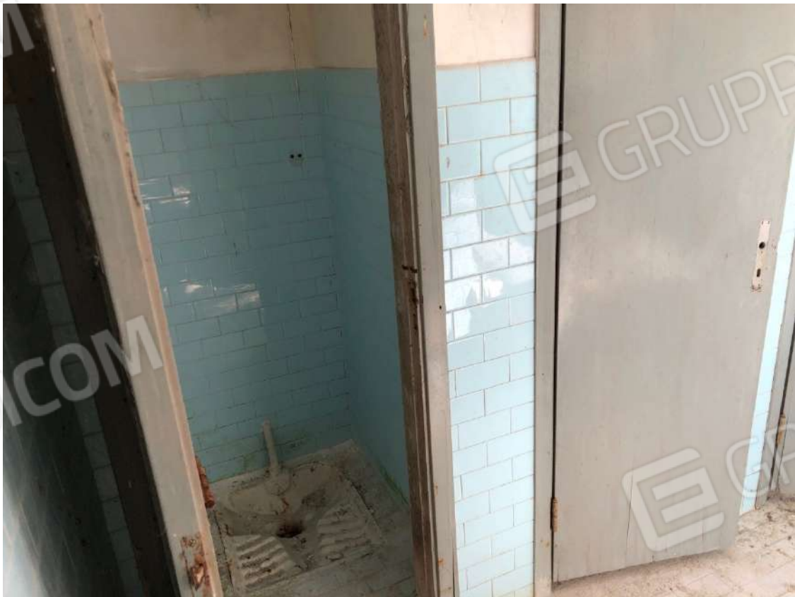
Vista servizi igienici nord-ovest al piano secondo.
