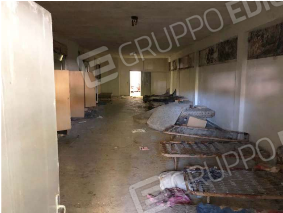
Vista camerata sud-ovest al piano primo.
