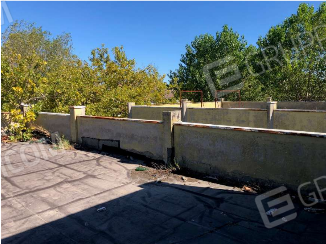
Vista terrazzo lato nord-ovest al piano terzo.
