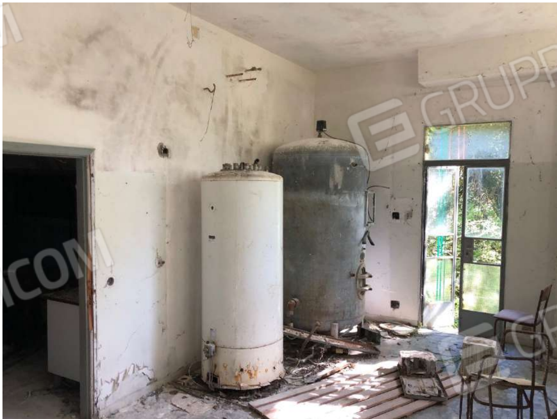
Vista magazzino al piano terra.
