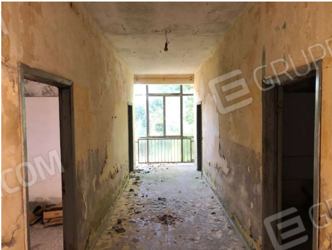
Vista disimpegno lato est al piano secondo.
