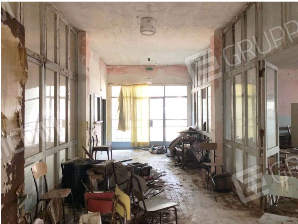
Vista disimpegno al piano terra.
