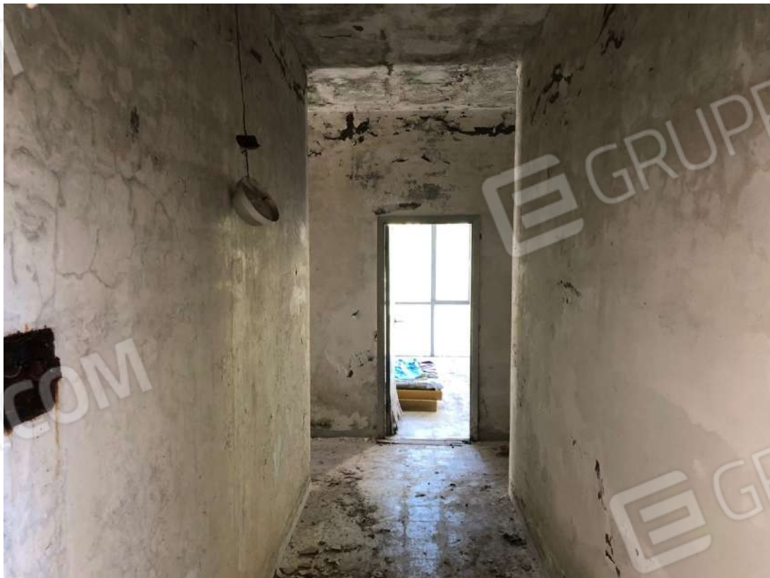
Vista disimpegno lato ovest al piano terzo.
