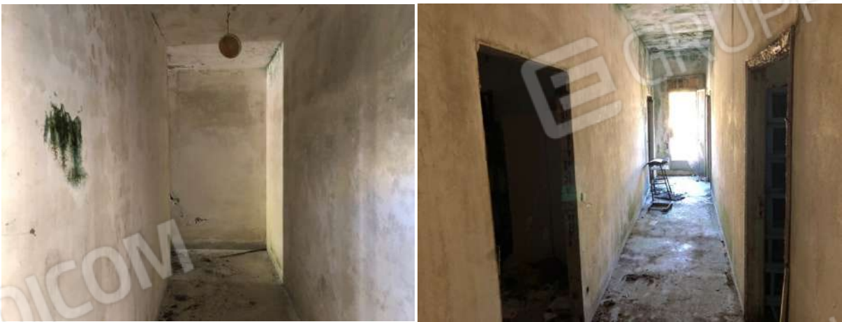
Vista disimpegni nord-est al piano terzo.
