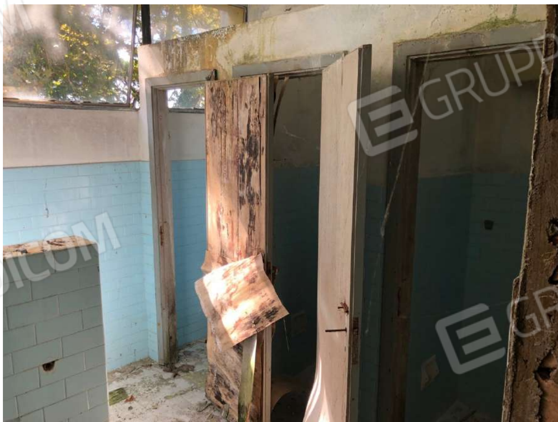
Vista servizi igienici nord-est al piano secondo.
