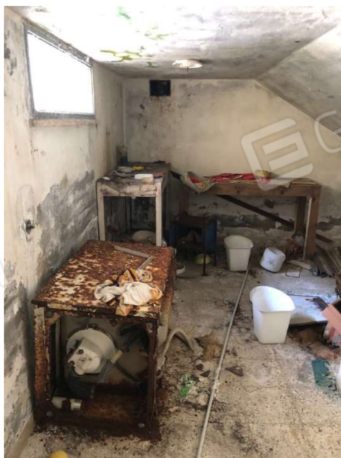
Vista del sottoscala al piano terra.
