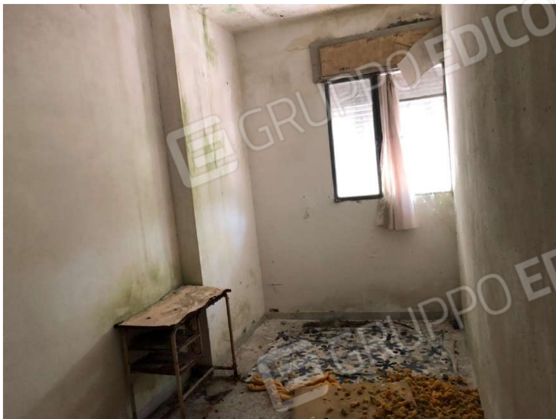
Vista locale personale sud-est al piano terzo.
