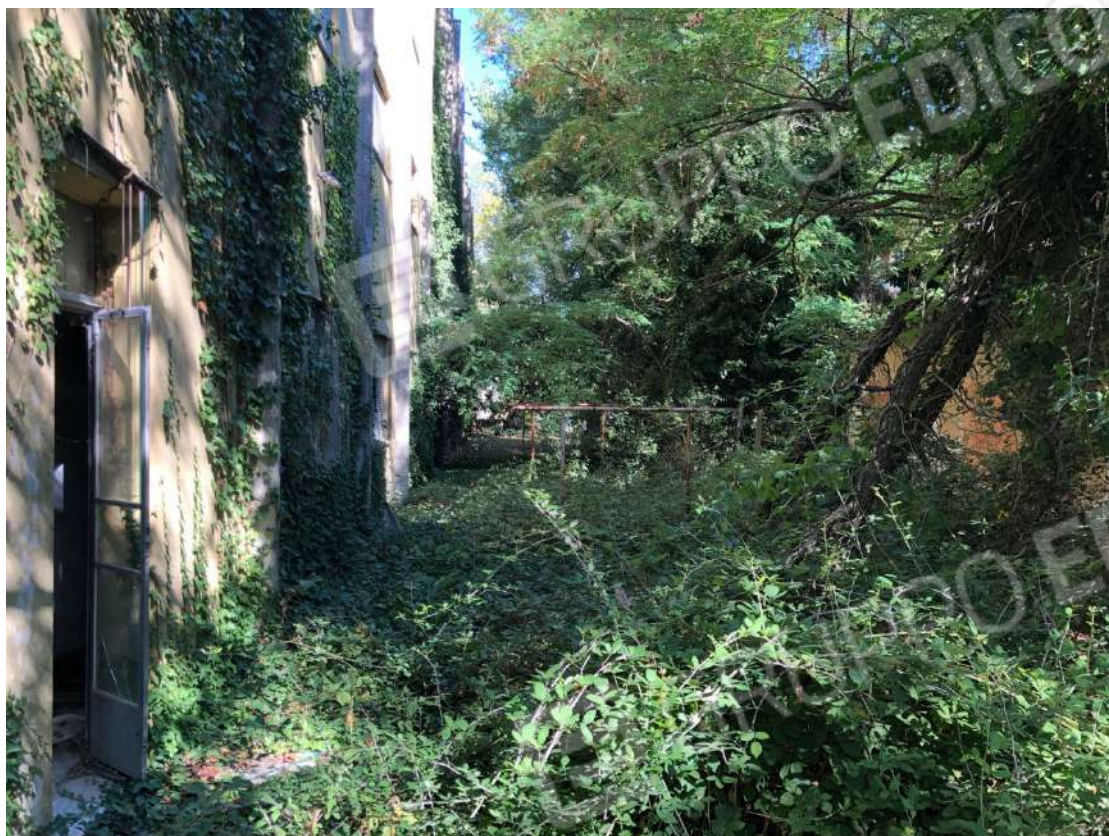
Vista area cortiliva pertinenziale sul retro, prospetto nord-est.
