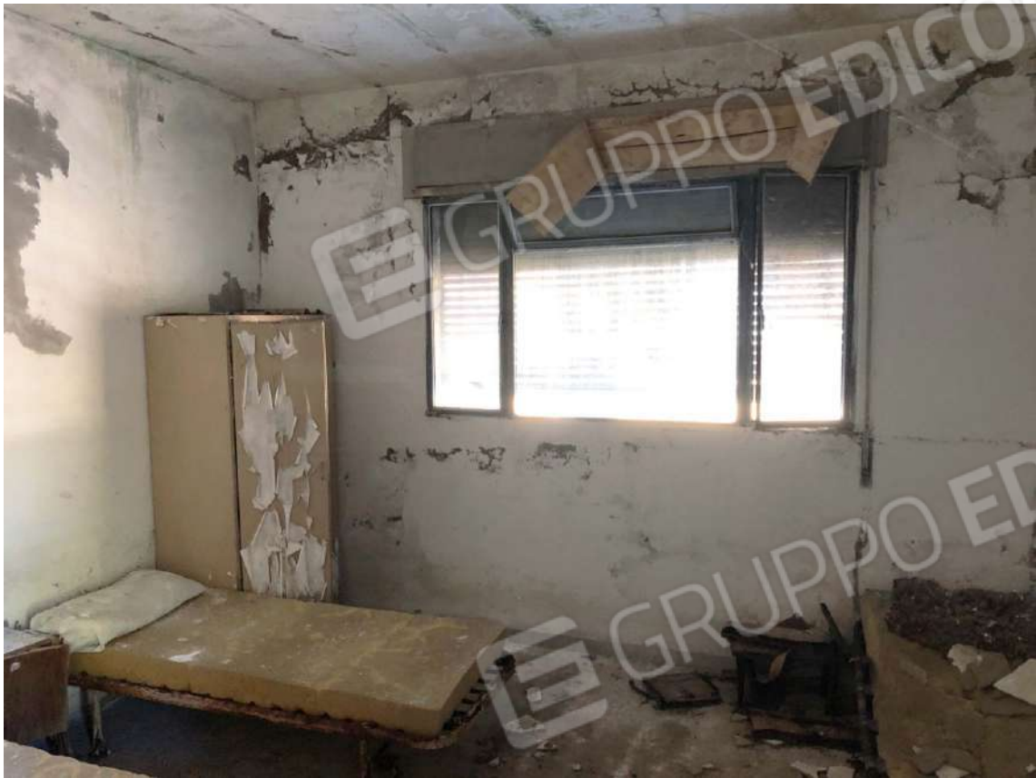
Vista locale del personale nord-est al piano terzo.
