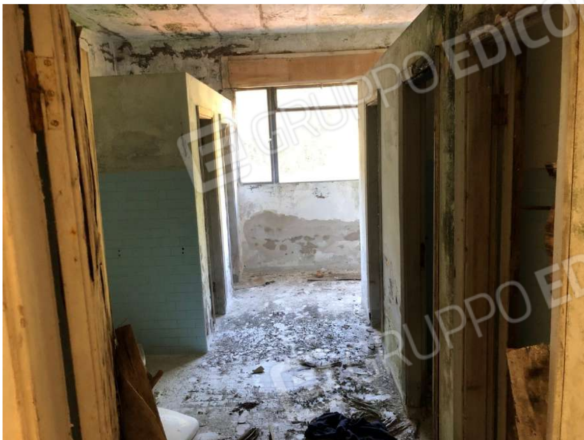
Vista servizio igienico sud-ovest al terzo piano.
