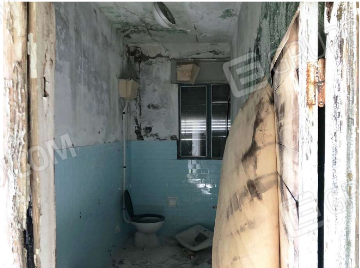
Vista ulteriore servizio igienico sud-est al piano terzo.
