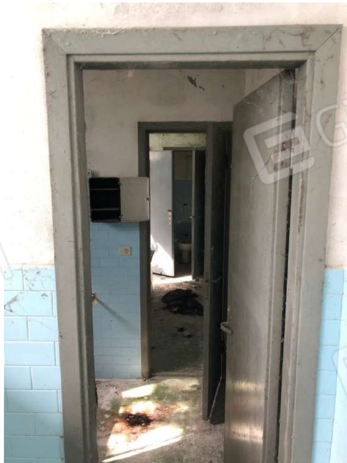
Vista servizi igienici sud-ovest al piano primo.
