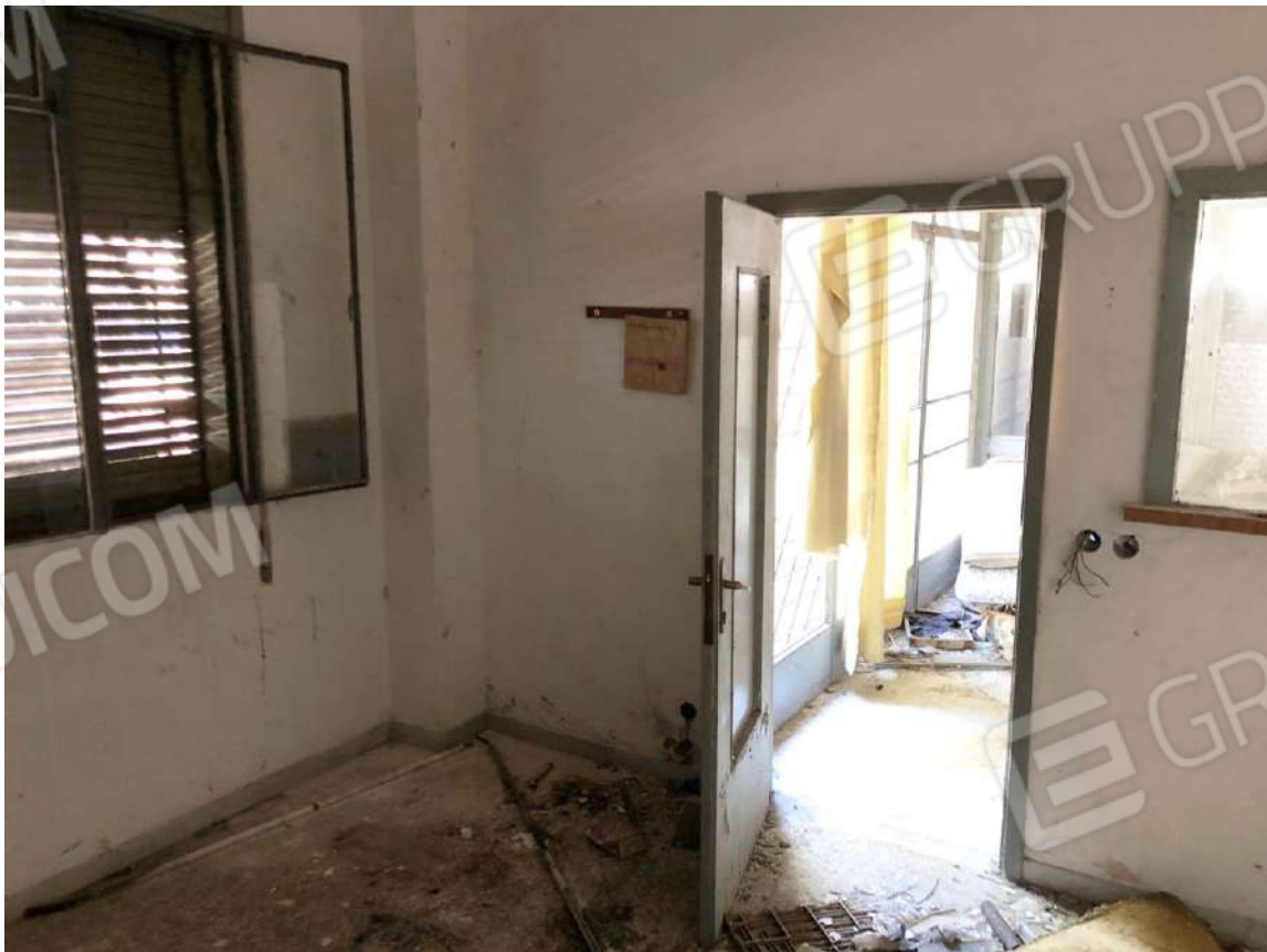
Vista locale direzione al piano terra.
