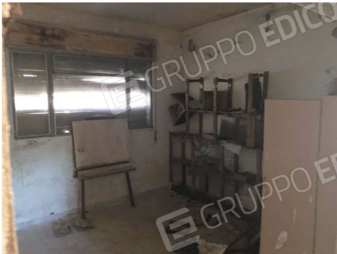
Vista guardaroba lato nord-est al piano terzo.
