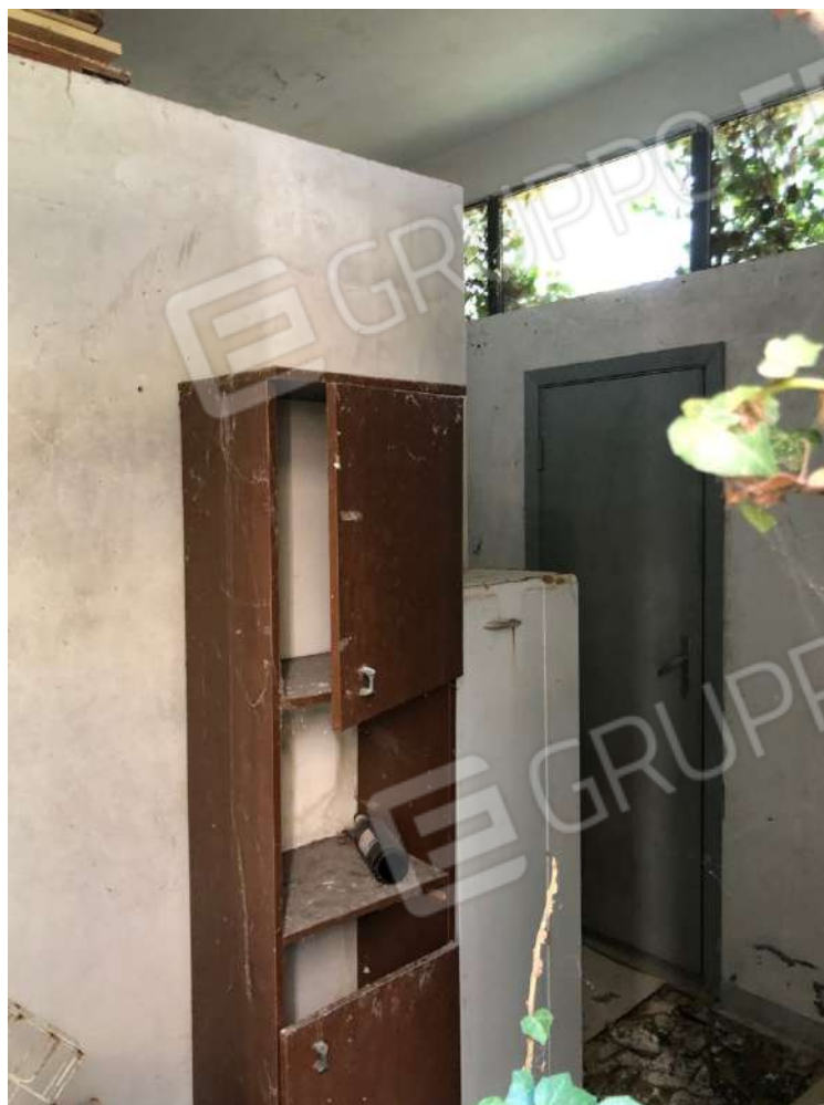
Vista servizio igienico sud-est al piano terra, accessibile solo dall'esterno.
