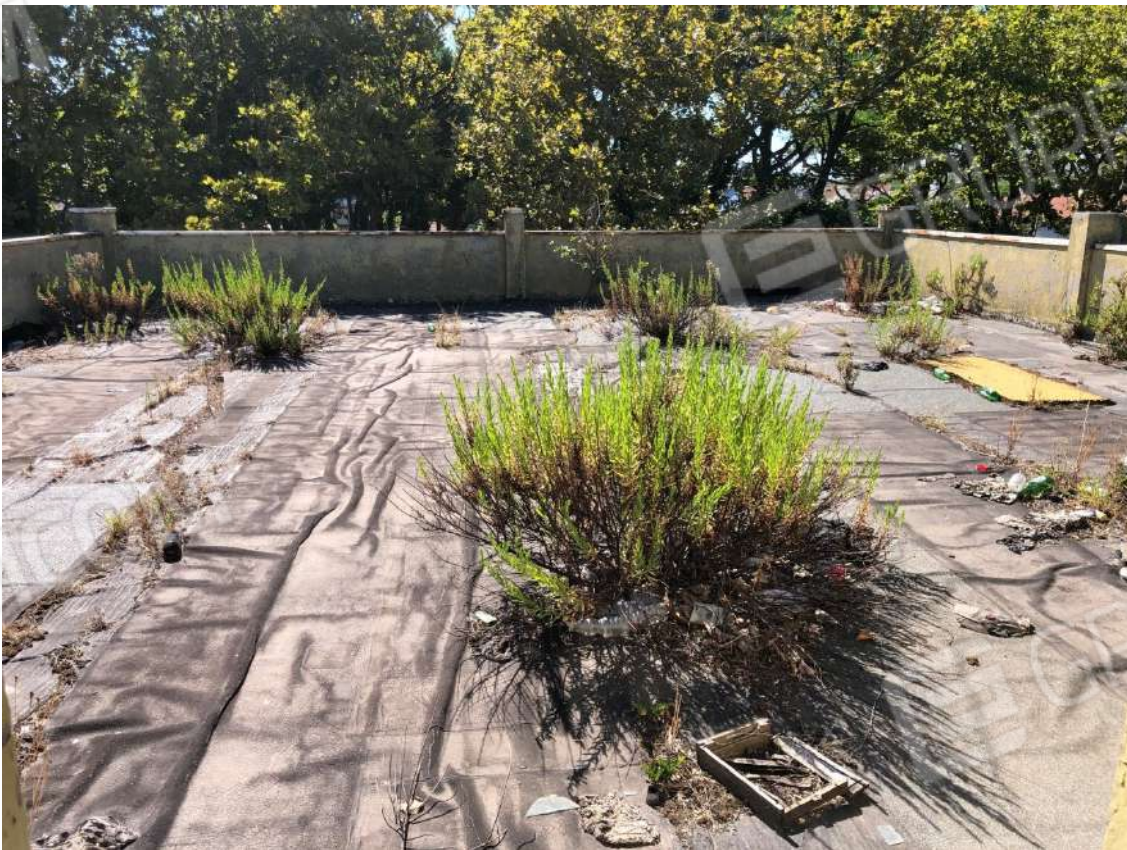
Vista terrazzo sud-ovest al terzo piano.
