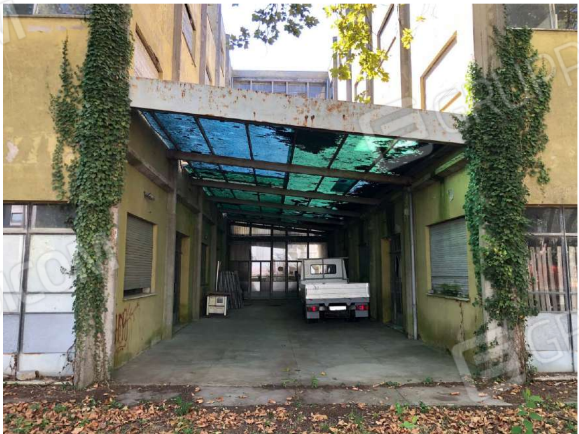
Vista tettoia da rimuovere su prospetto nord, ingresso alla colonia.
