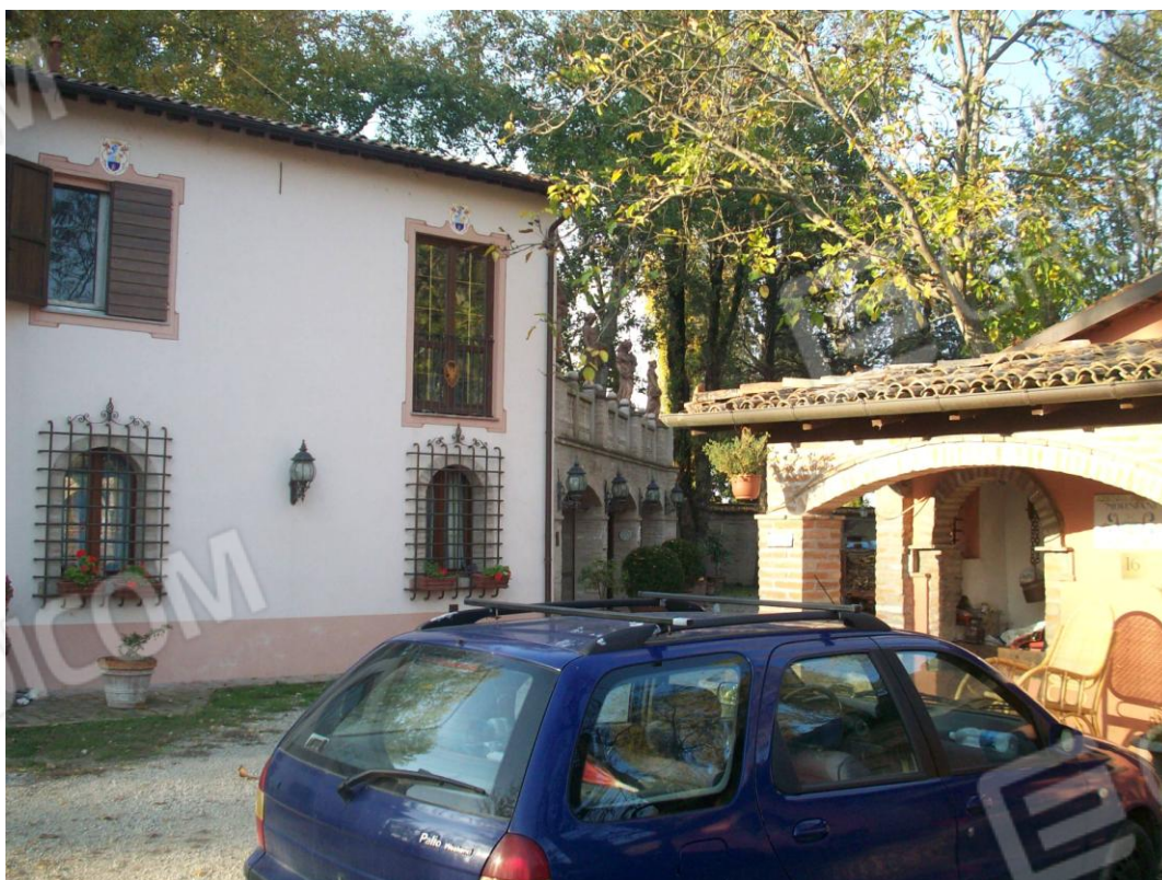
FOTO 6 – PARTICOLARI FABBR. “B” E FABBR. “C”
