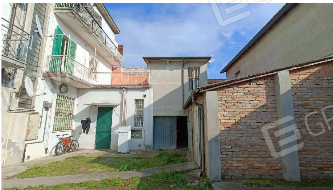
Vista del portone di accesso al ripostiglio dalla corte interna.
