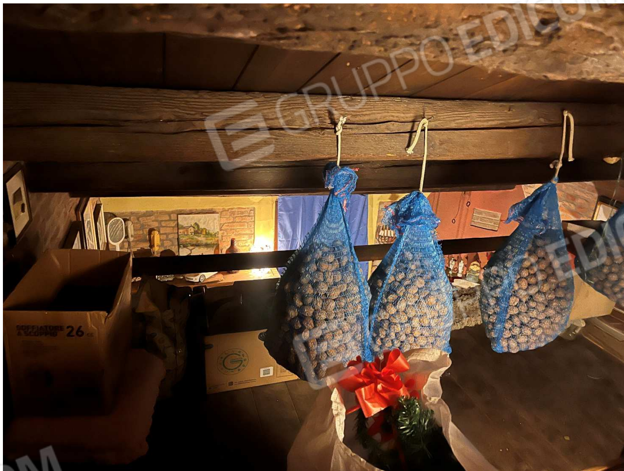
Solaio sul quale sbarca la scala ricavata nel locale ripostiglio PT
