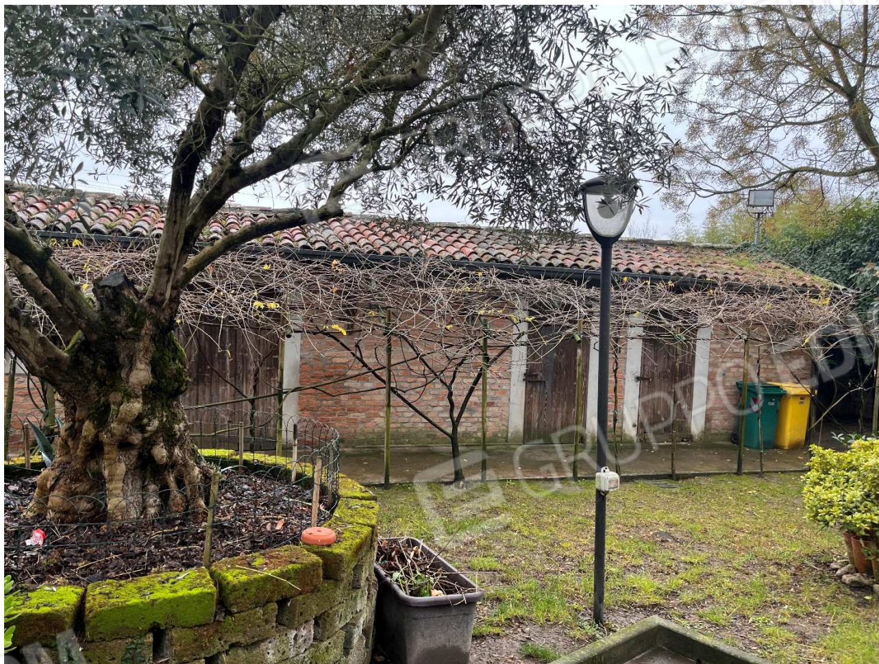
Vista esterna cantine facenti parte del sub.3
