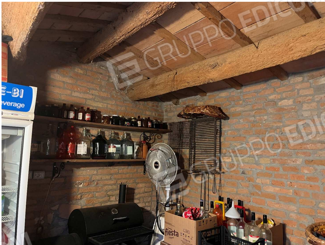
Vista interna di un locale cantina facente parte del sub.3
