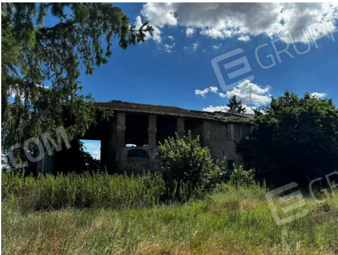
Foto 10: Vista dei servizi agricoli, cascina e legnaia (sub. 2) e part. 186
