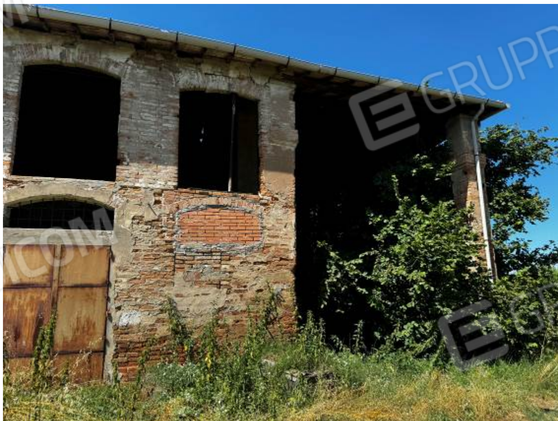
Foto 6: Fronte su via del Manzone (sub. 2)
