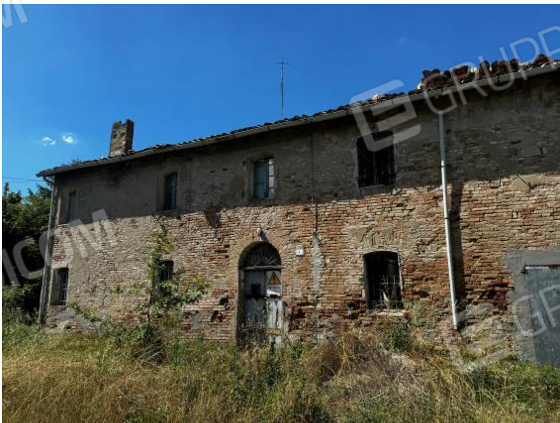
Foto 4: Fronte su via del Manzone (sub. 3)
