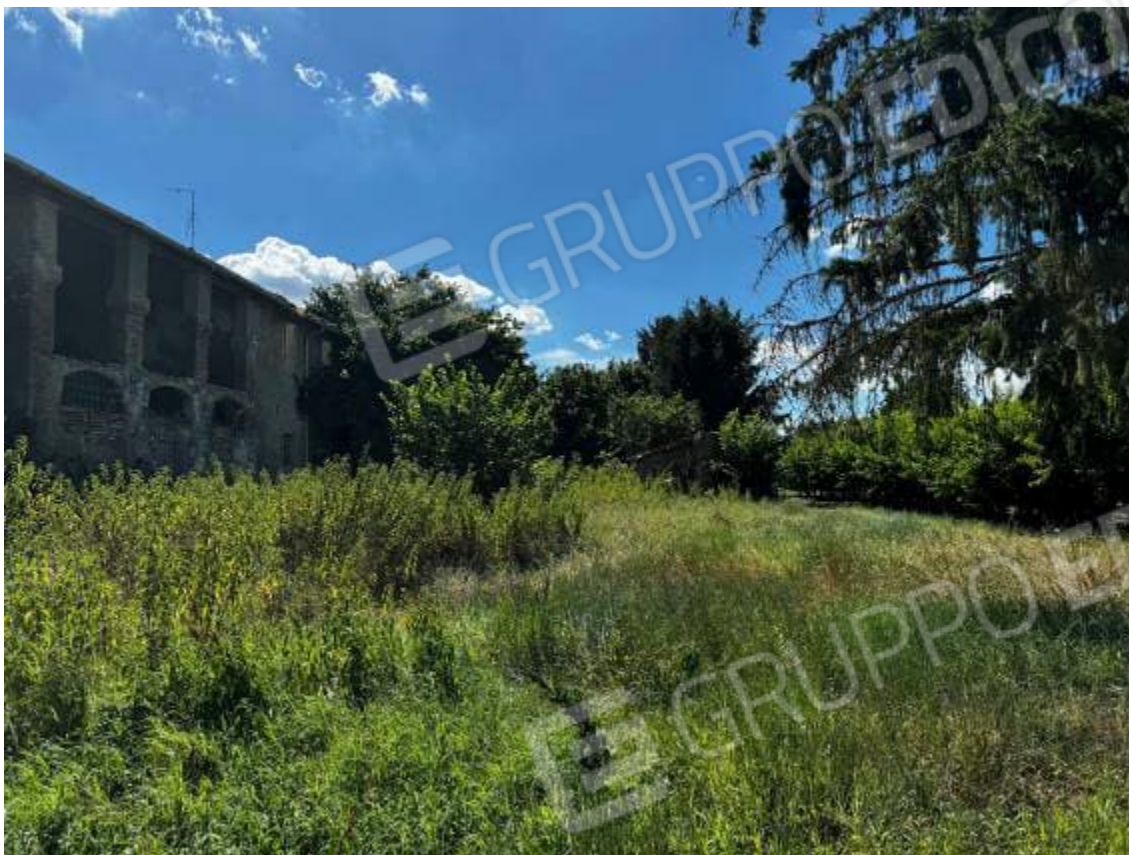
Foto 11: Vista dei servizi agricoli, cascina e legnaia (sub. 2) e part. 186
