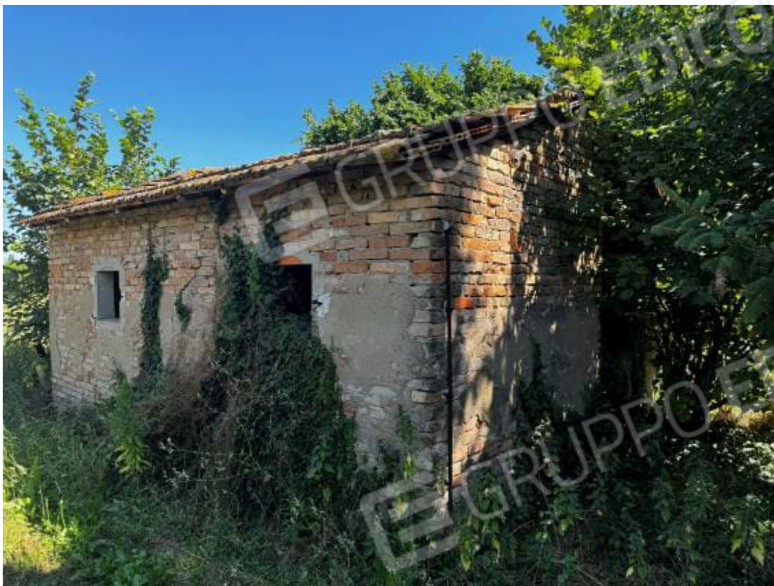
Foto 13: Vista dei servizi agricoli, corpo staccato (sub. 2) e part. 186
