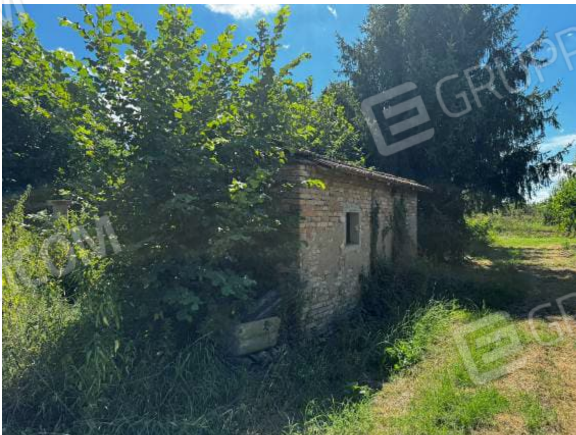
Foto 12: Vista dei servizi agricoli, corpo staccato (sub. 2) e part. 186
