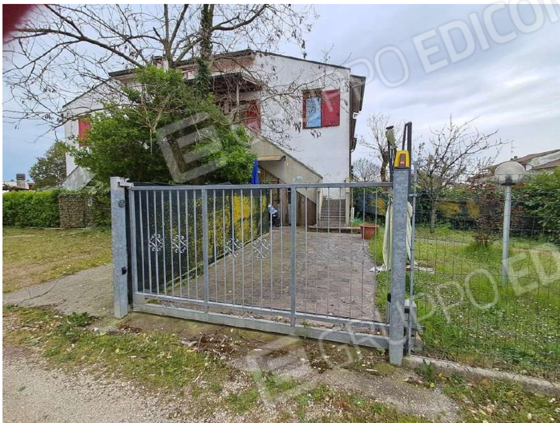
VISTA PROSPETTO NORD – CANCELLO CARRABILE DI ACCESSO AL POSTO AUTO
