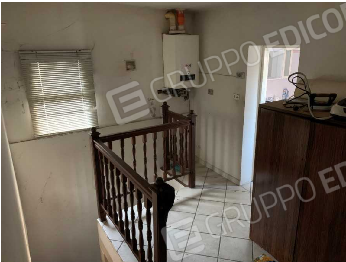
VANO SCALA PIANO PRIMO
