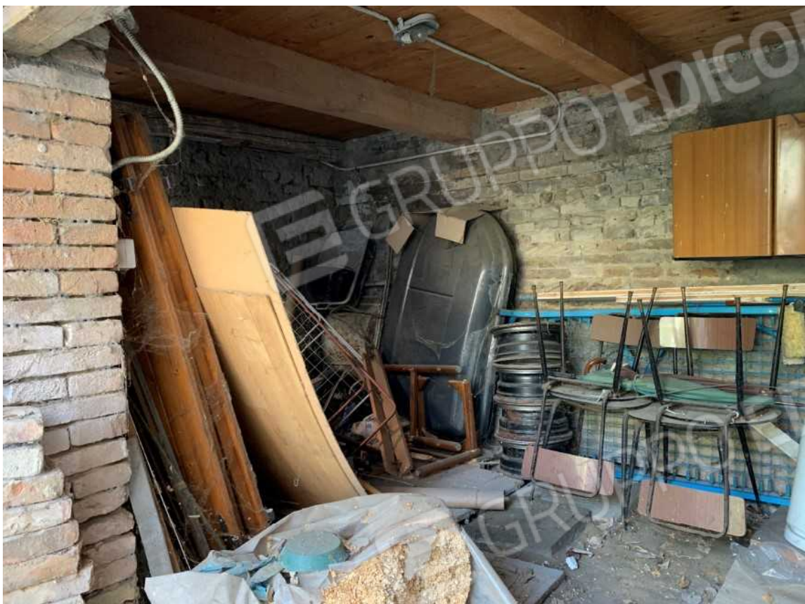
FABBRICATO A SERVIZI PIANO TERRA: PARTICOLARE
