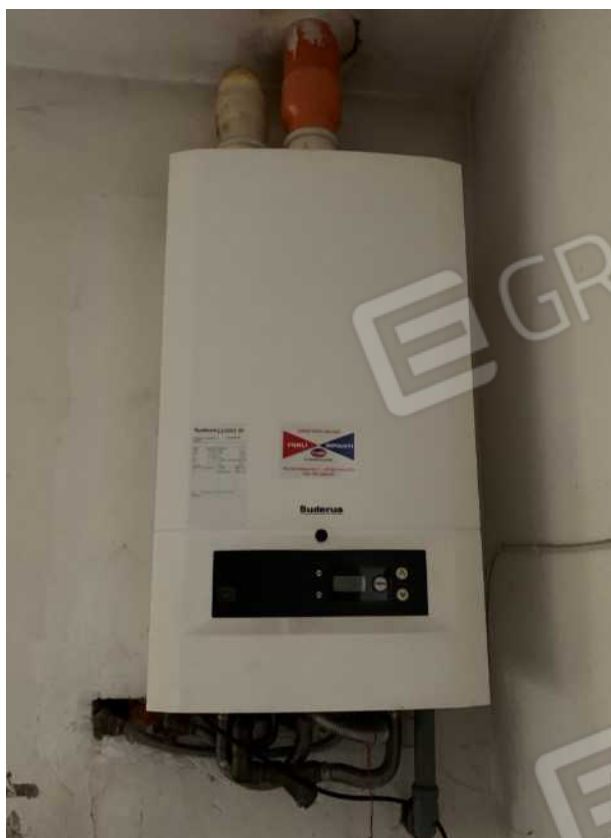
PARTICOLARE CALDAIA A CONDENSAZIONE INSTALLATA NEL 2008
