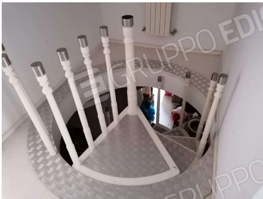
Foto n.14 – Accesso al sottotetto
