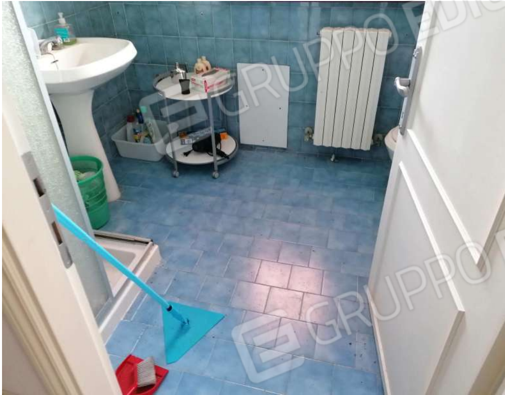
Foto n.18 – Bagno nel sottotetto
