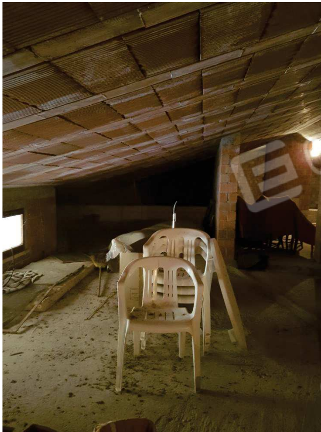
Foto 27 – Sottotetto non abitabile
