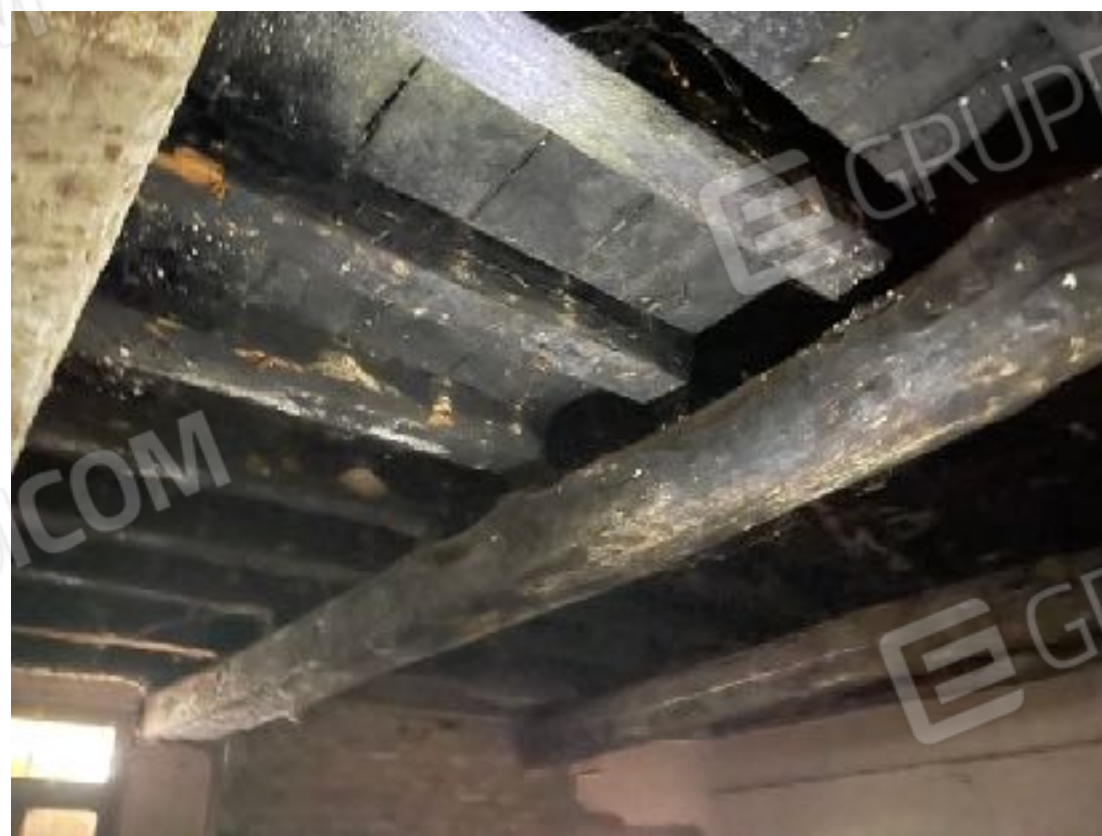
Particolare orditura solai piano terra
