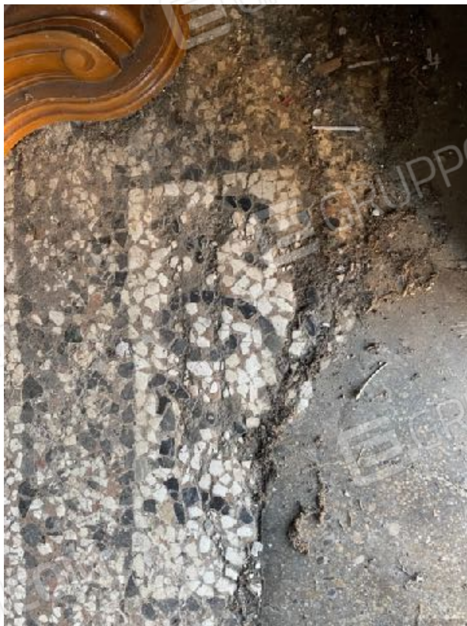
Particolare soglia di ingresso con mosaico recante presunta data di costruzione
