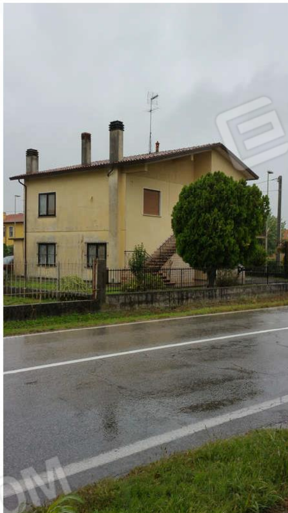
2-Esterni Lato da Via Levada
