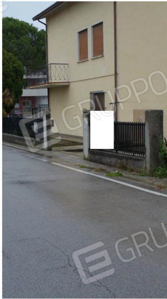
3-Esterni Lato Strada Laterale
