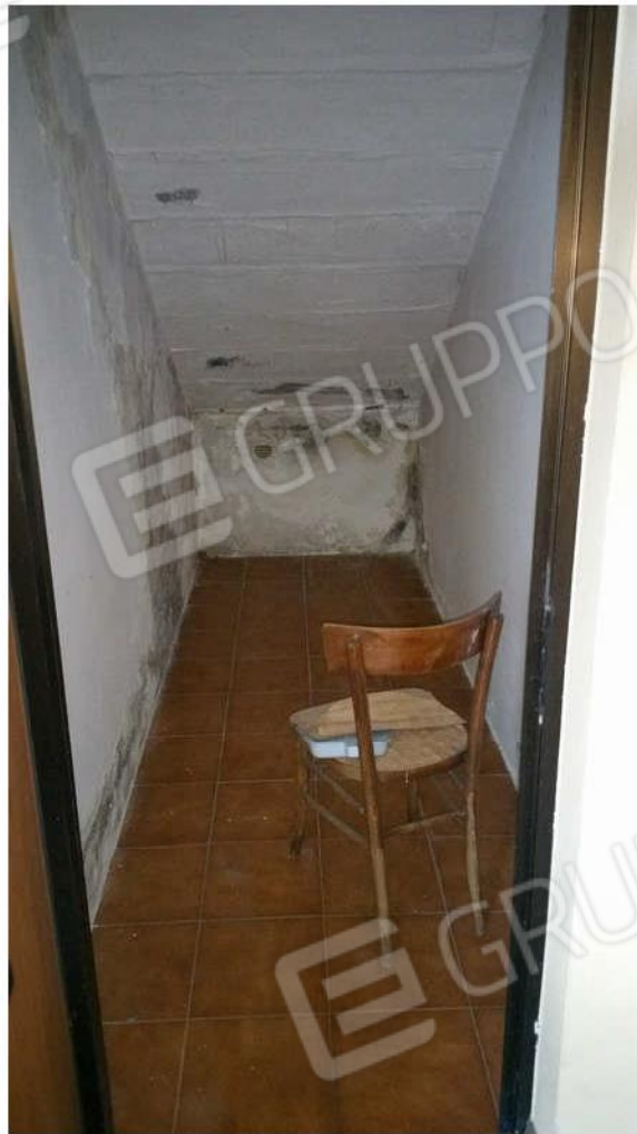
17-Lotto 1 - sottoscala esterno
