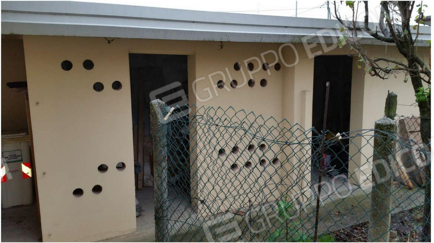
5-Esterni - Ripostigli lotto 1
