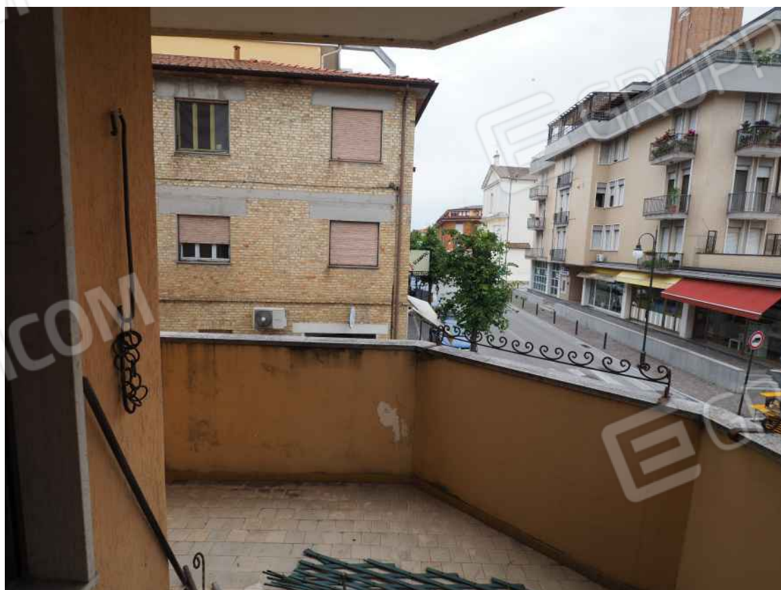
Azzano Decimo, via Mores di Sotto n. 5 int. b – Il balcone.
