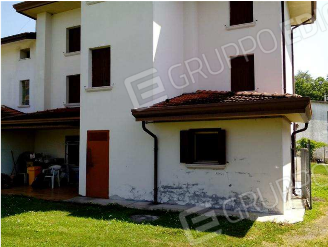
9) Fronte ovest del fabbricato abitazione prospiciente l'area scoperta della stessa proprietà, non pignorata
