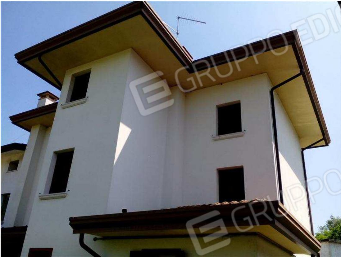
11) Particolari del fronte ovest del fabbricato abitazione
