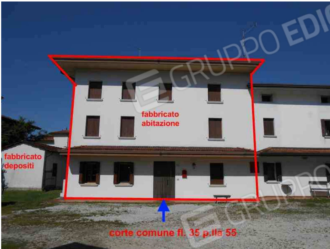
7) Veduta dei fabbricati dalla corte comune (fronte est)
