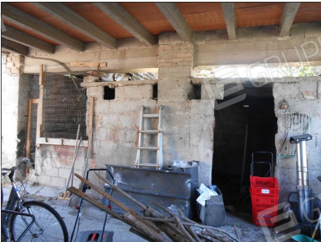
Magazzini lato ovest
