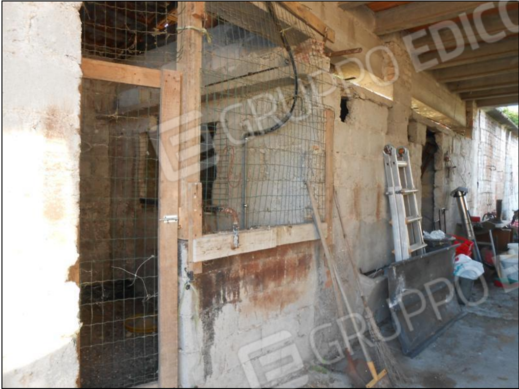
Magazzini lato ovest
