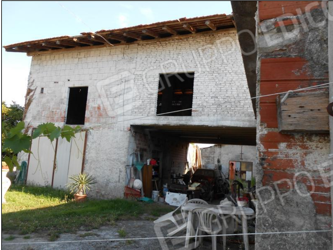
Veduta del fabbricato deposito da nord e del passaggio coperto
