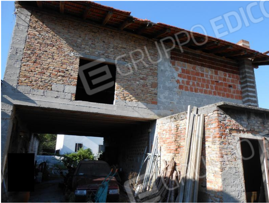
Veduta del fabbricato da sud
