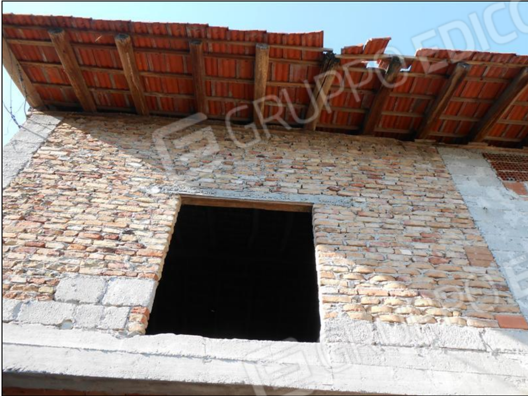
Particolare facciata sud, magazzino piano primo (non accessibile)
