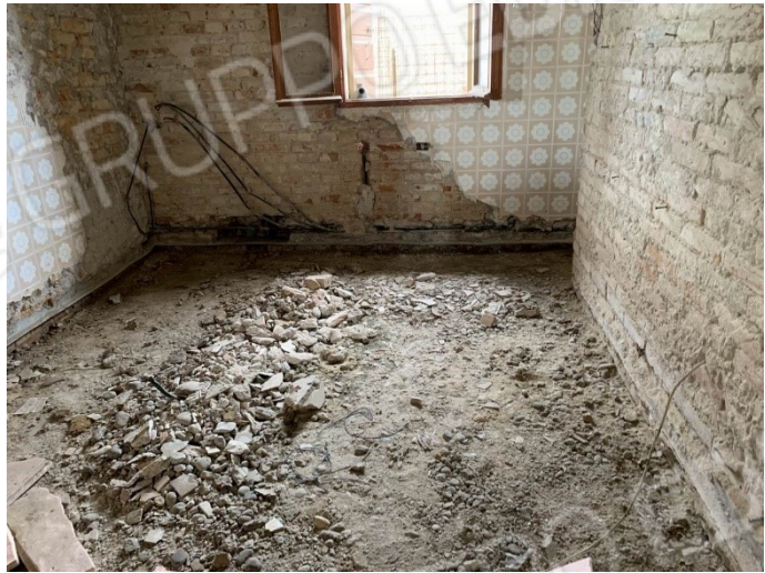
particolare interno del piano terra con pavimento totalmente demolito
