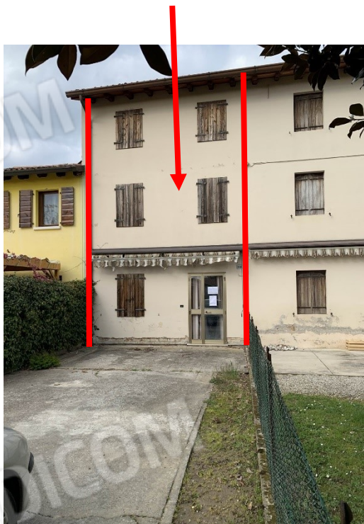
vista esterna del prospetto principale del fabbricato (lato sud con scoperto esclusivo)
