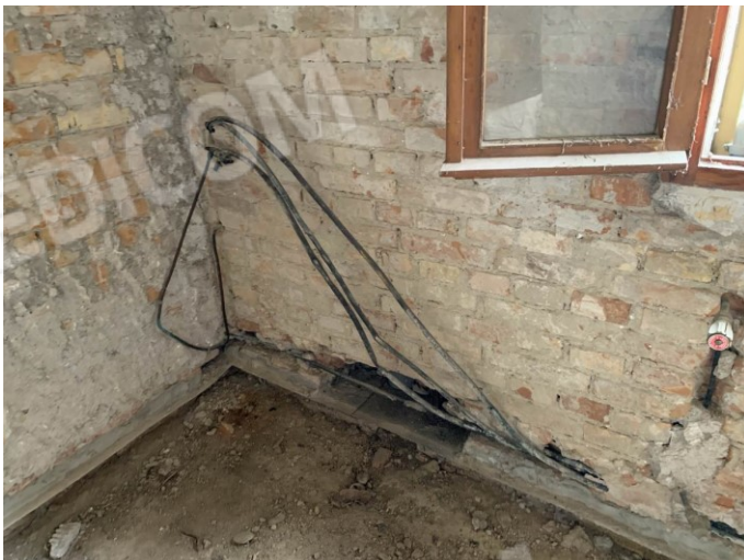
particolare del vetusto impianto termico rimosso
