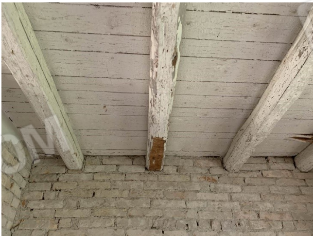
particolare del primo solaio in legno
