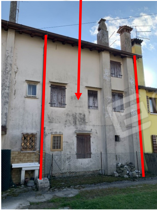
prospetto retro fabbricato (lato nord)
