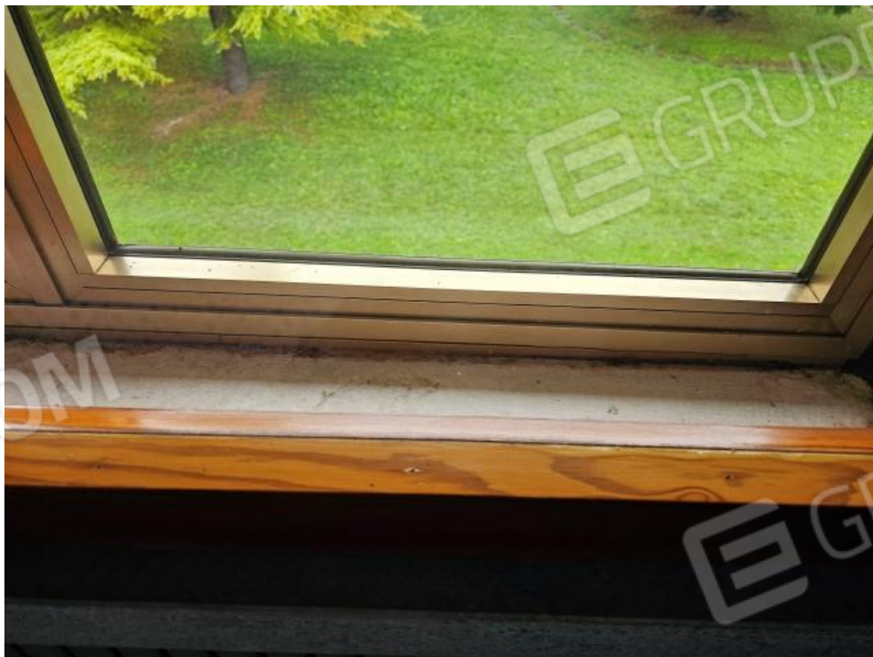
FOTO 18: PARTICOLARE SERRAMENTO (SUB. 10 – 1°P.)
