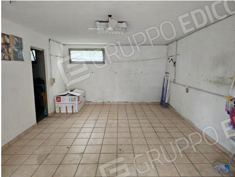
FOTO 25: INTERNO GARAGE (SUB. 20 – P.Int.)
