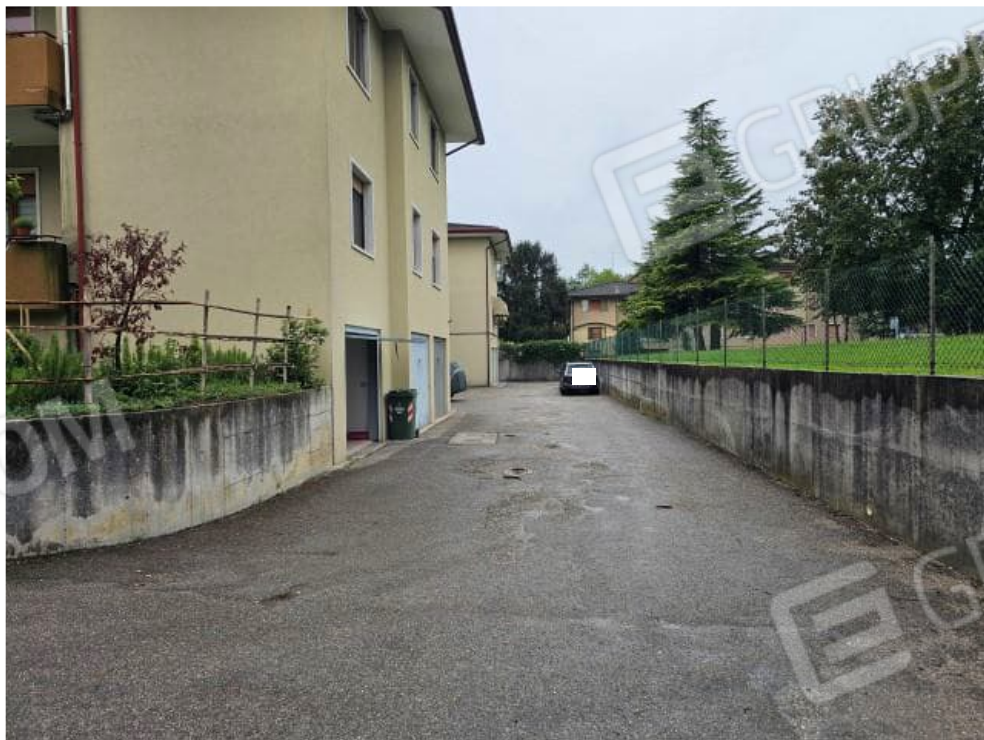
FOTO 6: AREA MANOVRA CONDOMINIALE PIANO SEMINTERRATO
