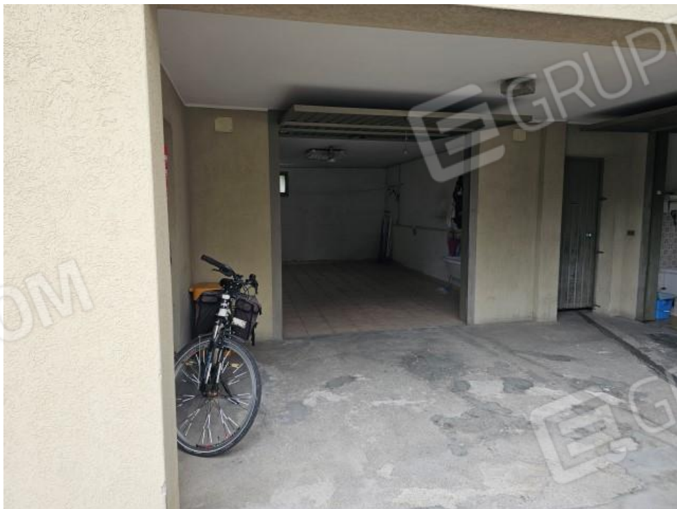
FOTO 24: ACCESSO GARAGE E CANTINA (SUB. 10 e SUB. 20 – P.Int.)
