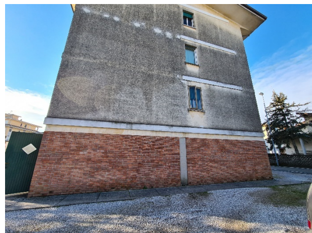
Foto d'insieme del condominio lato Nord
