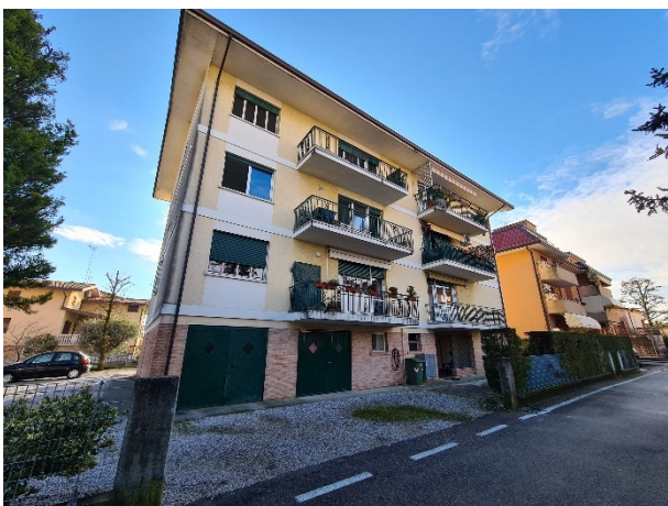
Foto d'insieme del condominio lato Ovest
