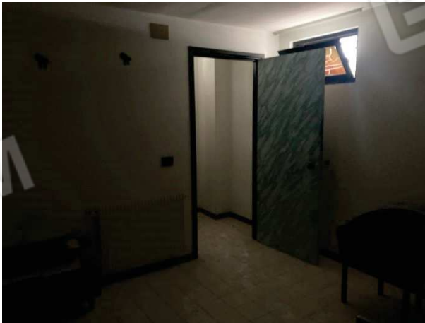
vista locale spogliatoio personale
