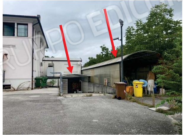
particolare delle due tettoie abusive lato Sud
