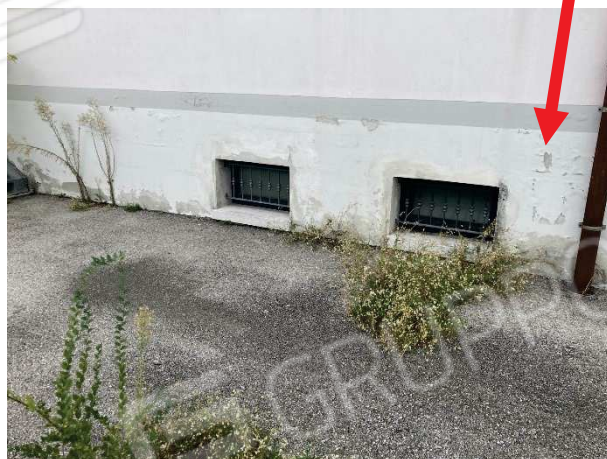
particolari degrado muratura esterna
