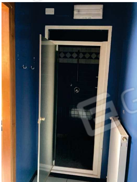
vista doccia e antibagno
