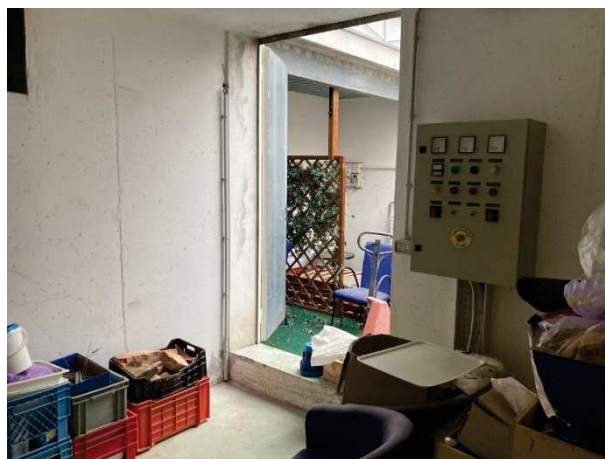
particolare interno ripostiglio comune
