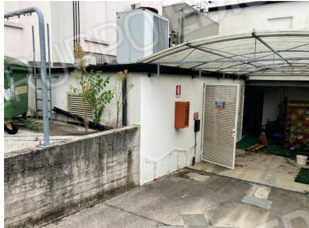
particolare locale esterno ad uso centrale termica e ripostiglio comune (bene comune non censibile)
