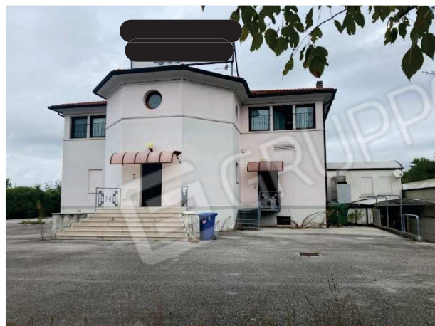
prospetto lato Sud
