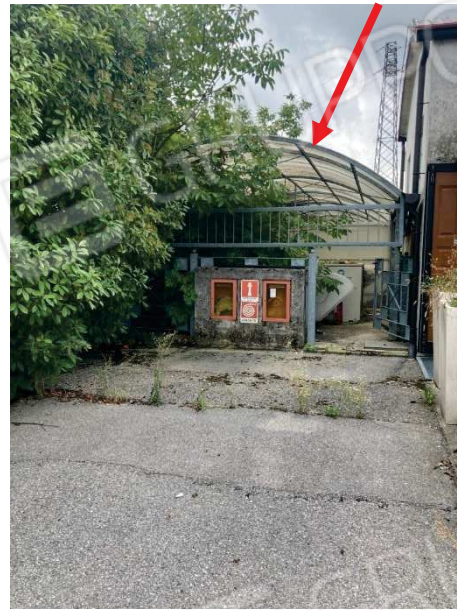
ulteriore particolare della tettoia abusiva lato Nord
