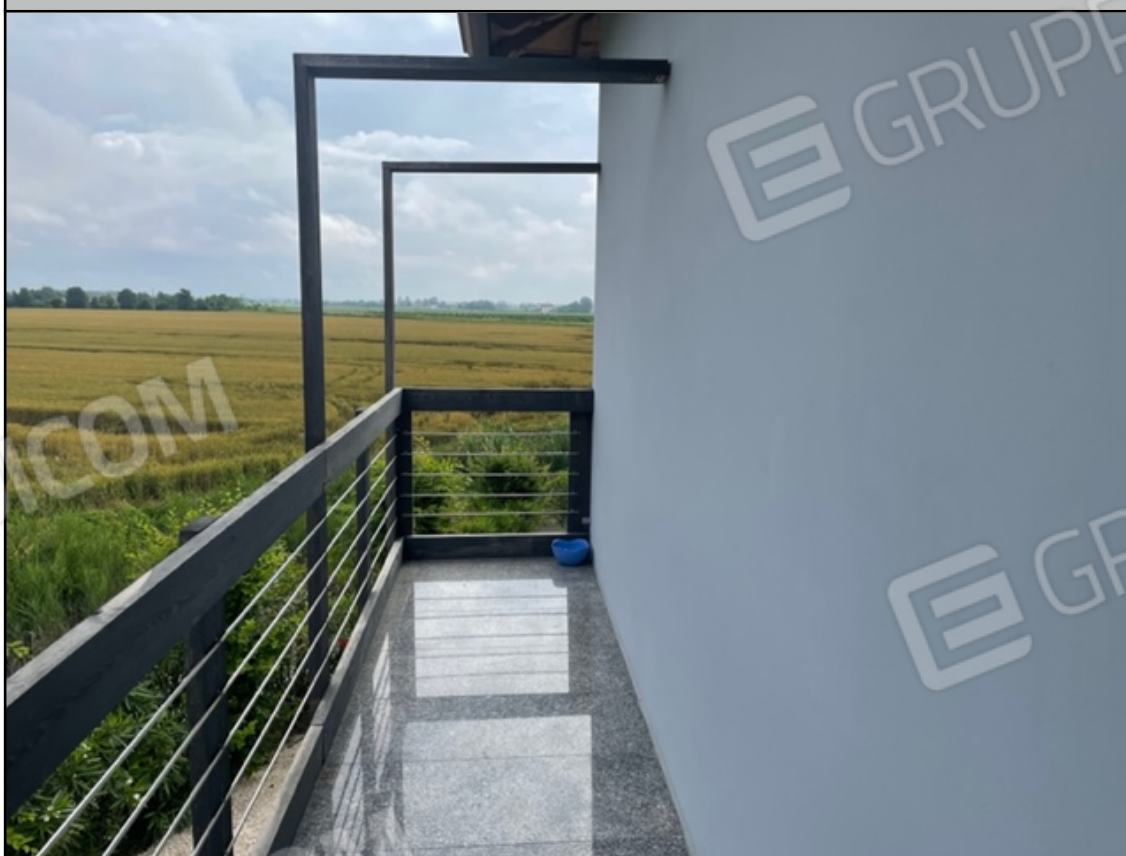
Balcone esterno, lato nord
