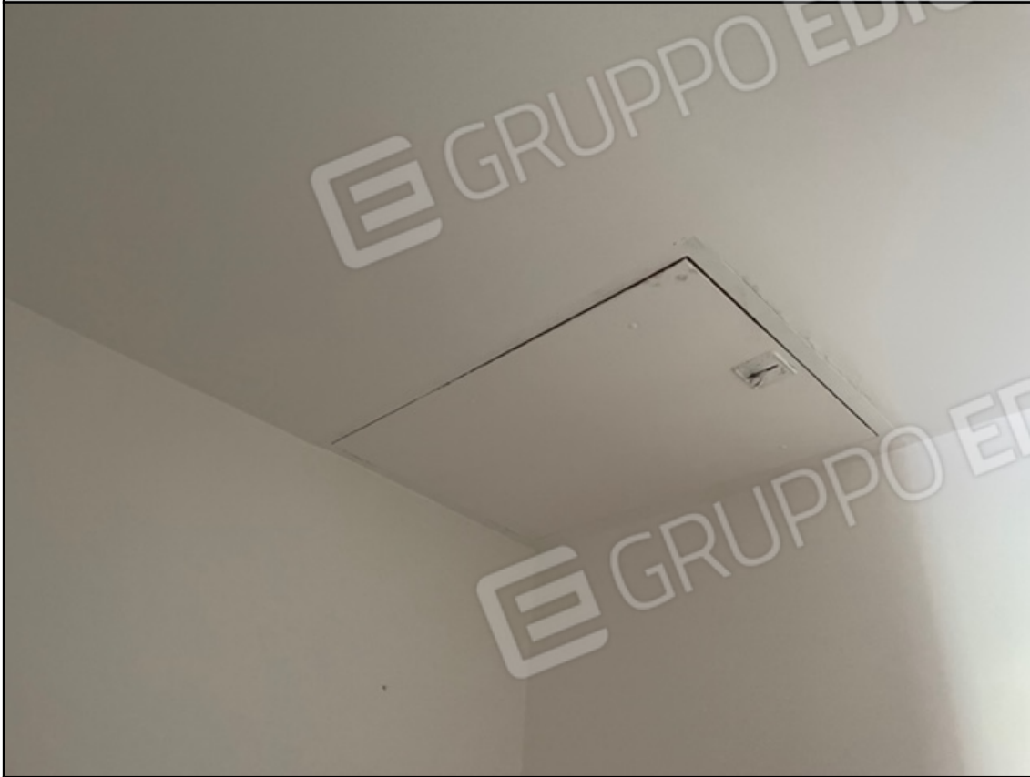
Botola per accesso a soffitta
