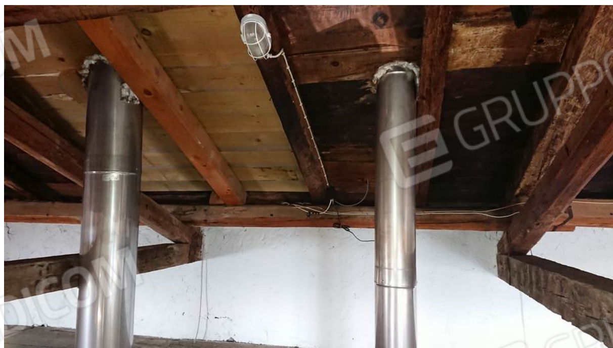
Foto n° 20 - 18/01/2022 - Comune di Caneva, foglio 21, part.156-157 – Sottotetto.
