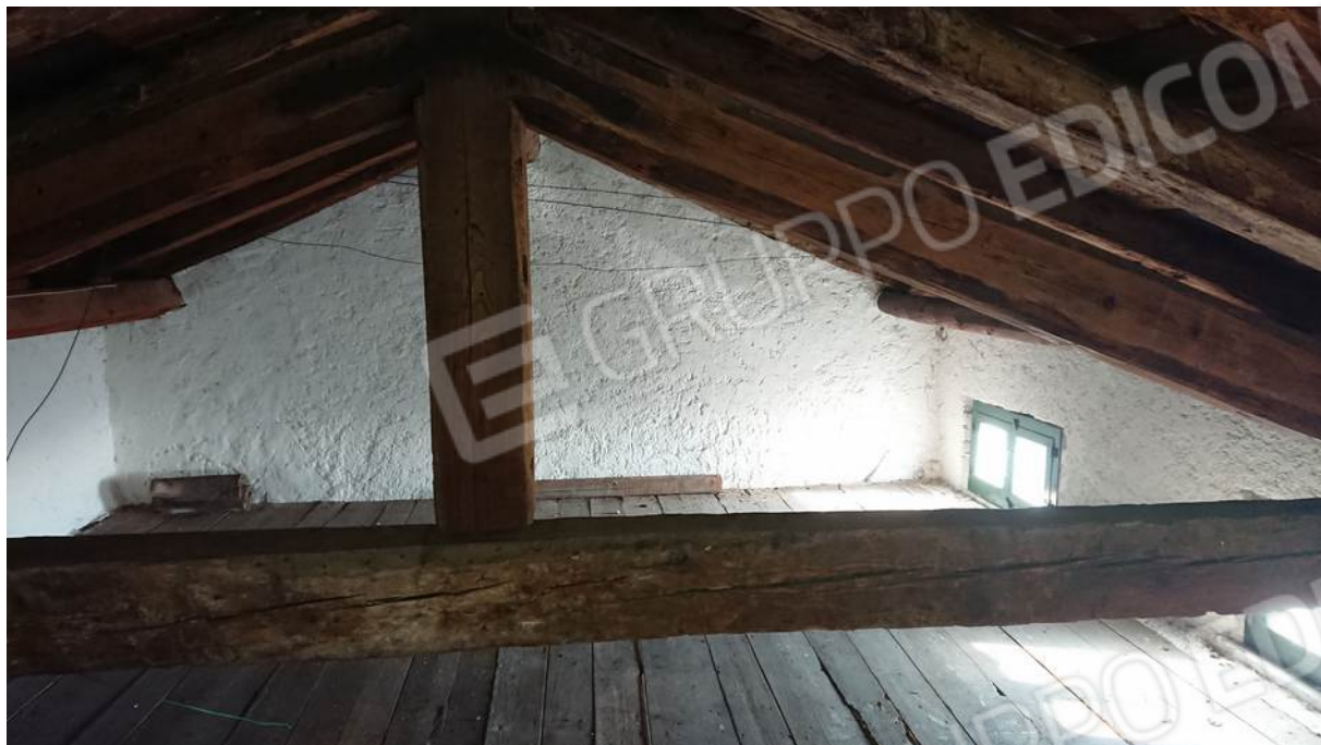
Foto n° 19 - 18/01/2022 - Comune di Caneva, foglio 21, part.156-157 – Sottotetto.
