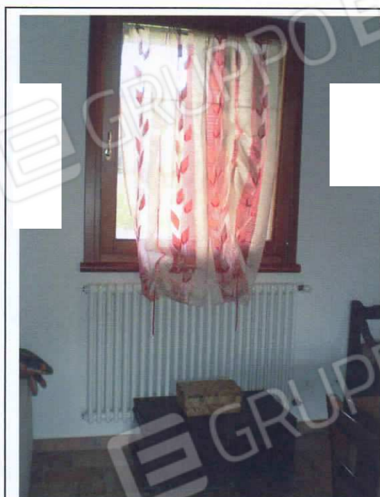
Particolare finestra e termosifone
