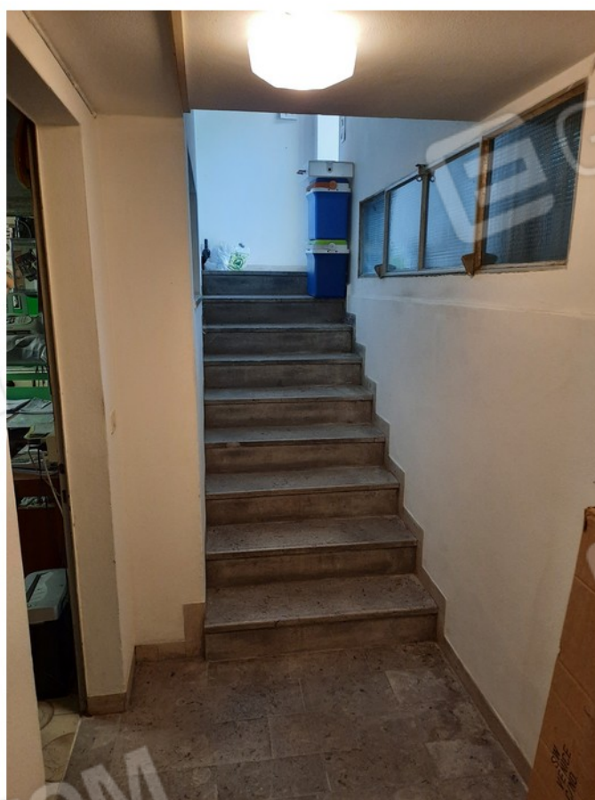
10C - vano scala al piano cantina
