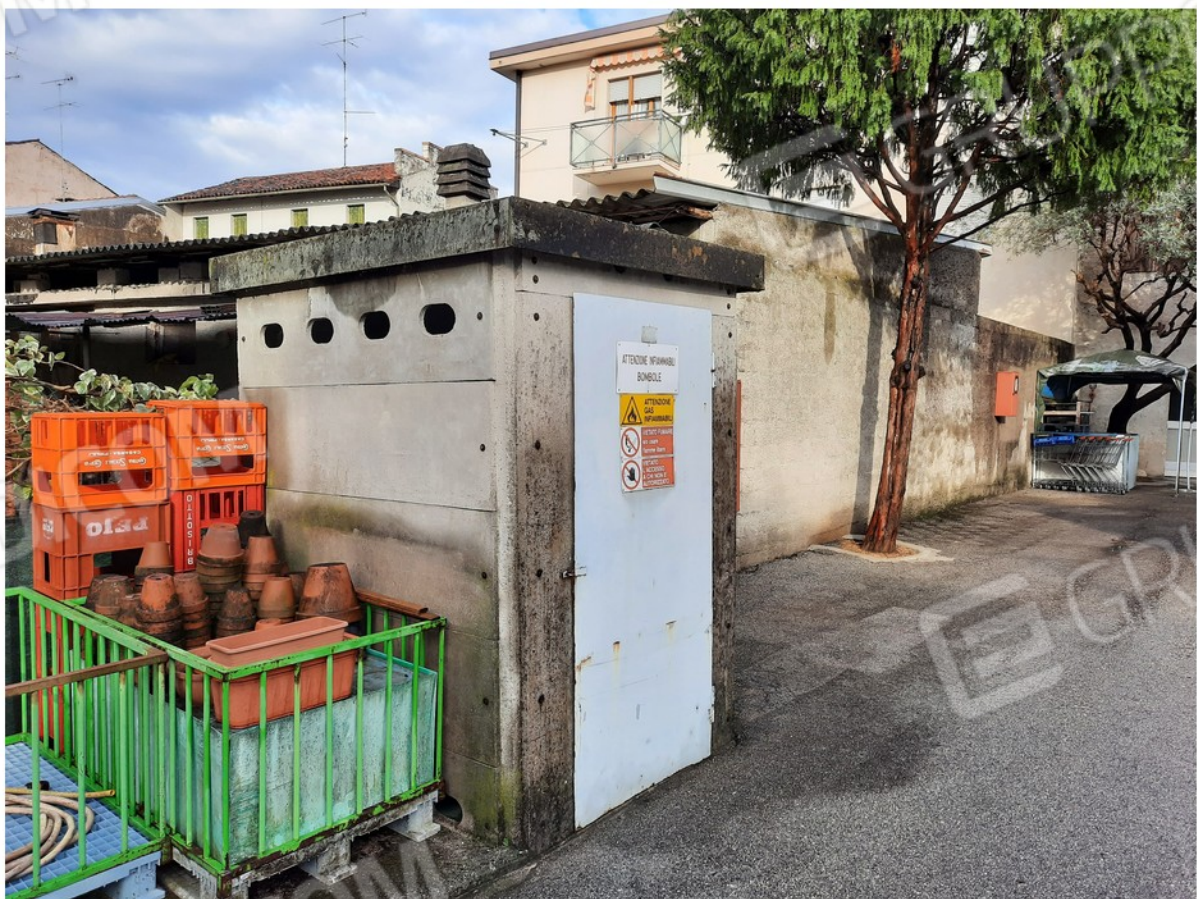
8 - esterno deposito gas
