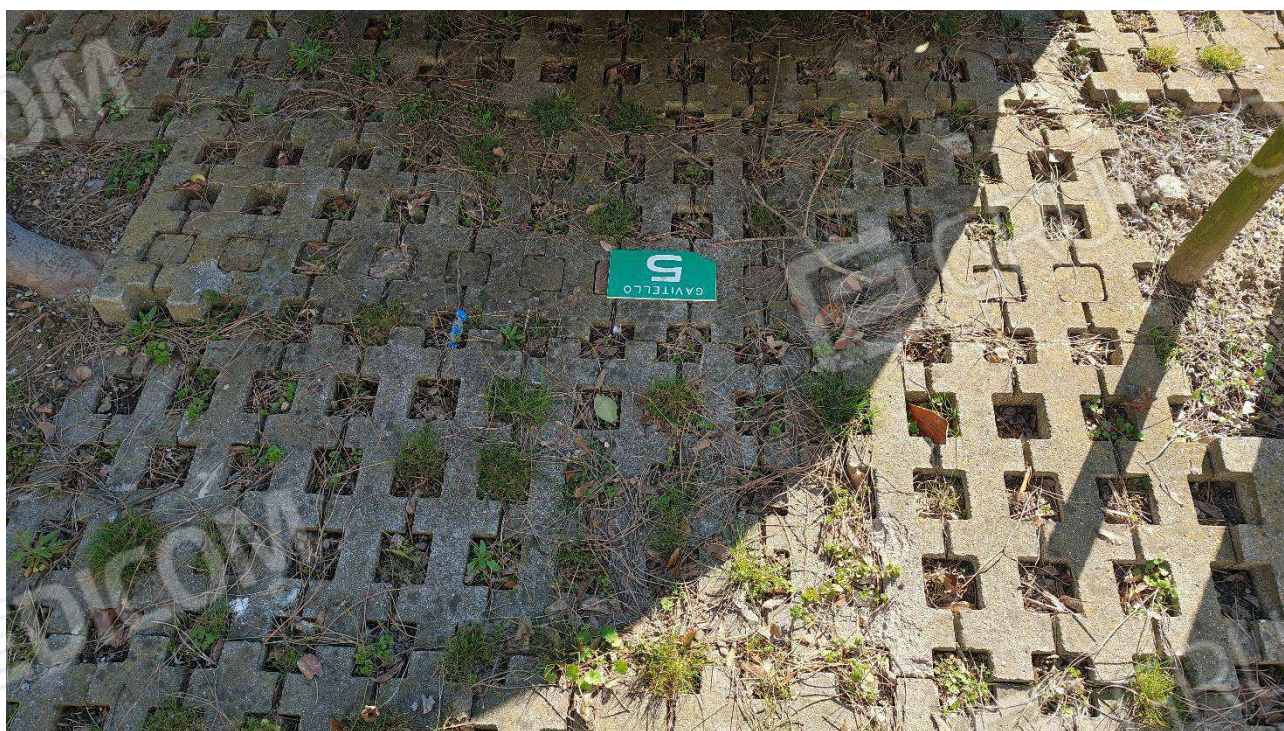
Foto n°2 – Lotto 1 – 03/03/2025 - Comune di San Michele al Tagliamento (VE) – Località Bibione Pineda - foglio 48 particella 1729 – Particolare del posto auto n. 5 riservato all'appartamento sub 5.
