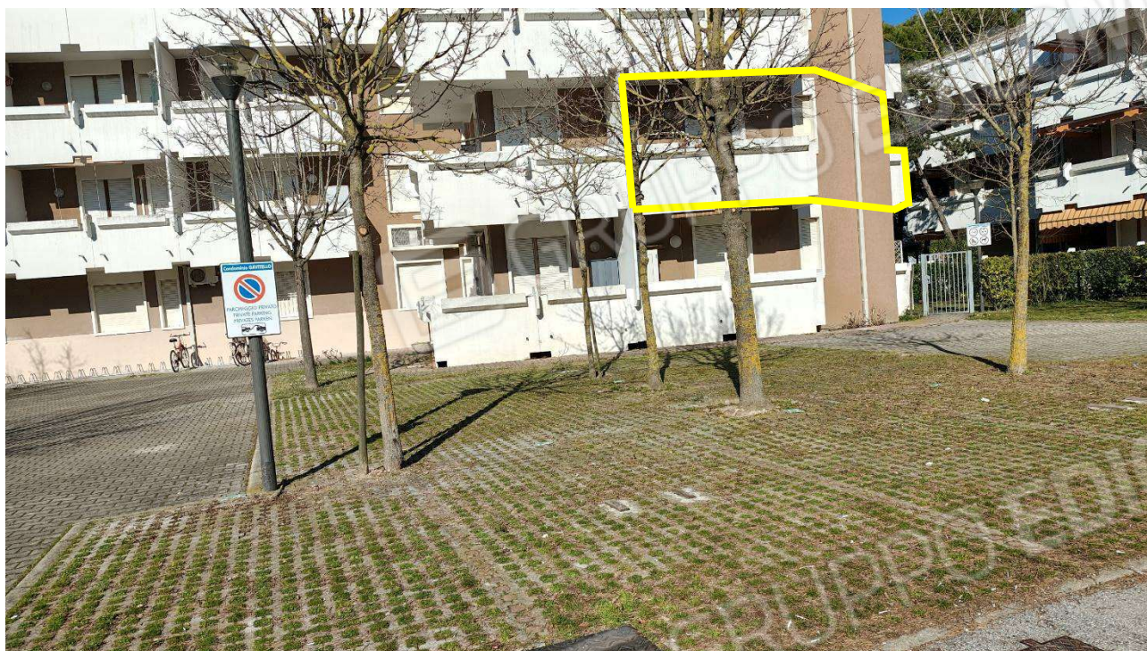
Foto n°1 – Lotto 1 – 03/03/2025 - Comune di San Michele al Tagliamento (VE) – Località Bibione Pineda - foglio 48 particella 1729 – Veduta, evidenziata in giallo, della facciata est dell'appartamento pignorato (sub 5), posto al piano primo del Condominio Gavitello. In primo piano si osservano alcuni posti auto privati ad uso esclusivo dei condomini.
