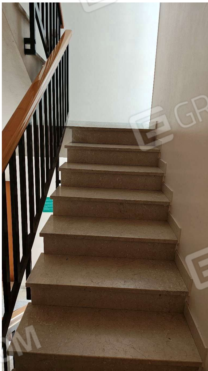
Foto n°7 – Lotto 1 – 03/03/2025 - Comune di San Michele al Tagliamento (VE) - Località Bibione Pineda - foglio 48 particella 1729 – Particolare delle scale interne che conducono all'unità immobiliare pignorata.
