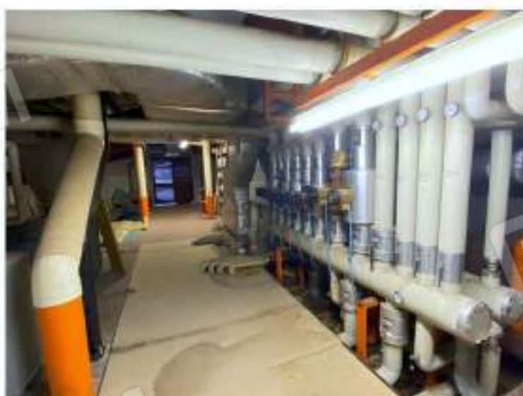
97_particolare condutture impianto di riscaldamento
