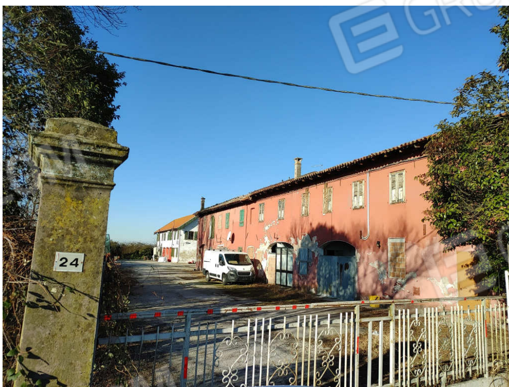
Foto 2 – vista sud est ed accesso da Via Paludi
