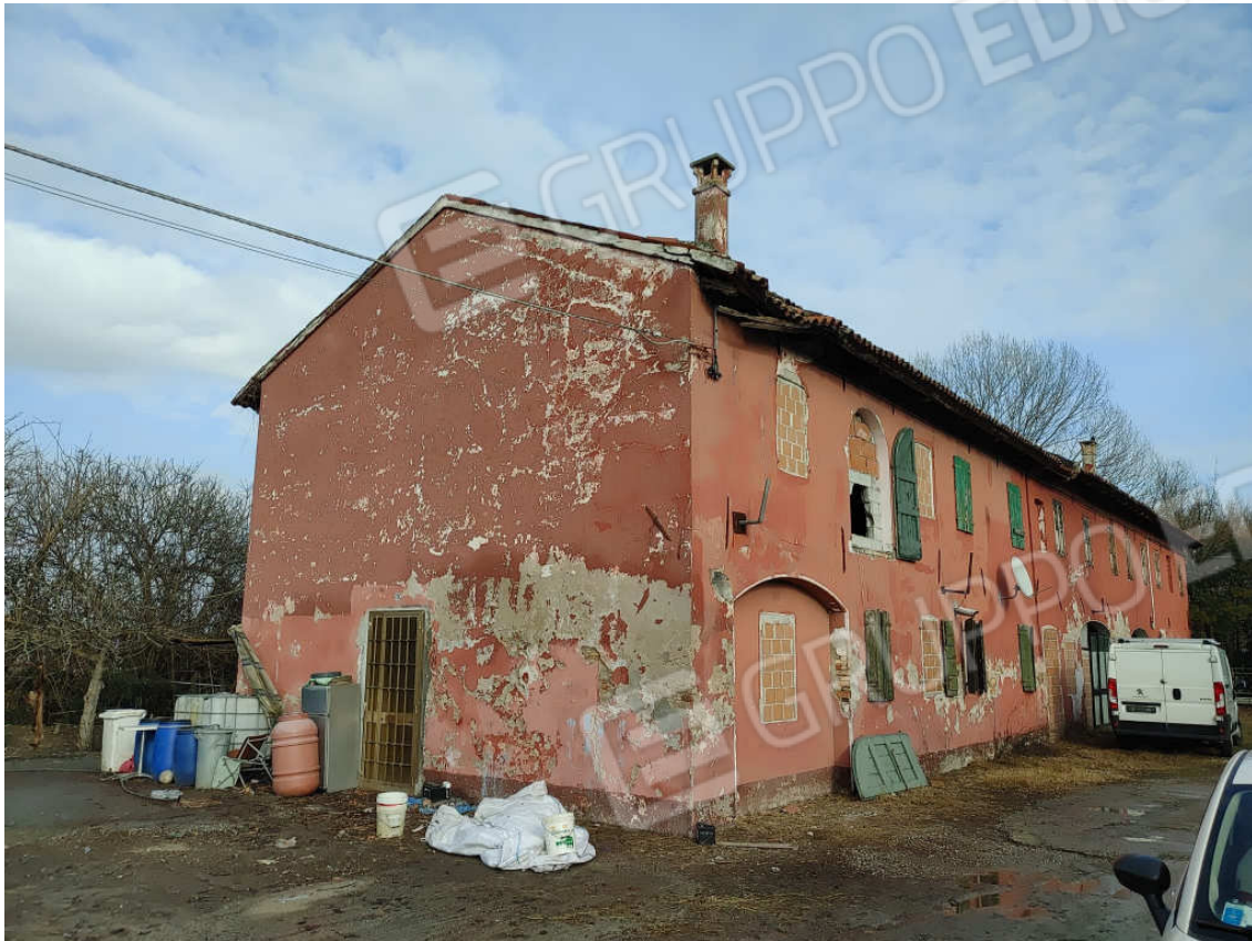
Foto 6 – Vista Sud ovest lato cortile
