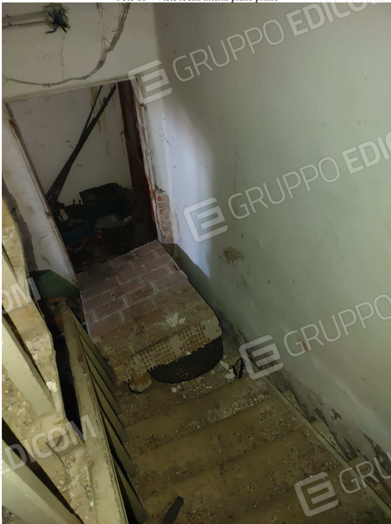
Foto 10 – Viste locali interni piano primo
