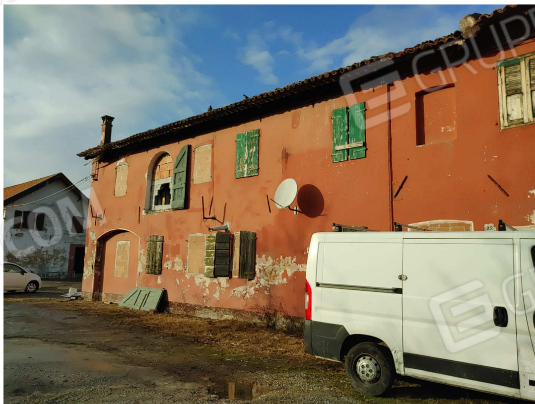
Foto 5 – Vista sud ovest Ovest – lato cortile
