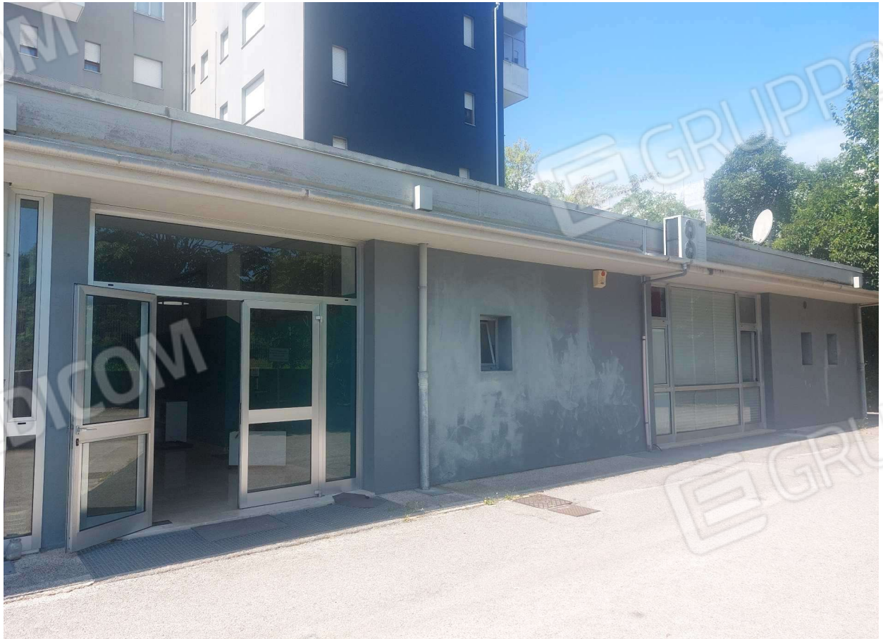
Foto n° 2 – 23/07/2025 - Comune di Pordenone, foglio 11, part.900 – Visione esterna del "Condominio Milvia".
