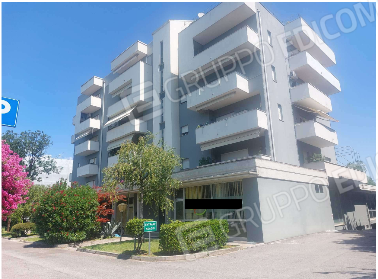
Foto n° 1 – 23/07/2025 - Comune di Pordenone, foglio 11, part.900 – Visione esterna del "Condominio Milvia".
