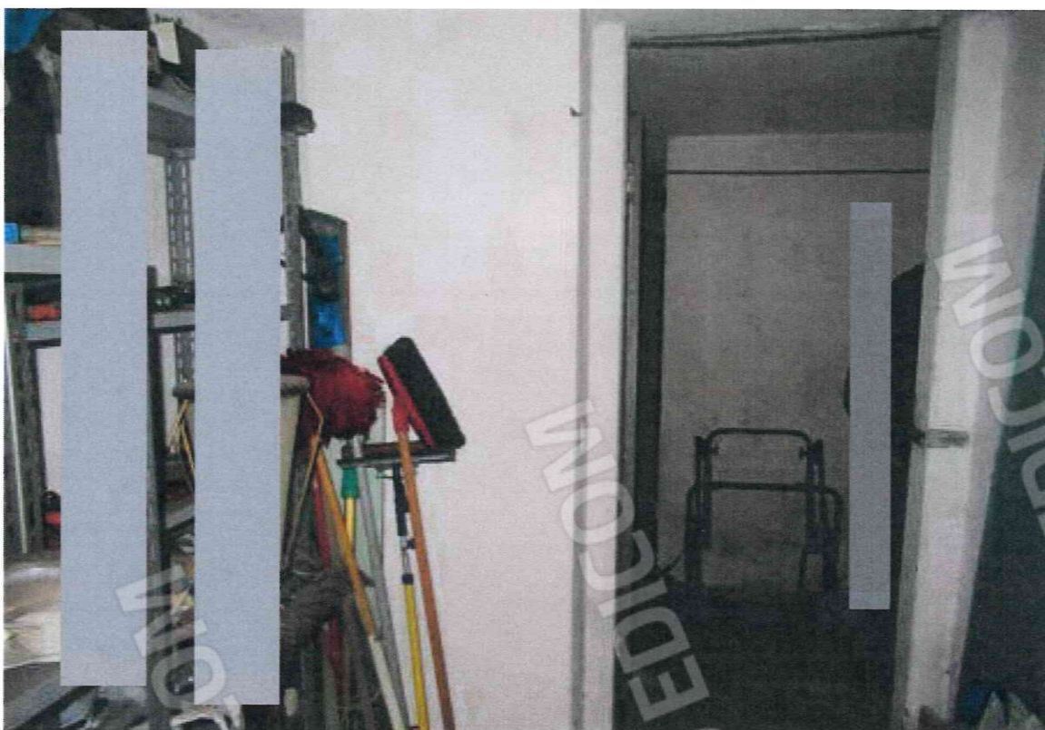
Foto 10: Cantina verso Sud
