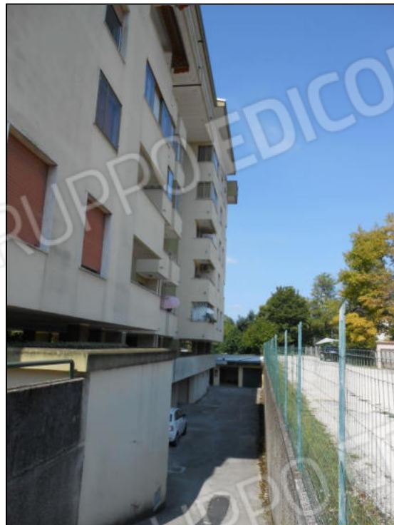
2) Rampa di accesso alle autorimesse
