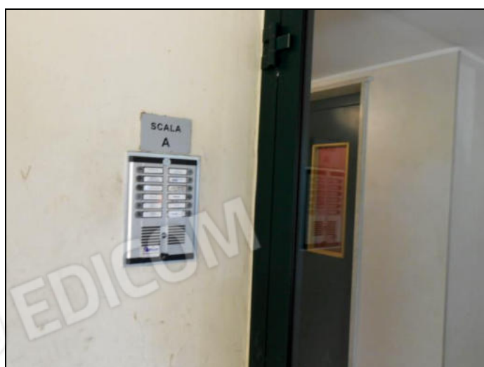
12) Portone ingresso scala A
