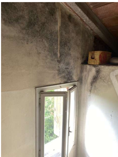
vista interna muratura nel vano scala con presenza di muffa
