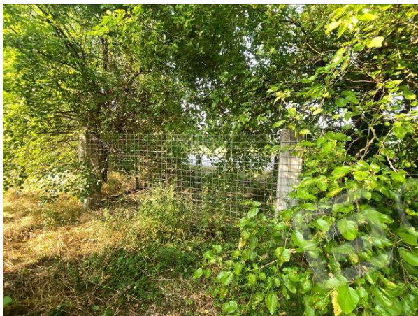
ulteriore vista accesso carraio non terminato
