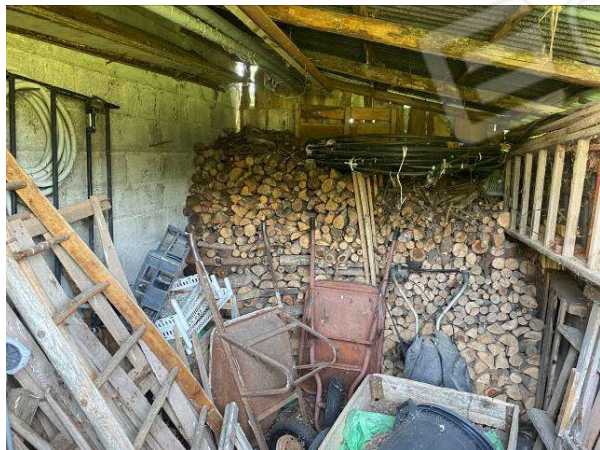
vista interna deposito
