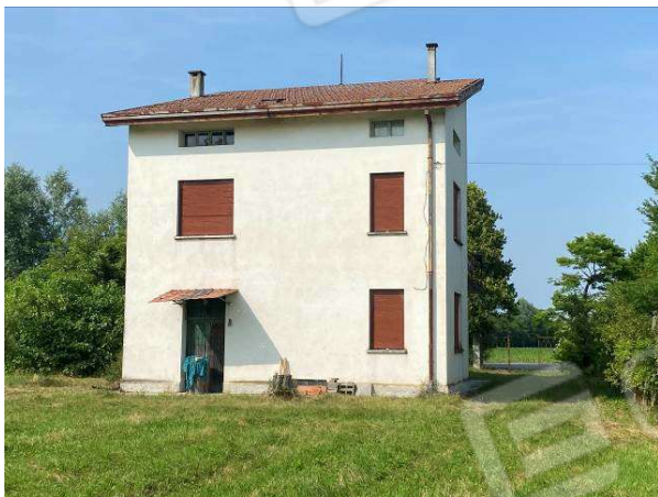
prospetto sud/est dell'immobile
