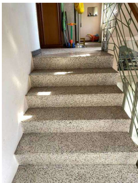
vista vano scala comune al primo piano
