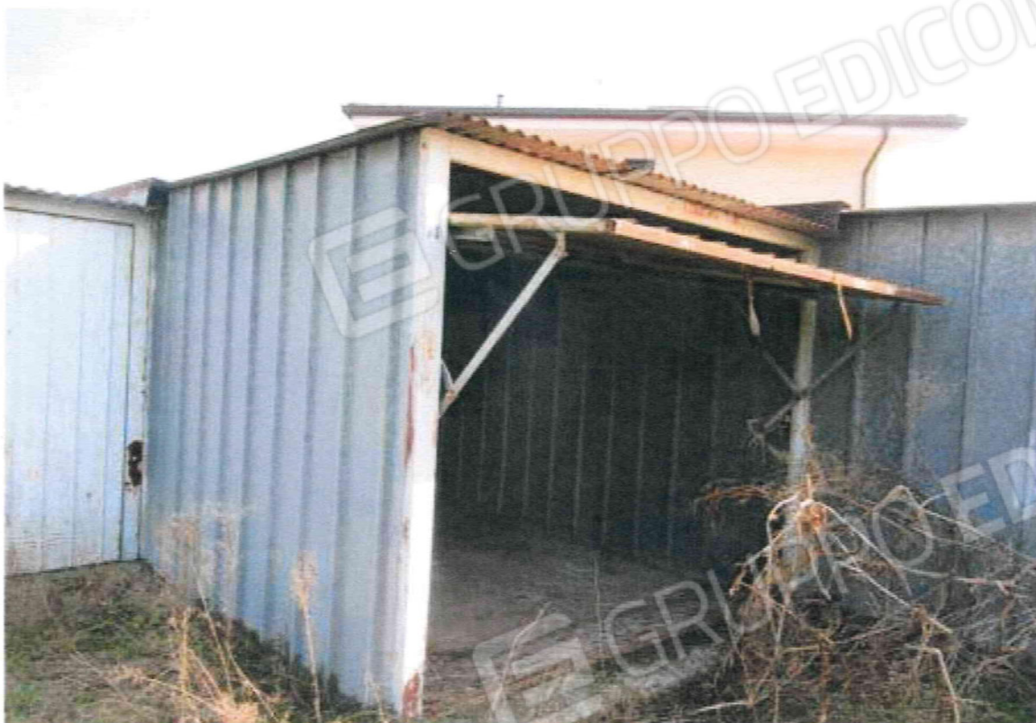
Foto 1: Accesso al garage
