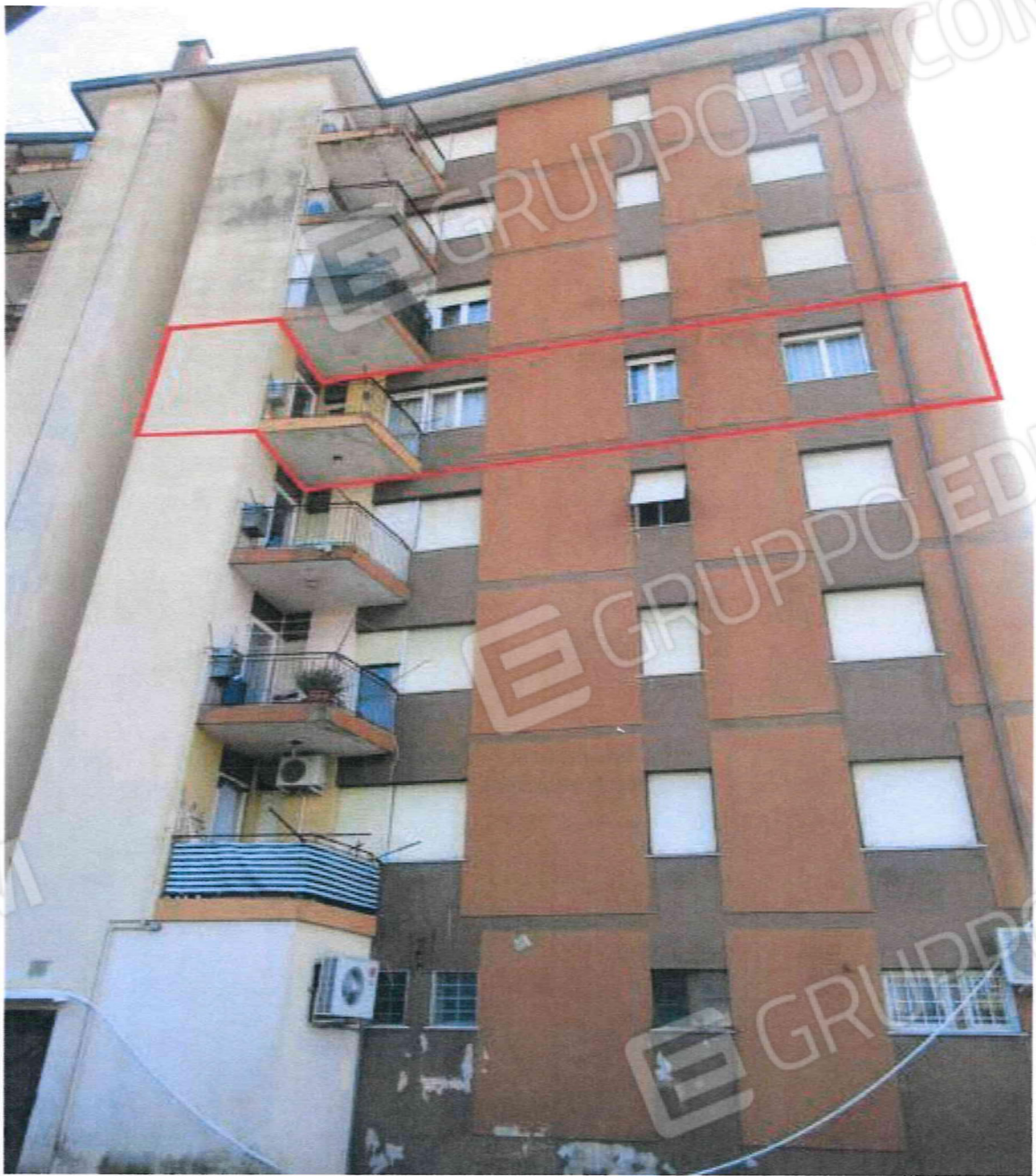
Foto 1: Prospetto Sud appartamento
