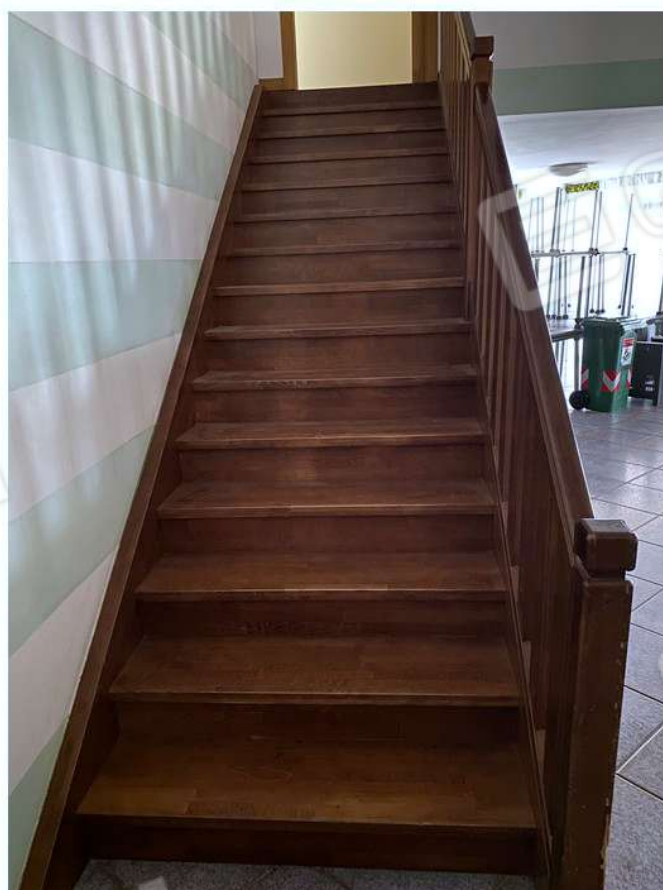
30 - Scala di collegamento tra piano terra e primo
