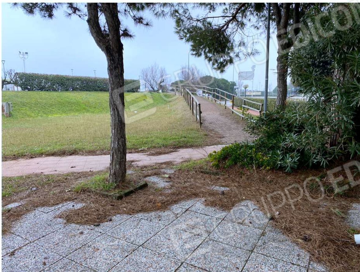
15 - Vialeto pedonale pubblico di collegamento ai percorsi pedonale e ciclabile paralleli la spiaggia nonchè ad essa
