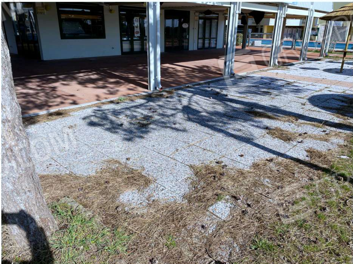
10 - Vista sul dehors prospiciente il fronte principale dell'attività e parte dell'area pavimentata su area demaniale
