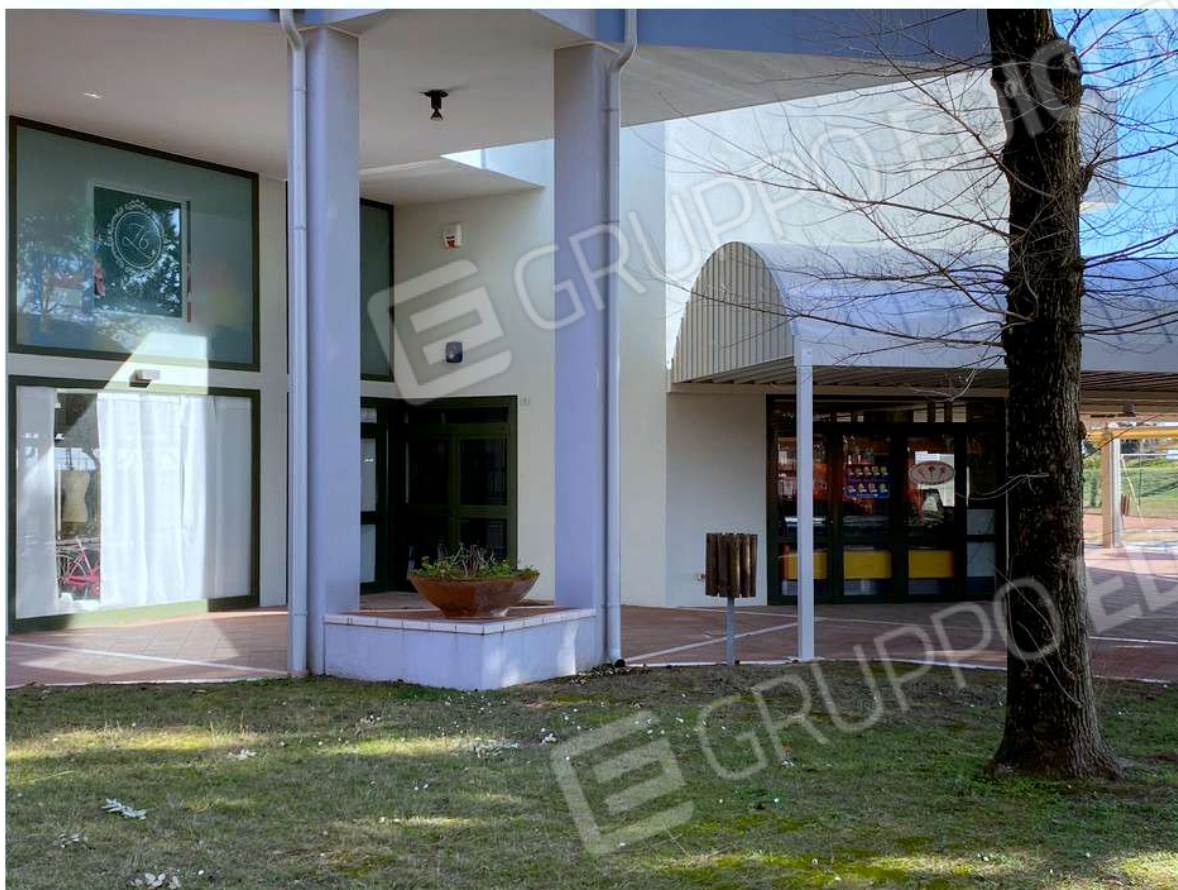
3 -Fianco Ovest, particolare porzione di dehors in continuità con il porticato aperto al pubblico dell'intero fabbricato
