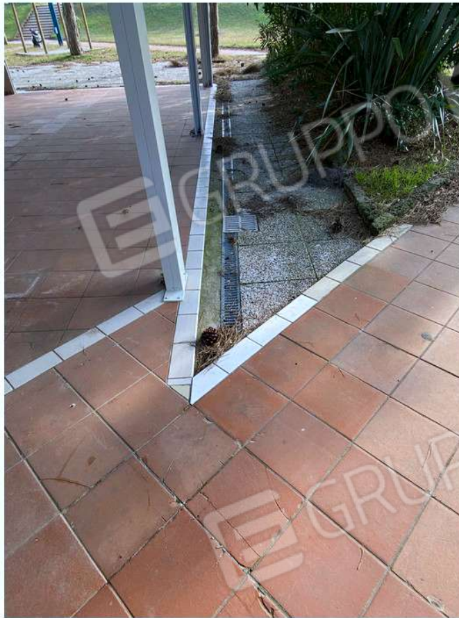
9 - Porzione di pavimentazione esterna attigua all'unità in oggetto e pilastri relativi alla struttura di copertura dell'area dehors
