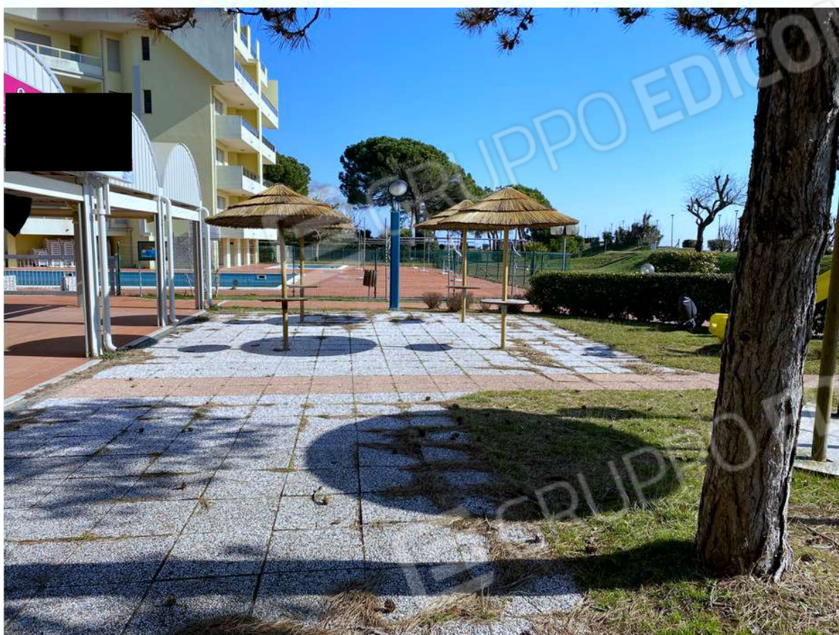
7 - Vista su area esterna in direzione Ovest Est
