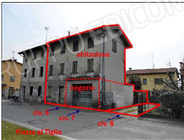
2) Ingresso abitazione al civico n. 6
