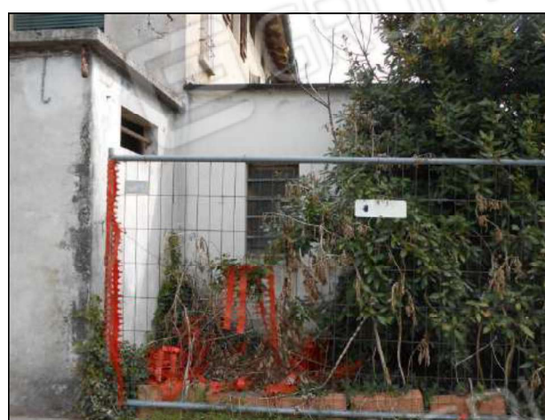
9) Veduta scoperto da area urbana
