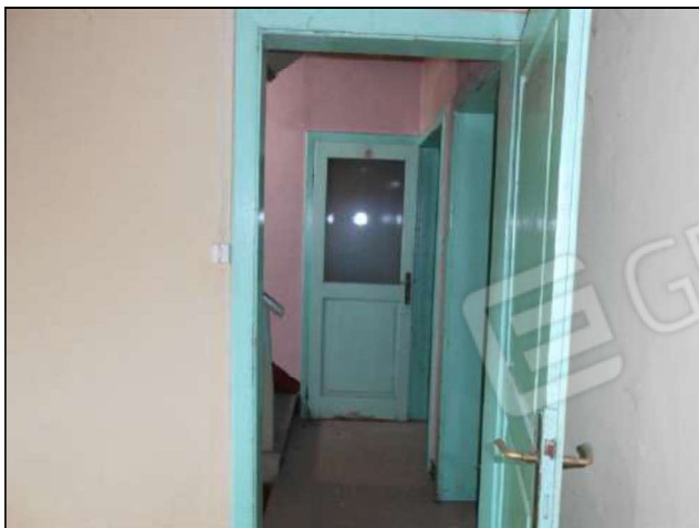
27) Veduta disimpegno da camera 1
