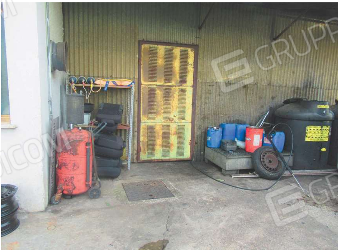
Foto 12: Parete esterna ripostiglio in plexiglass
