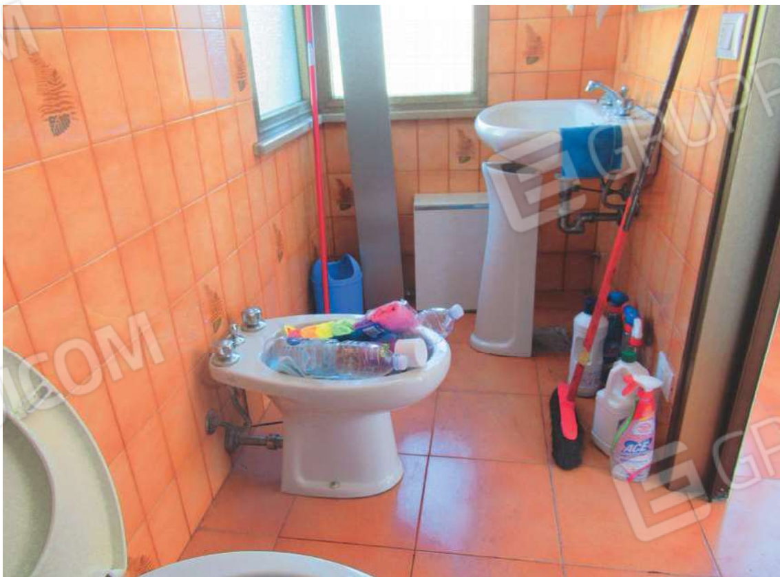
Foto 18: Wc contiguo al magazzino
