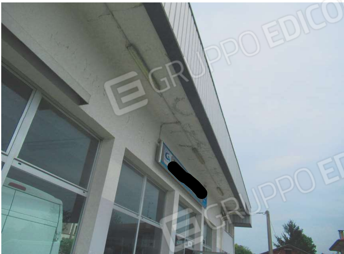
Foto 5: Infiltrazione copertura
