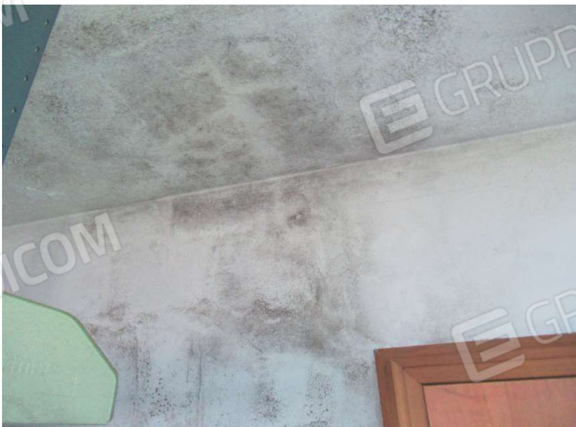
Foto 28: Infiltrazioni copertura
