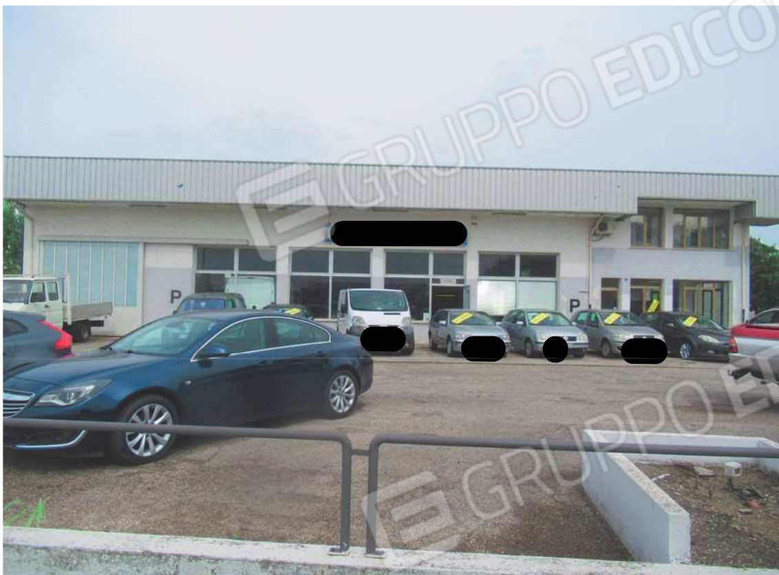
Foto 1: Prospetto Sud-Est autofficina
