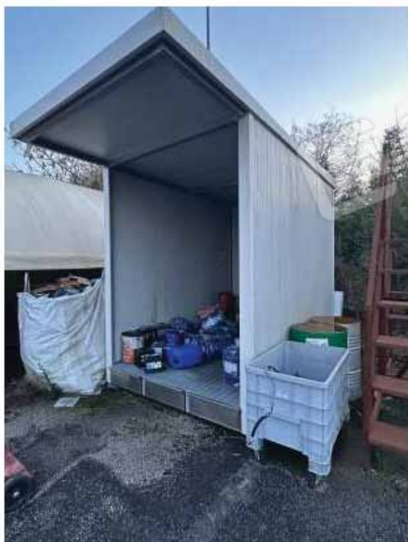
ID 0293: Contenitore Industriale HDPE grigio con ruote; ID 0291: prefabbricato leggero ad uso deposito chiuso su tre lati (struttura metallica e tamponamento monopanel) 4000x2000 con vasca raccogliitore olio e gocciolatoio
