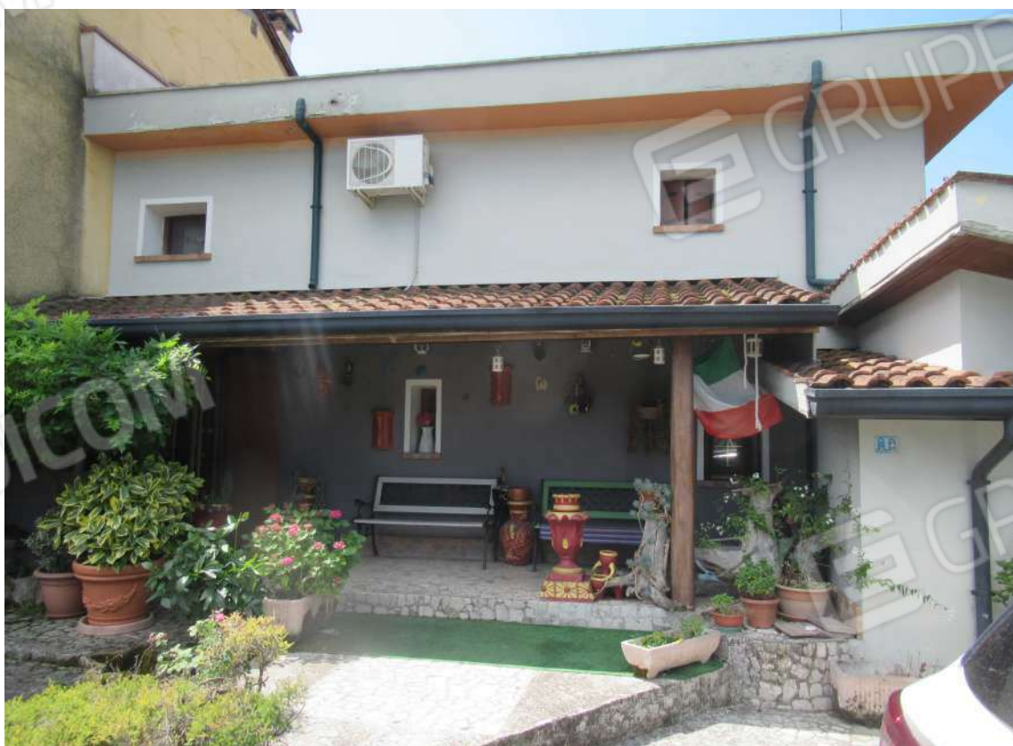
Foto 4: Prospetto Nord abitazione
