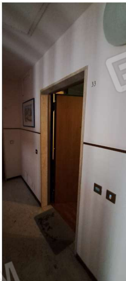
6_ingresso da vano scala
