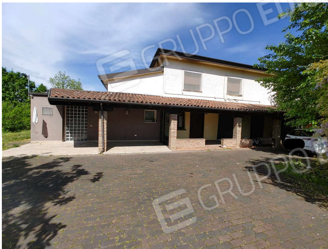
Foto 4 – vista fabbricato dal cortile lato sud
