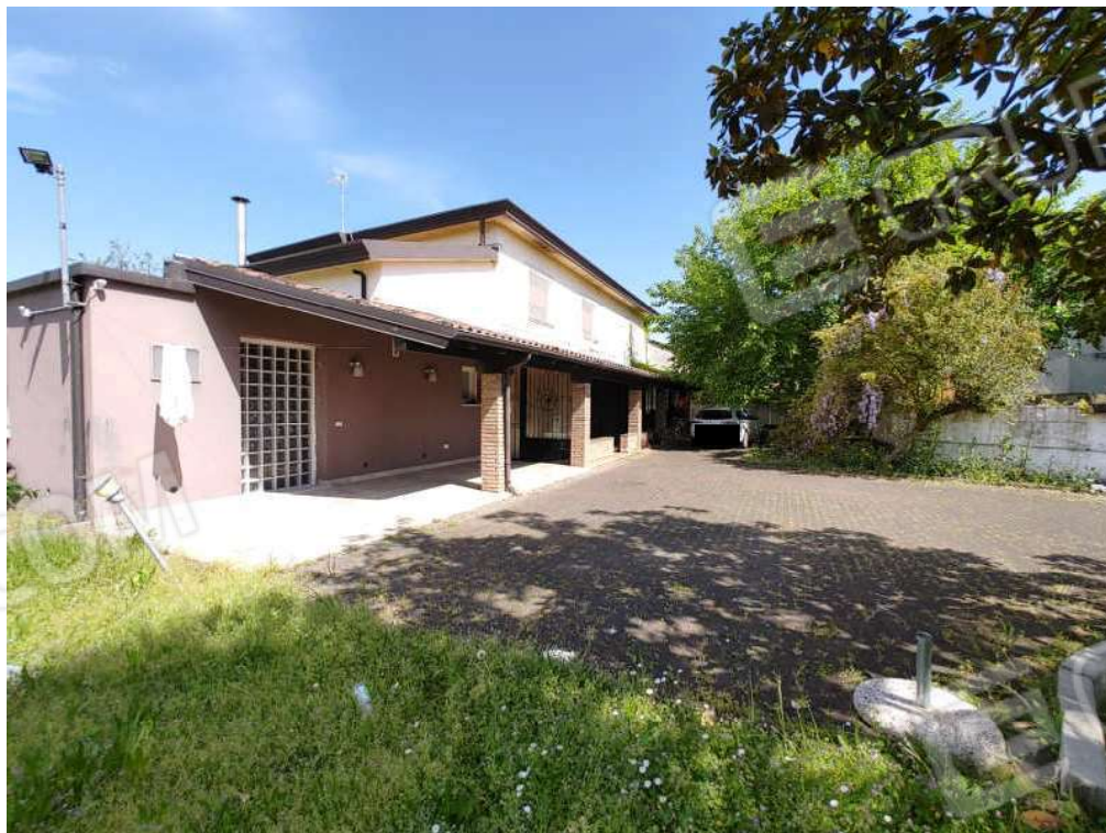
Foto 5 – Vista lato ovest fabbricato
