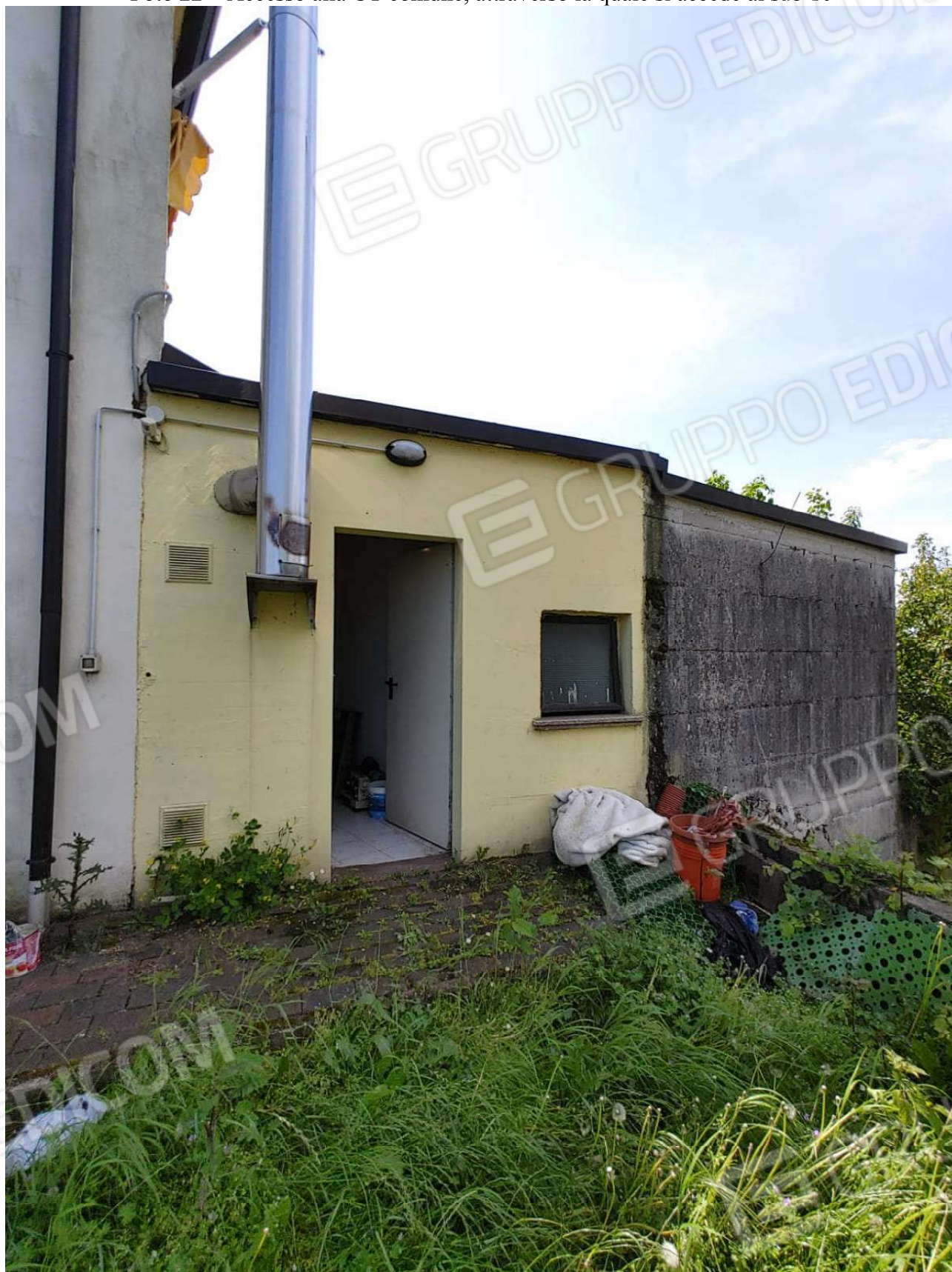
Foto 22 – Accesso alla CT comune, attraverso la quale si accede al sub 10
