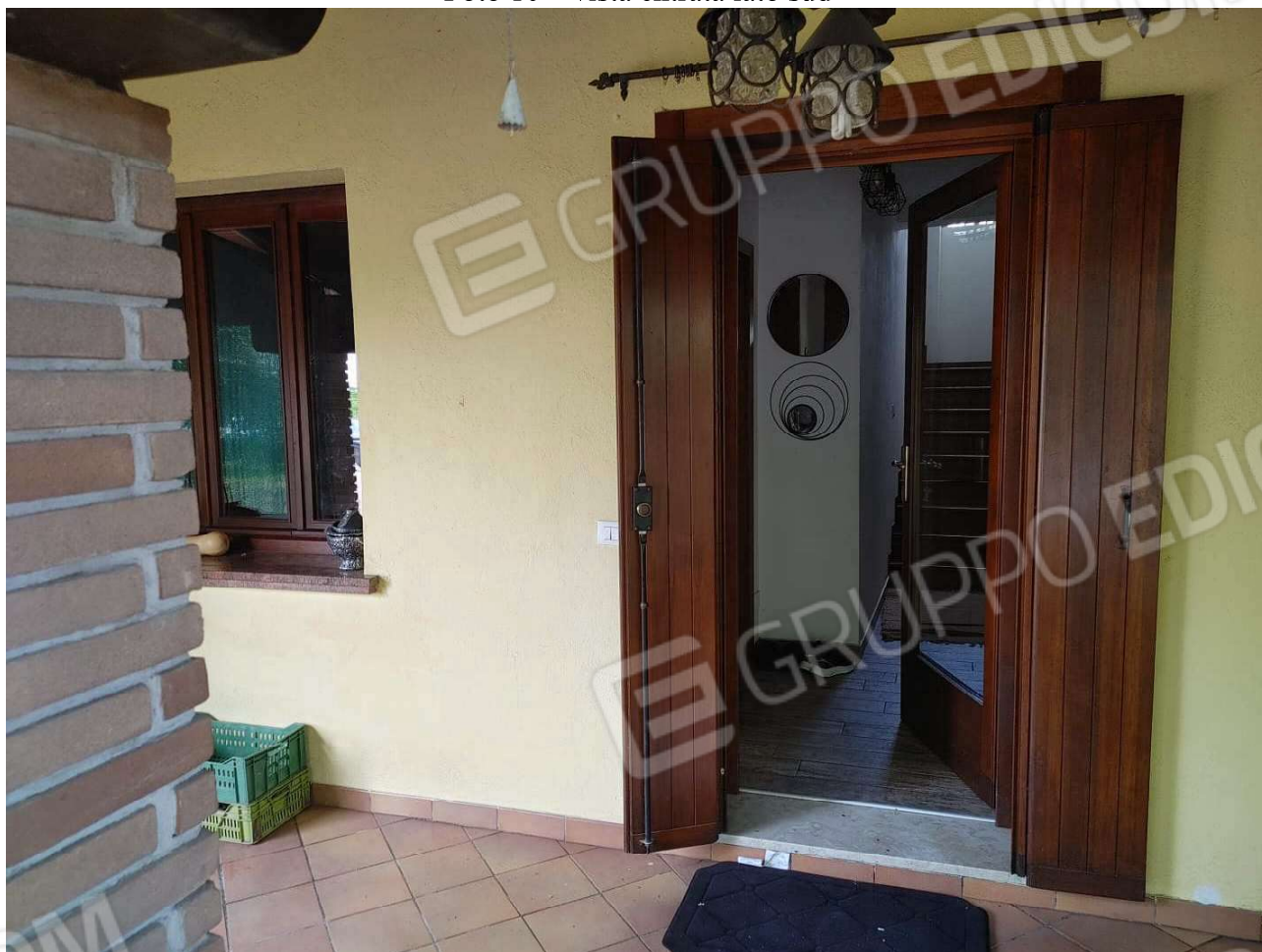
Foto 10 – vista entrata lato sud
