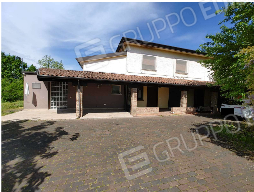
Foto 4 – vista fabbricato dal cortile lato sud
