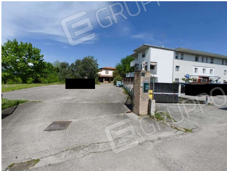
Foto 1 – Accesso lato sud da Via Vallenoncello
