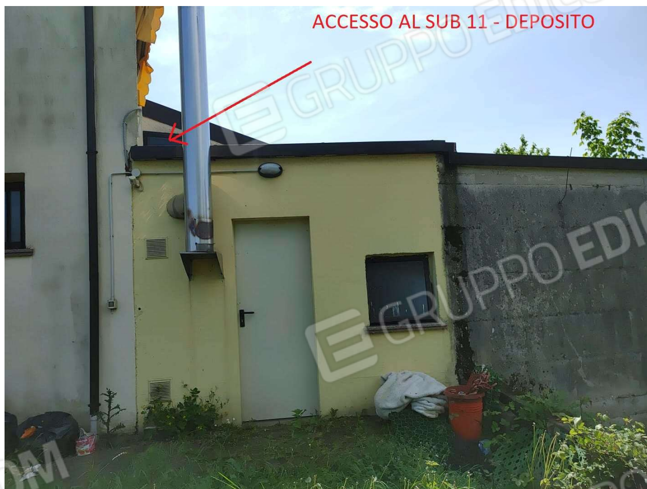
Foto 22 – vista UNICO ACCESSO ESTERNO AL SUB 11
