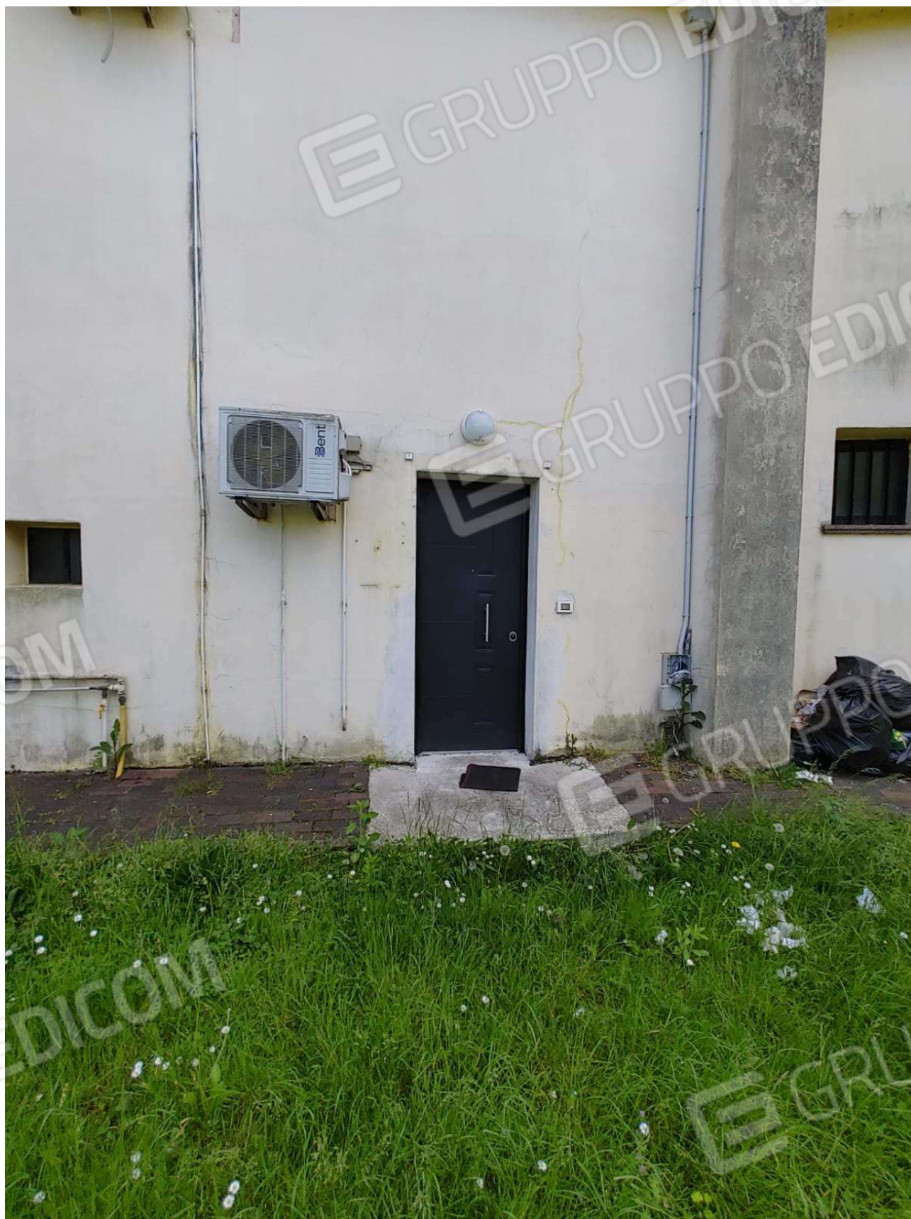
Foto 8 – vista entrata lato nord
