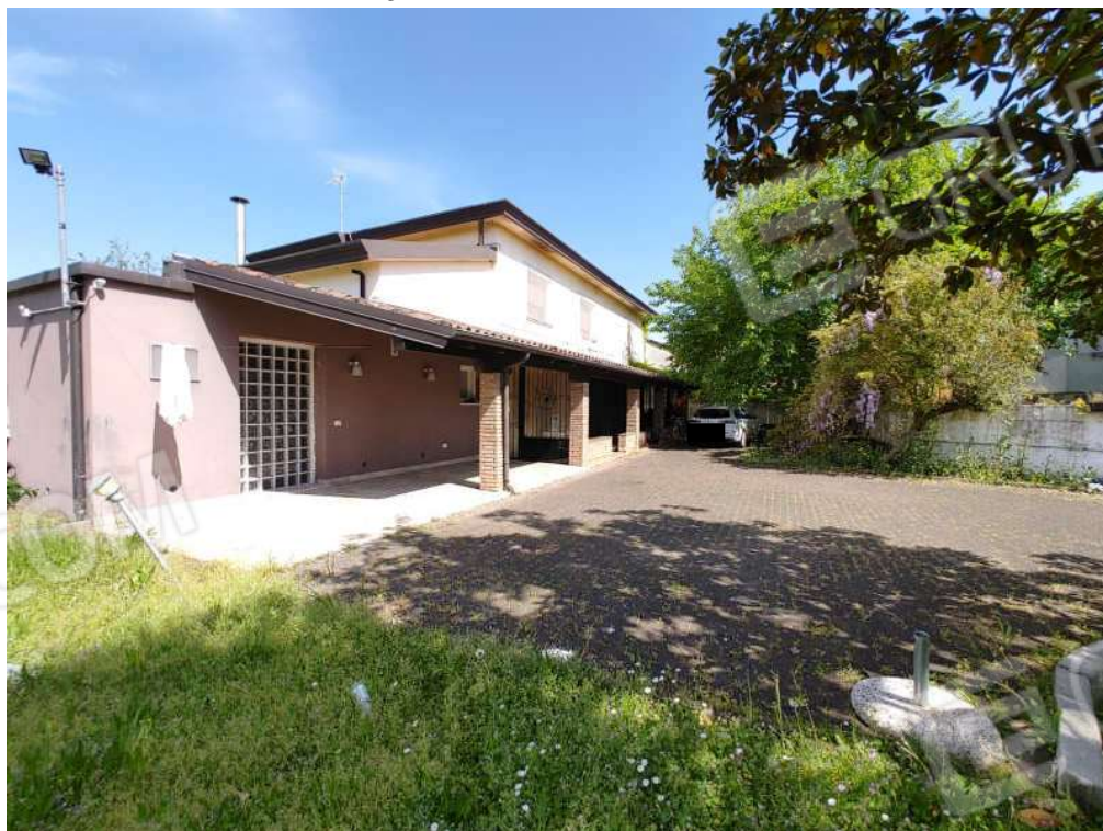
Foto 5 – Vista lato ovest fabbricato
