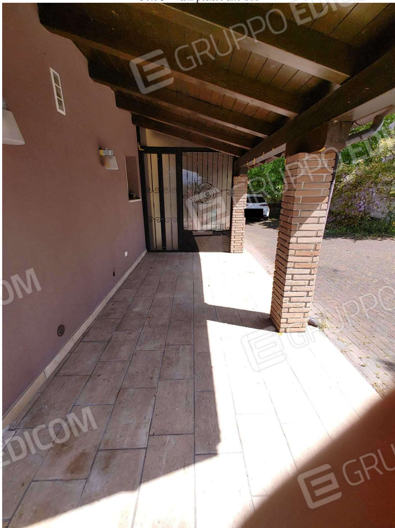
Foto 3 – vista portico lato Sud
