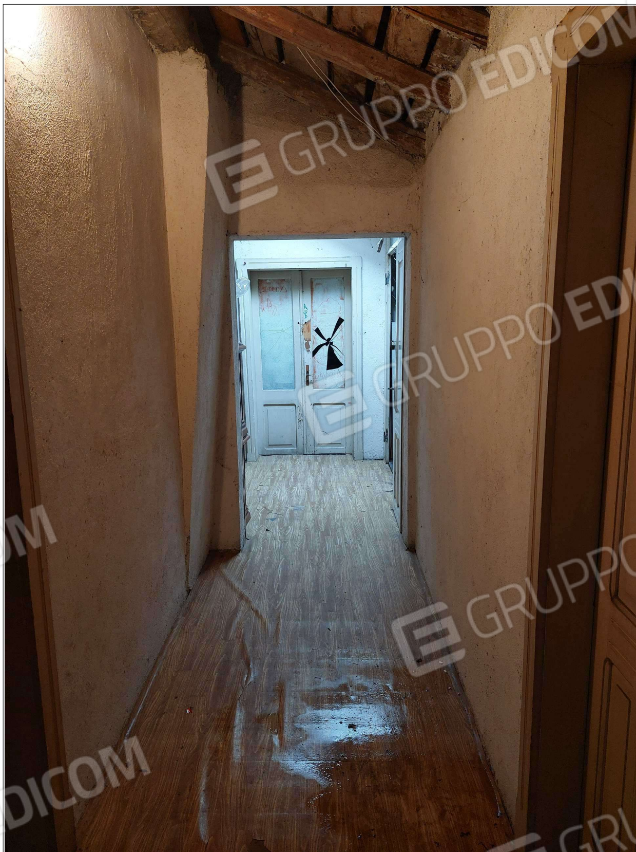
Foto n° 21 – 16/04/2025 - Comune di Maniago, foglio 21, part.54 – Corridoio della soffitta.
