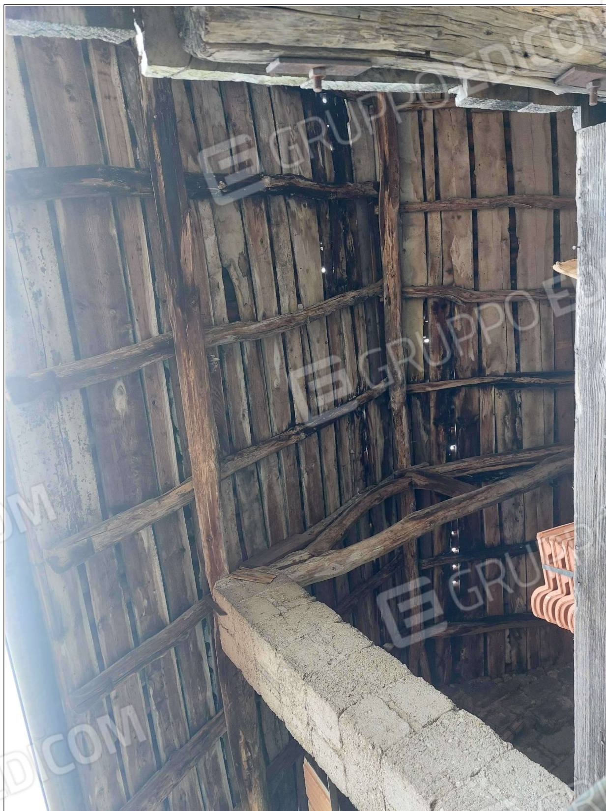
Foto n° 32 – 16/04/2025 - Comune di Maniago, foglio 21, part.54, sub.6 – Tetto di copertura.
