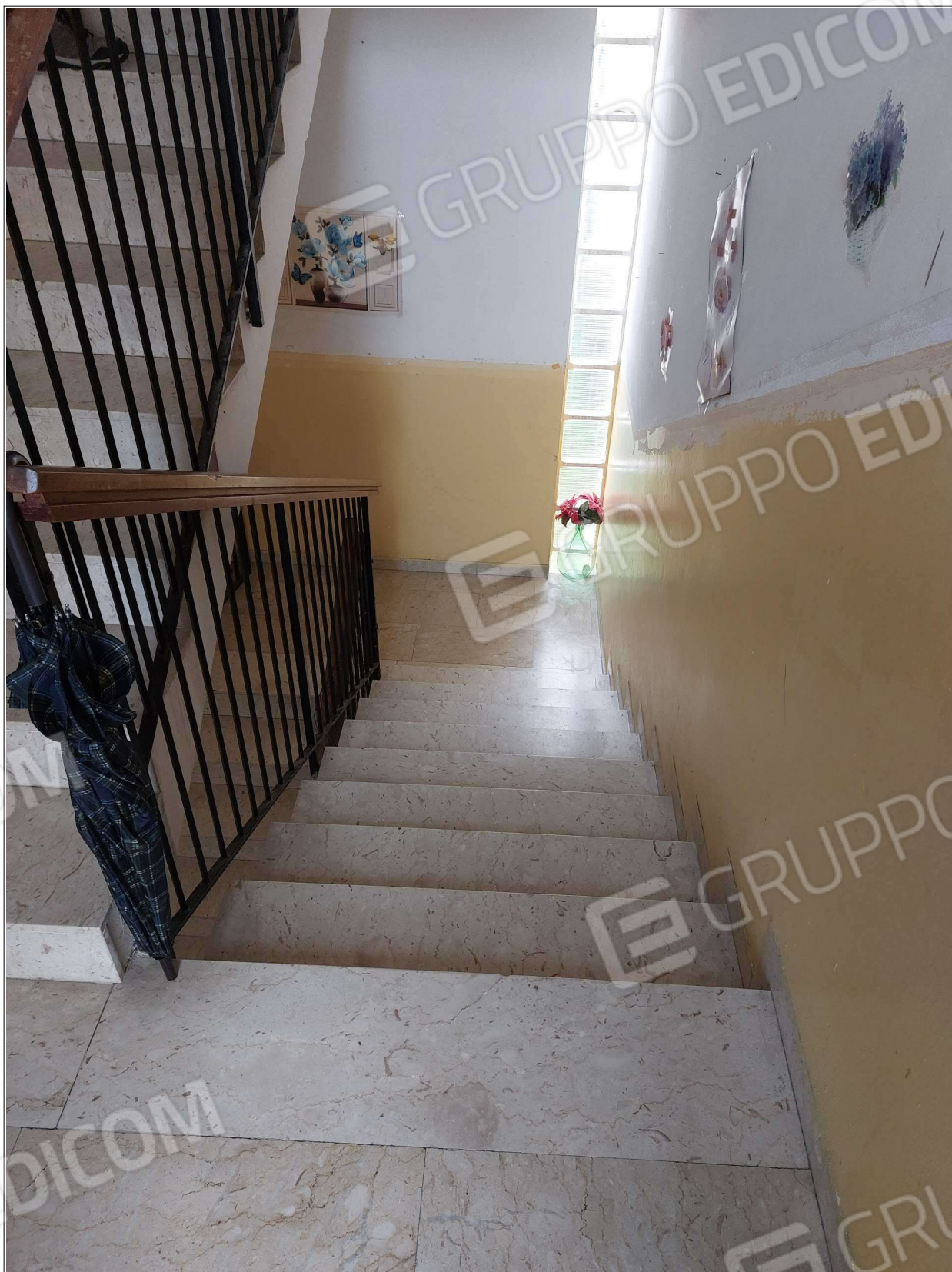
Foto n° 3 – 16/04/2025 - Comune di Maniago, foglio 21, part.54 – Vano scale condominiale.
