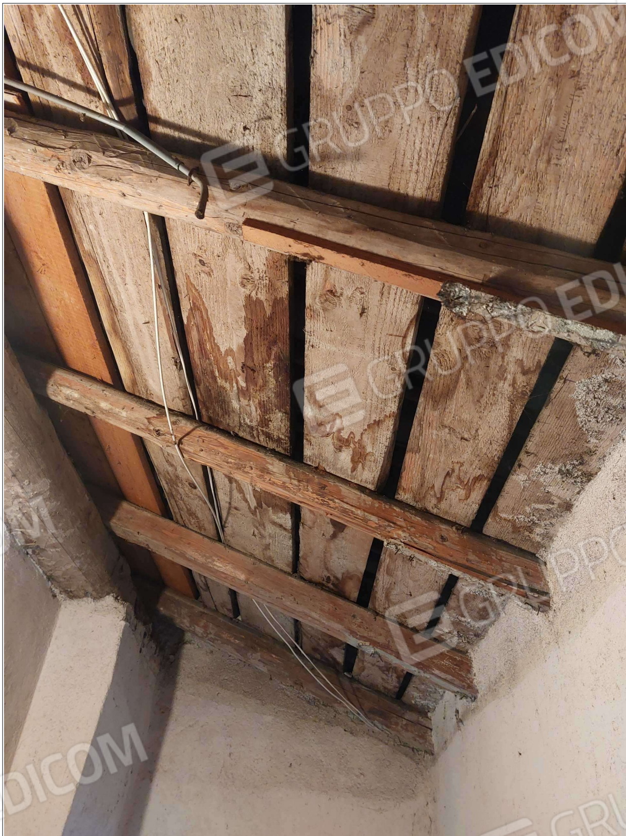
Foto n° 22 – 16/04/2025 - Comune di Maniago, foglio 21, part.54 – Particolare del tetto, come visibile dalla soffitta.
