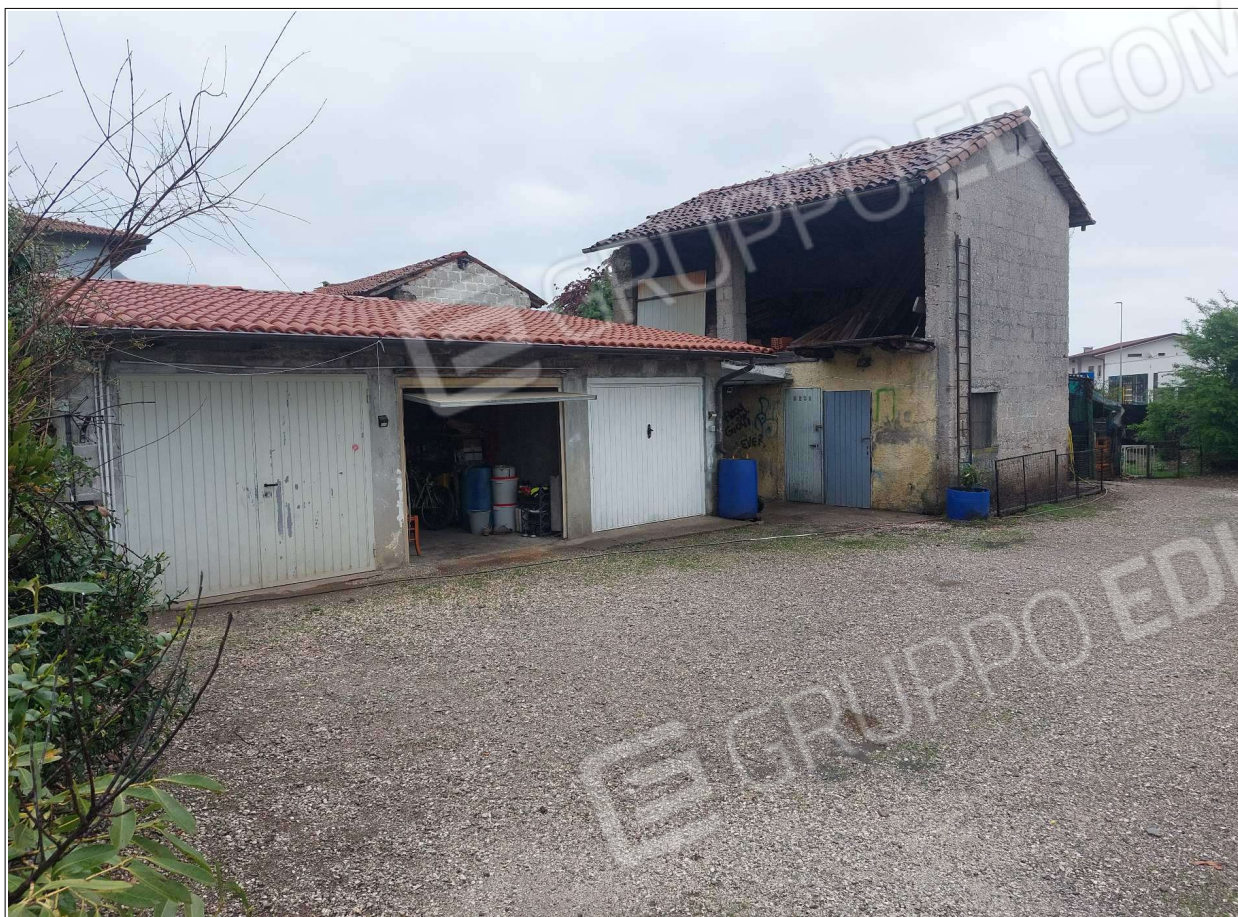
Foto n° 25 – 16/04/2025 - Comune di Maniago, foglio 21, part.54, sub.5 – Tettoia; visione generale.
