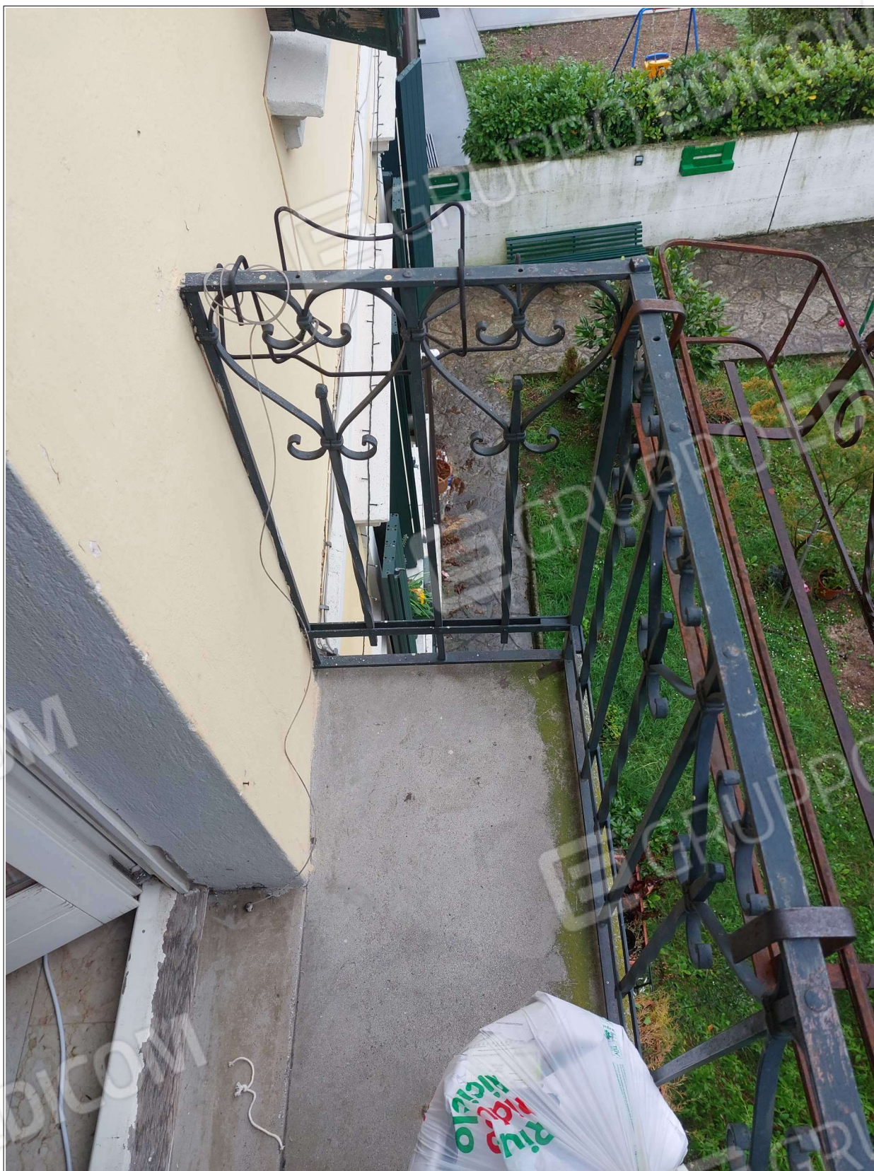
Foto n° 19 – 16/04/2025 - Comune di Maniago, foglio 21, part.54, sub.5 – Balcone con accesso dal soggiorno.
