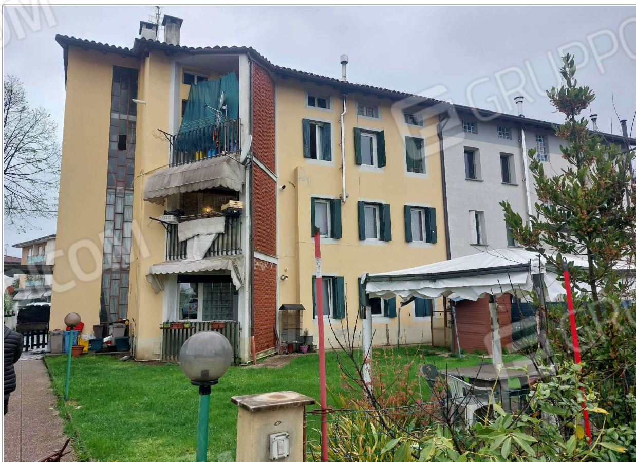
Foto n° 29 – 16/04/2025 - Comune di Maniago, foglio 21, part.54 – Retro dell' edificio.
