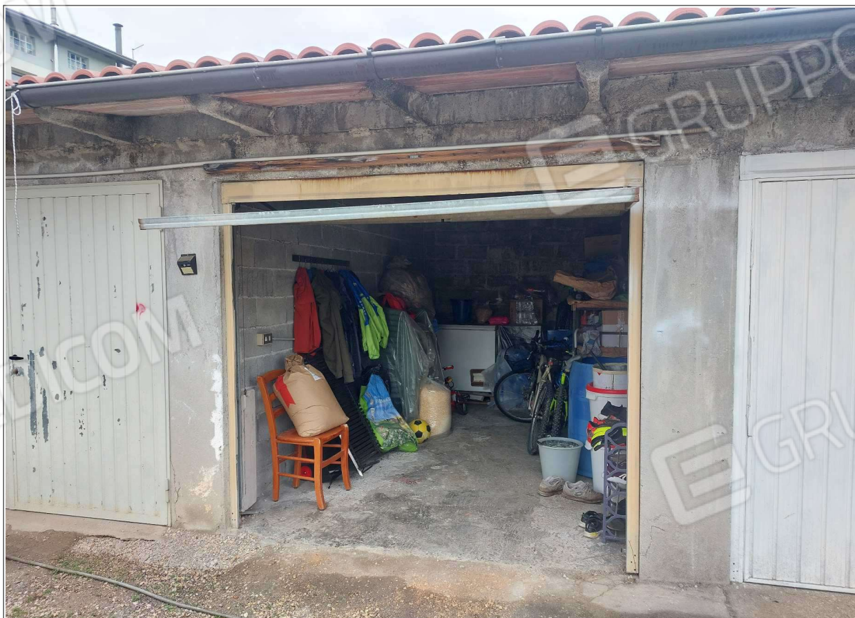
Foto n° 26 – 16/04/2025 - Comune di Maniago, foglio 21, part.54, sub.5 – Tettoia; accesso.
