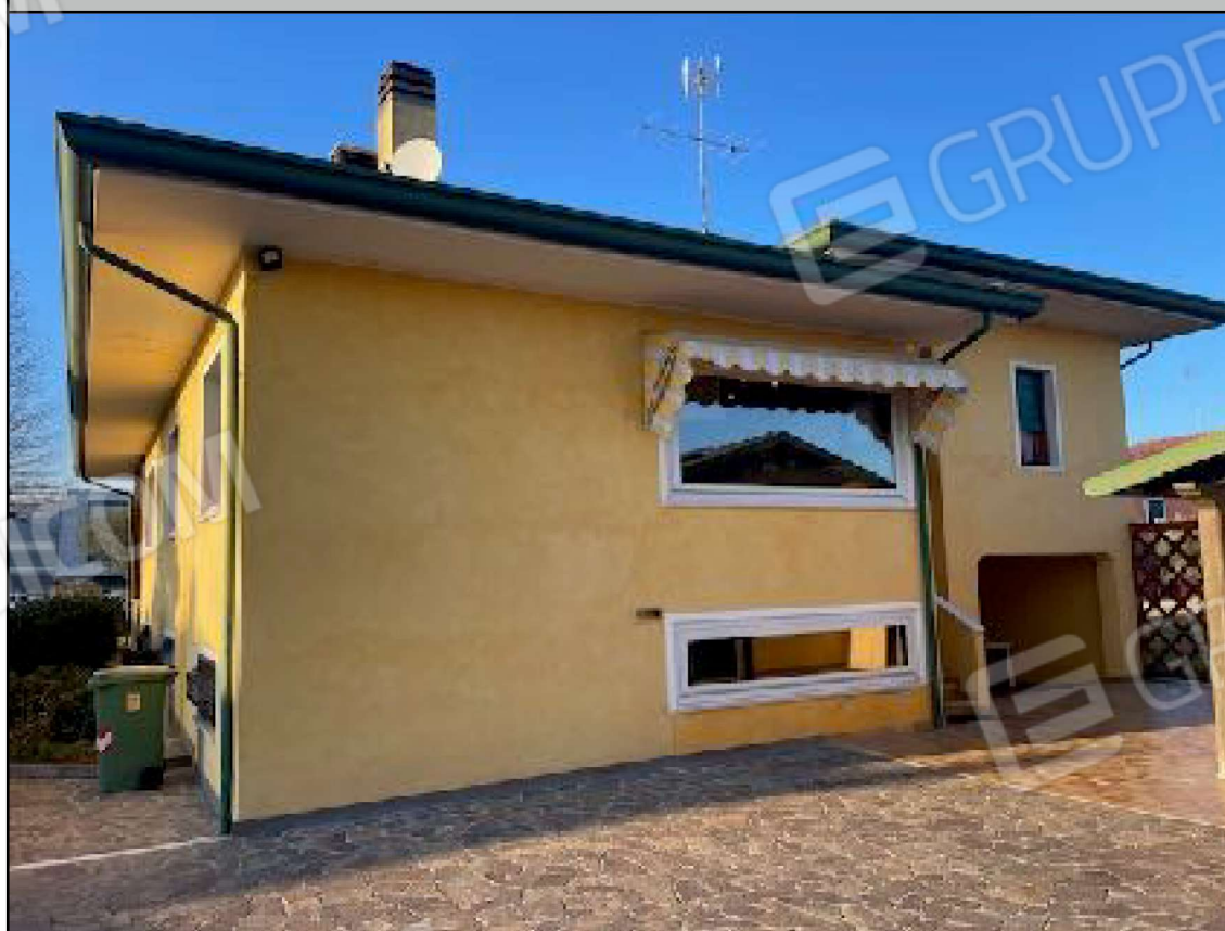
Vista casa dal lato Nord
