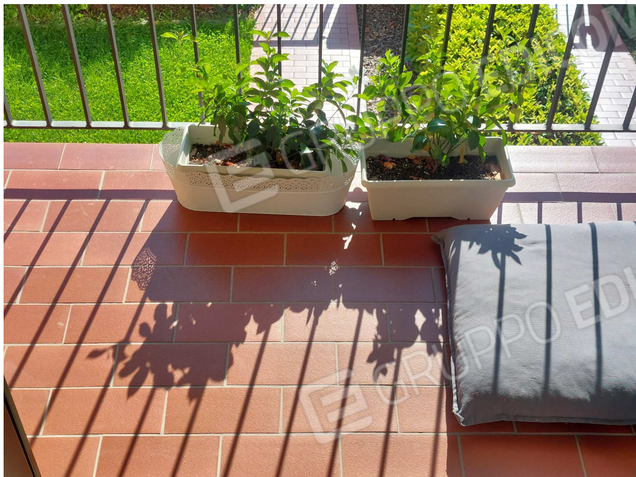
Foto n° 12 – 03/10/2025 - Comune di Brugnera, foglio 23, part.521, sub.10 - P1 – Terrazza, lato sud.
