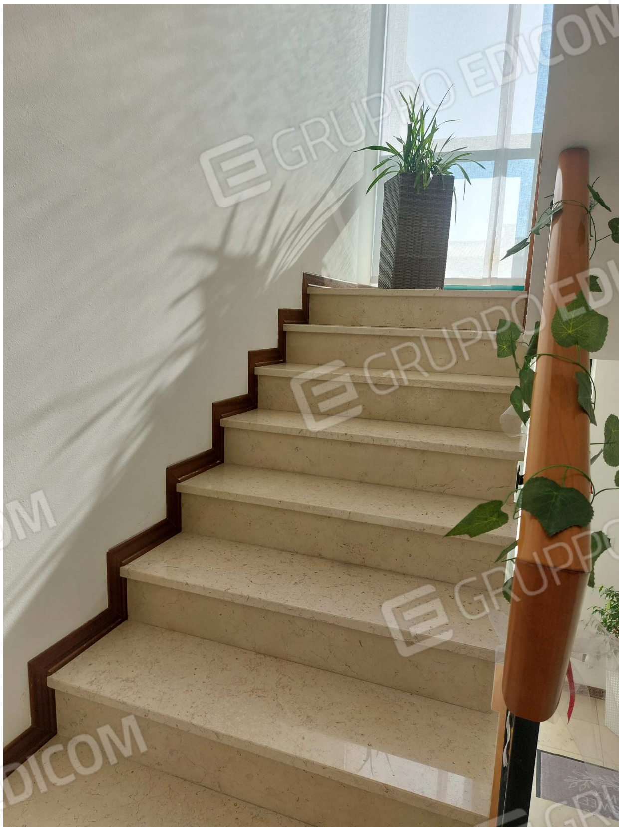
Foto n° 3 – 03/10/2025 - Comune di Brugnera, foglio 23, part.521, sub.10 – Scale interne che collegano i piani S1-PT-P1.
