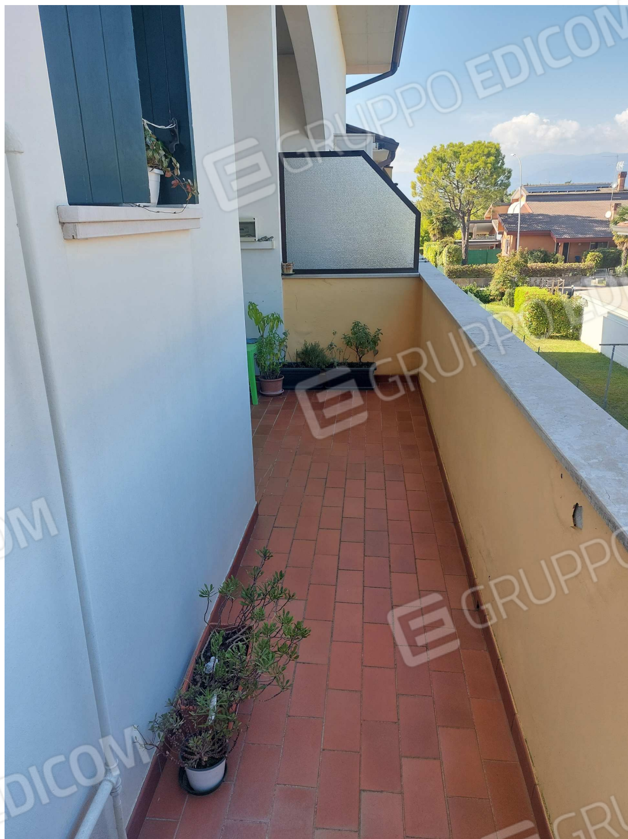
Foto n° 11 – 03/10/2025 - Comune di Brugnera, foglio 23, part.521, sub.10 - P1 – Terrazza, lato nord.
