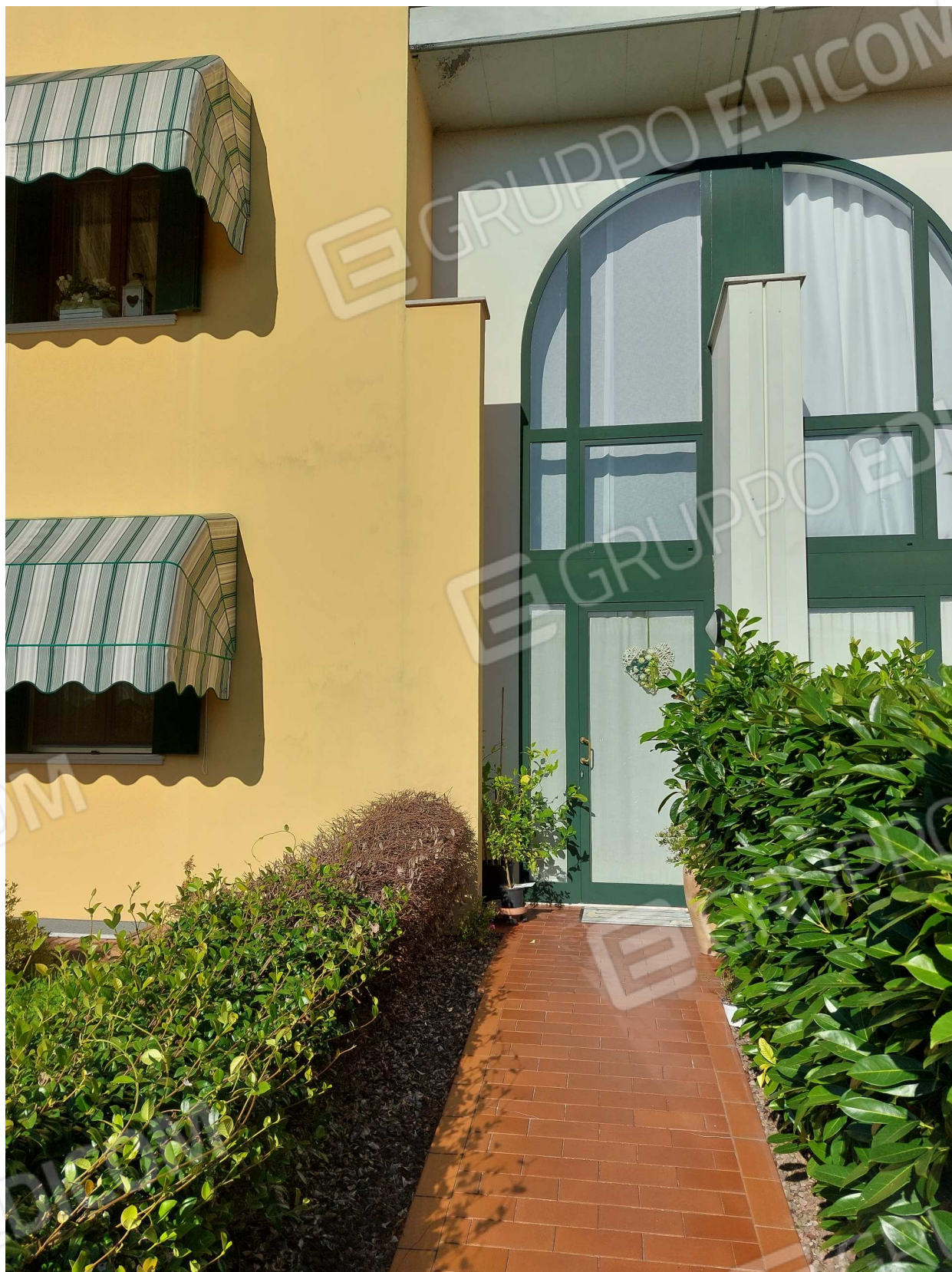
Foto n° 2 – 03/10/2025 - Comune di Brugnera, foglio 23, part.521 – Portoncino di accesso dell'immobile pignorato.
