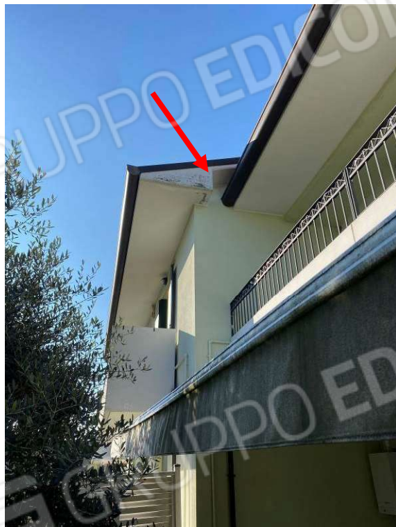
viste degrado della tinteggiatura esterna
