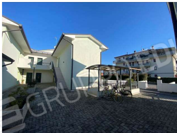
vista scala esterna coperta di accesso alle autorimesse
