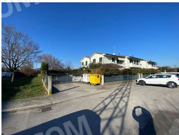
vista passo carraio delle autorimesse
