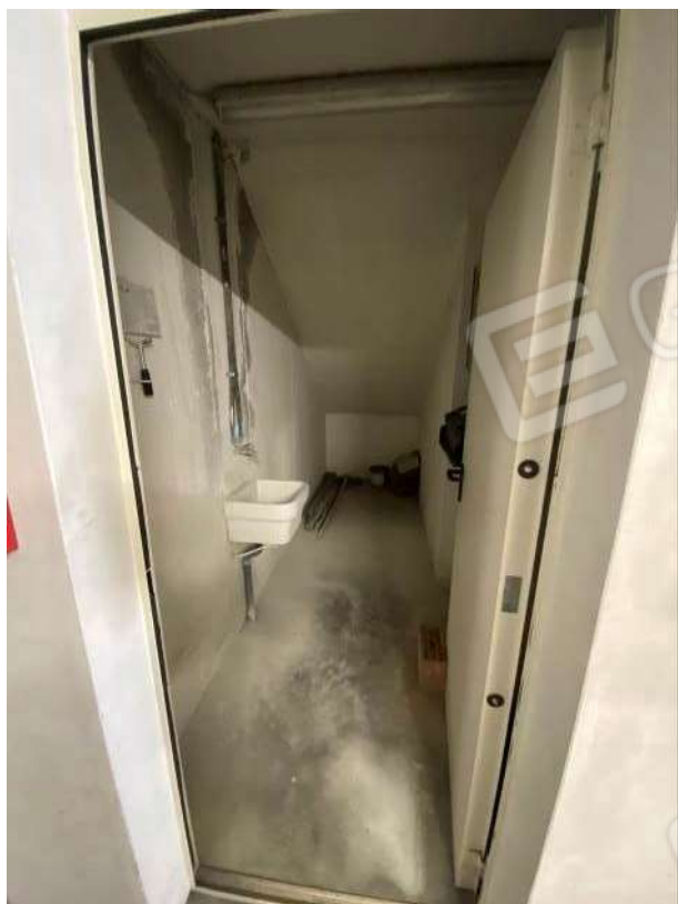
vista locale accessorio ad uso comune sub.46
