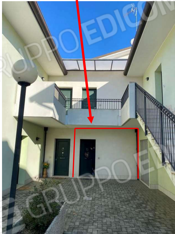
vista ingresso dal cortile comune condominiale
