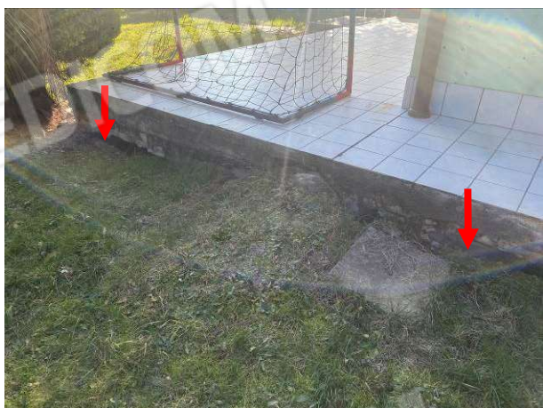
ulteriori viste cedimento terreno circostante al fabbricato di circa 25 cm
