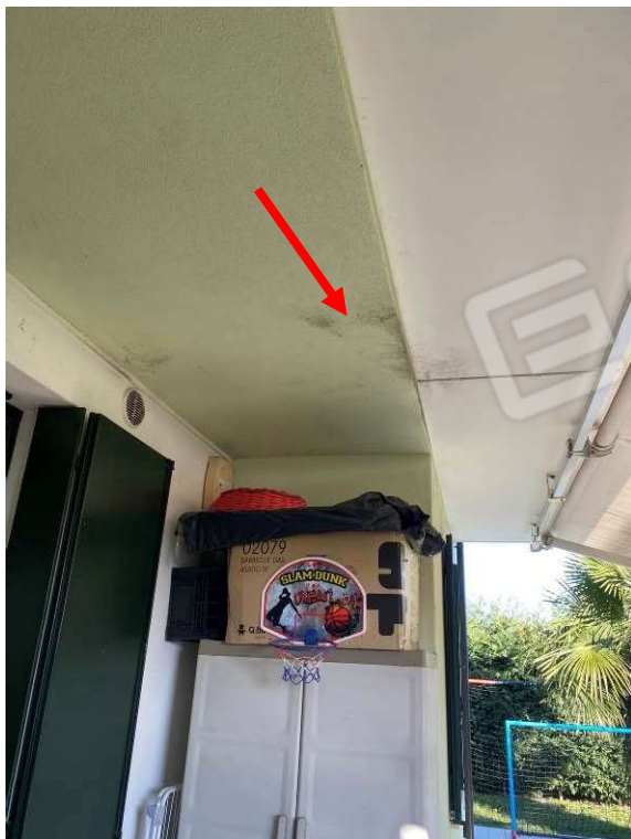
viste degrado della tinteggiatura esterna
