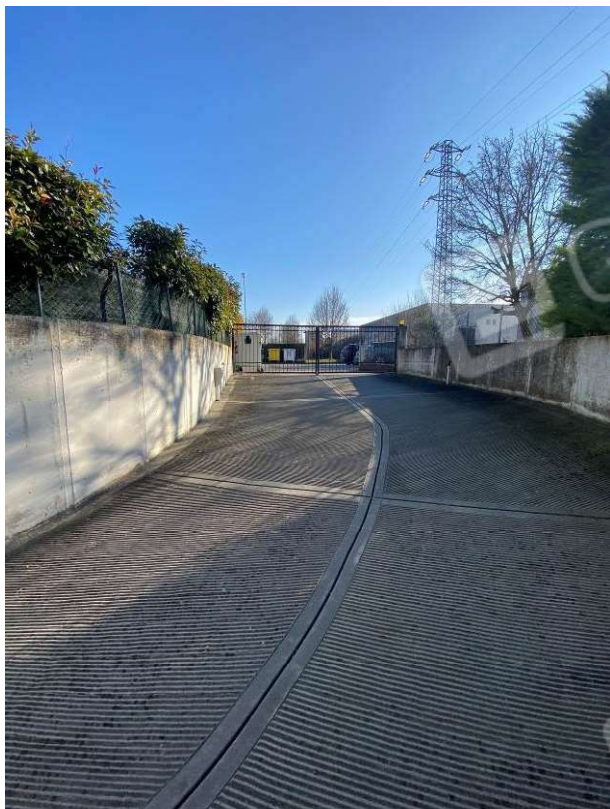
vista rampa e cancello carraio delle autorimesse
