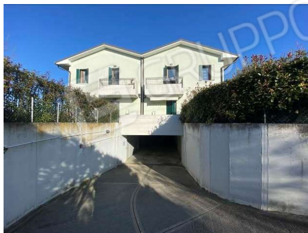
vista rampa d'accesso alle autorimesse
