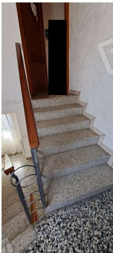
15_vano scala piano primo
