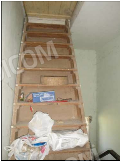
FOTO N. 3 SCALA ACC. SOTTOTETTO
