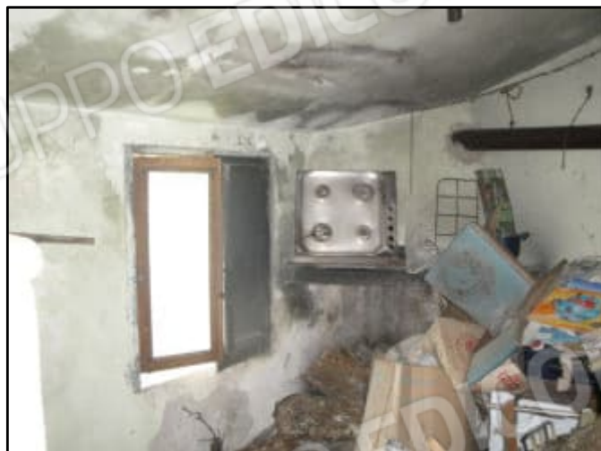
FOTO N. 8 RIPOSTIGLIO - FORNO - LEGNAIA
