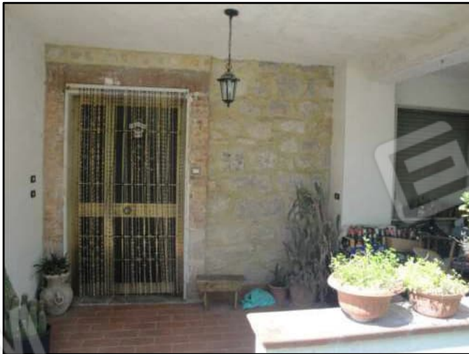
FOTO N. 1 PORTONE INGRESSO ZONA "A"
