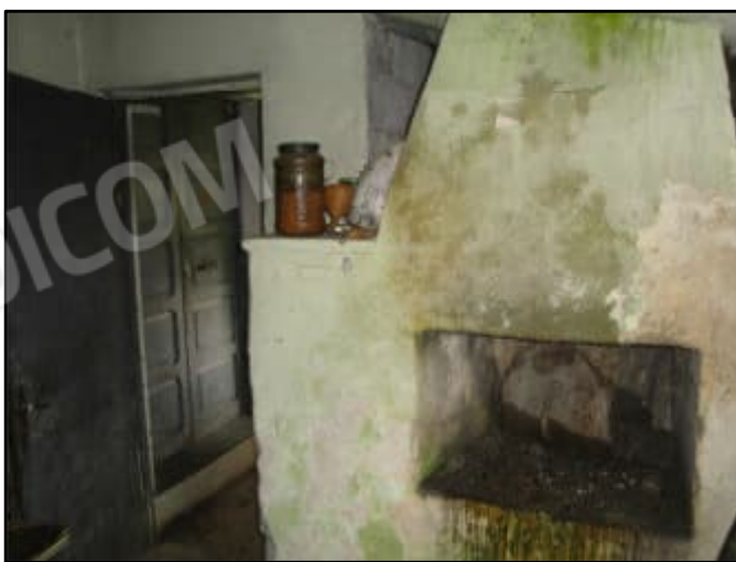
FOTO N. 9 RIPOSTIGLIO - FORNO - LEGNAIA
