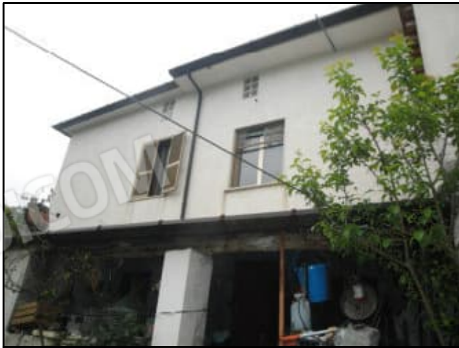
FOTO N. 6 bis PROSPETTO SUD-OVEST
