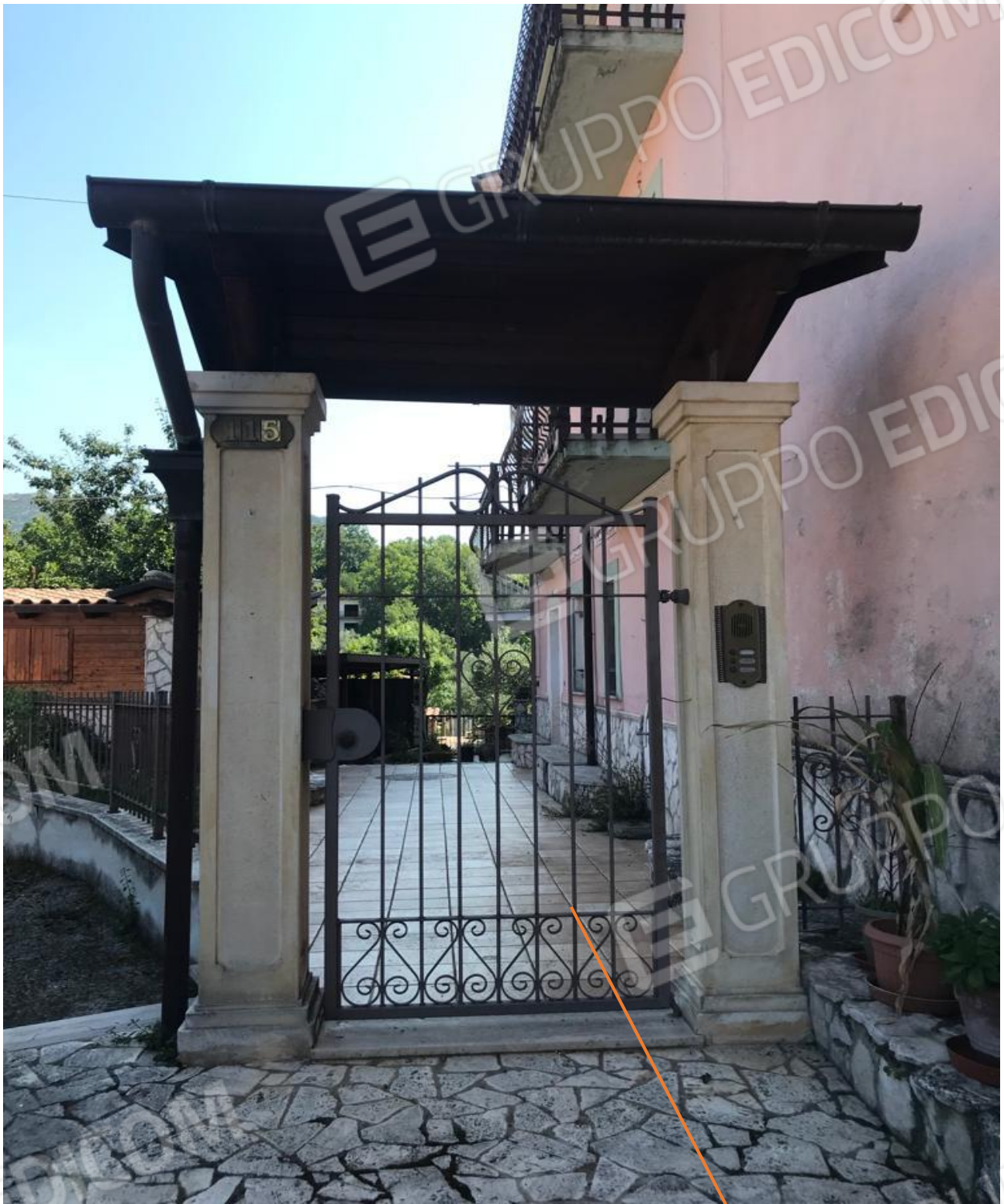
Foto n. 2 – Ingresso corte comune
