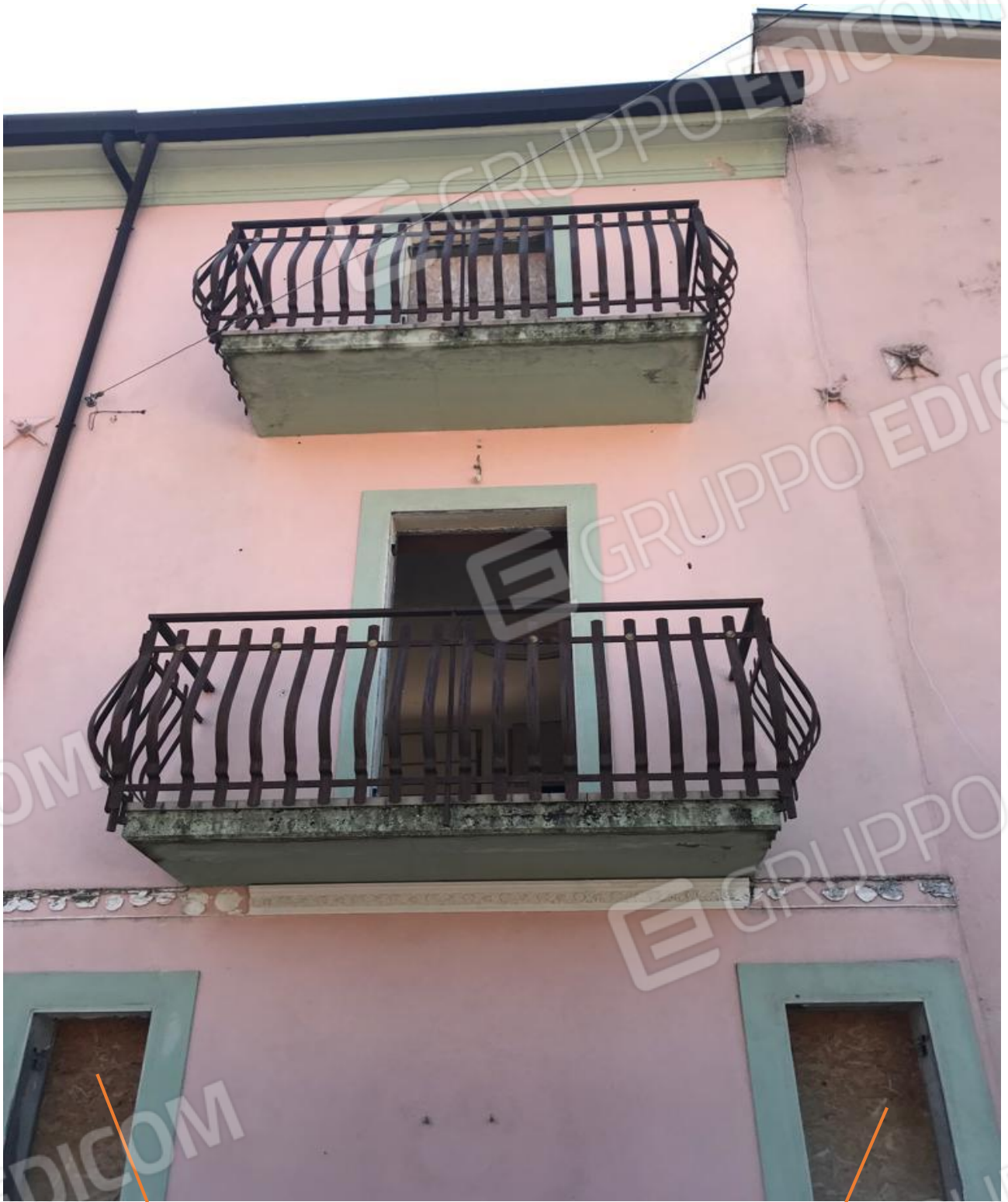
Foto n. 4 – Finestre con pannelli in legno pressato
