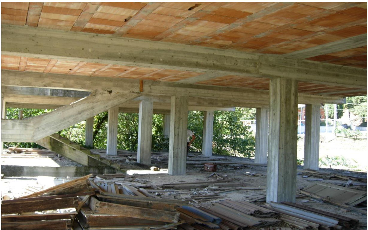
FOTO 3 C – LOTTO 3 – SORA, VIA PESCOSOLIDO, FOGLIO 13, PARTICELLA 292
