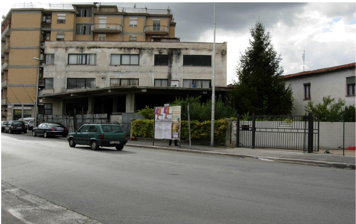
LOTTO 6 B – SORA – VIA MARSICANA, FOGLIO 22, PARTICELLA 503 SUB 3
