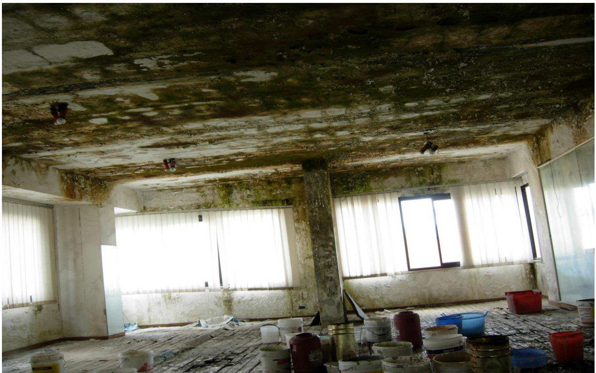
FOTO 2 E – LOTTO 2 – SORA, VIA MARSICANA, FOGLIO 22, PARTICELLA 460
