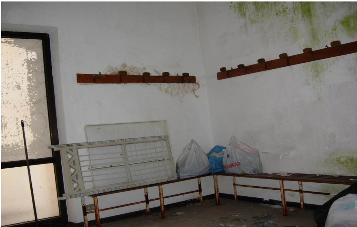
FOTO 2 C – LOTTO 2 – SORA, VIA MARSICANA, FOGLIO 22, PARTICELLA 460
