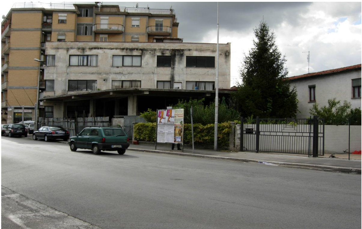
FOTO 4 A – LOTTO 4 – SORA, VIA MARSICANA, FOGLIO 22, PARTICELLA 460 SUB 6
