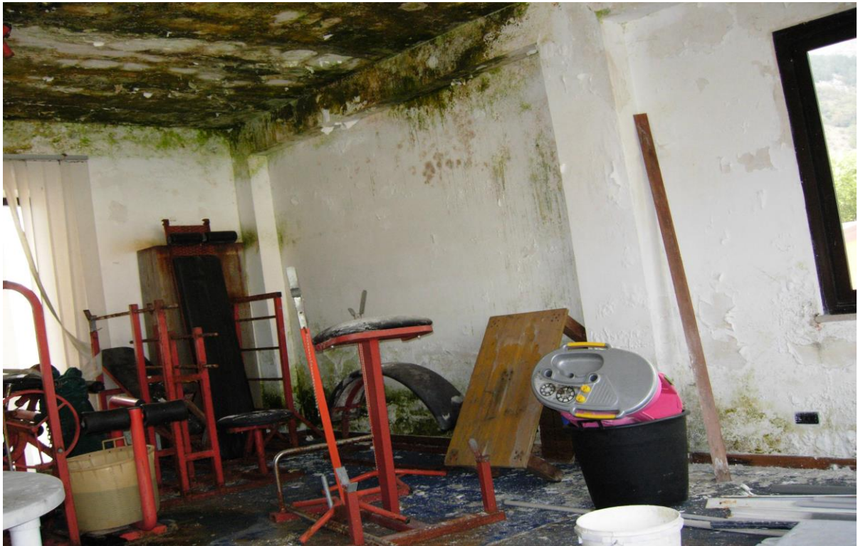
FOTO 2 E – LOTTO 2 – SORA, VIA MARSICANA, FOGLIO 22, PARTICELLA 460
