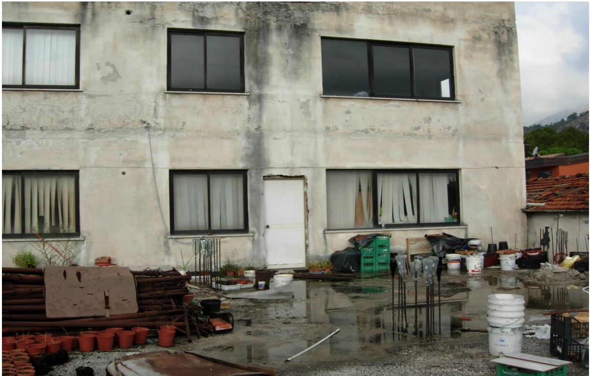
FOTO 4 B – LOTTO 4 – SORA, VIA MARSICANA, FOGLIO 22, PARTICELLA 460 SUB
