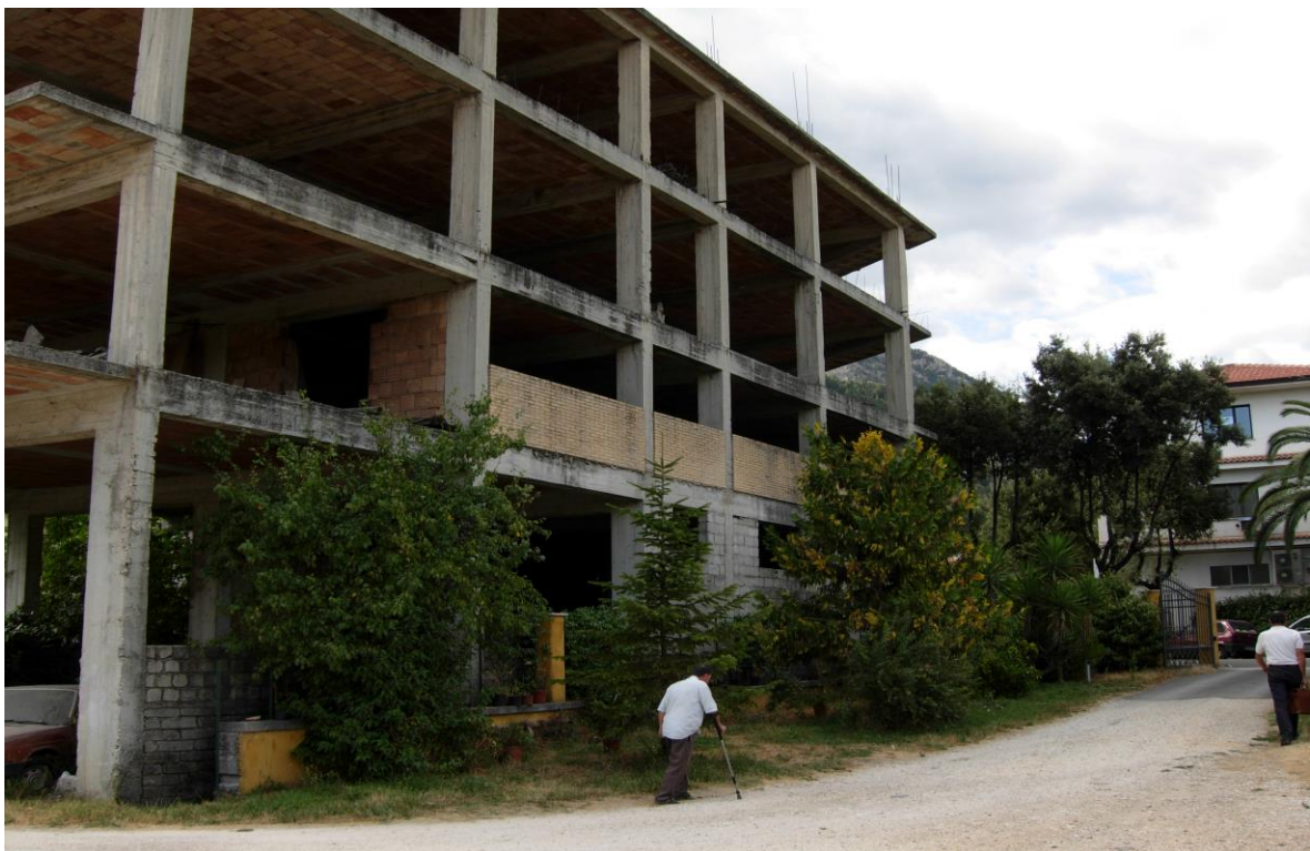
FOTO 1 B – LOTTO N.1 – SORA, VIA MARSICANA – BUONCONSIGLIO, FOGLIO 23, PARTICELLA 409
