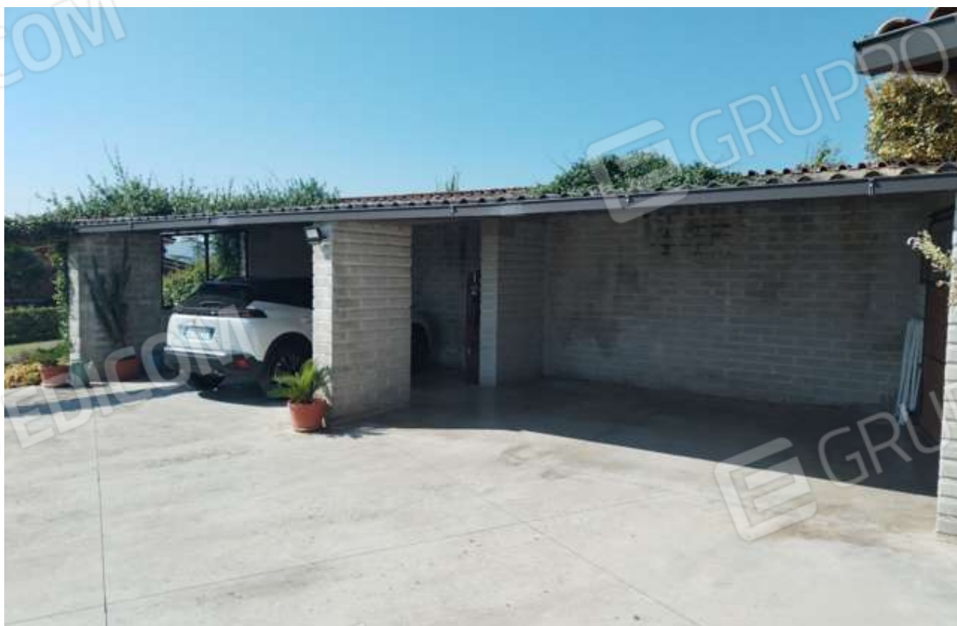
Foto n.6 – Vista esterna immobile pignorato (porticato auto da demolire)
